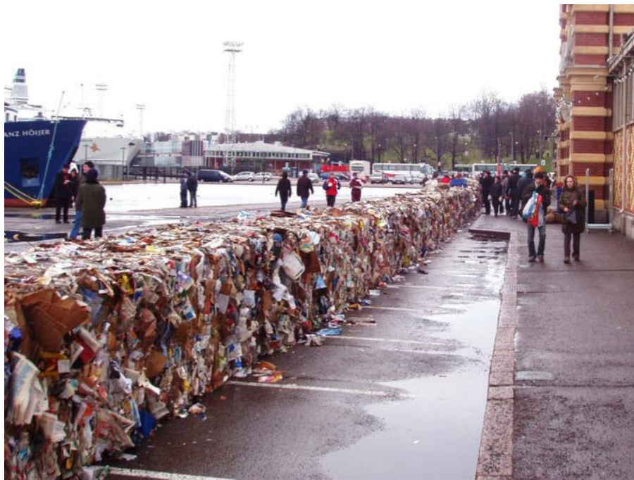
Kuva 34. Tulvamuuri kierrätyspahvipaaleista. Kuva: Helsingin kaupungin pelastuslaitos.
