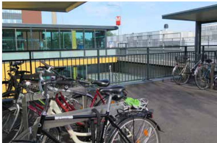
Myllypuron metroaseman sivusisäkäykänti.
