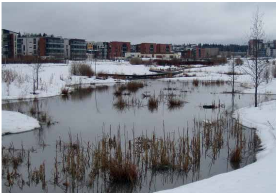
Kuva 9. Taajamatulvien säätelyä varten on syytä varata tulva-alueita, jotka tasaavat purojen virtaamavaihteluja. Kuvassa vesi nousee hallitusti Viikin ekorakentamisalueelle tehdyille Viikinojan tulvatasanteelle talvella 2006. Kuva: Jukka Jormola.
