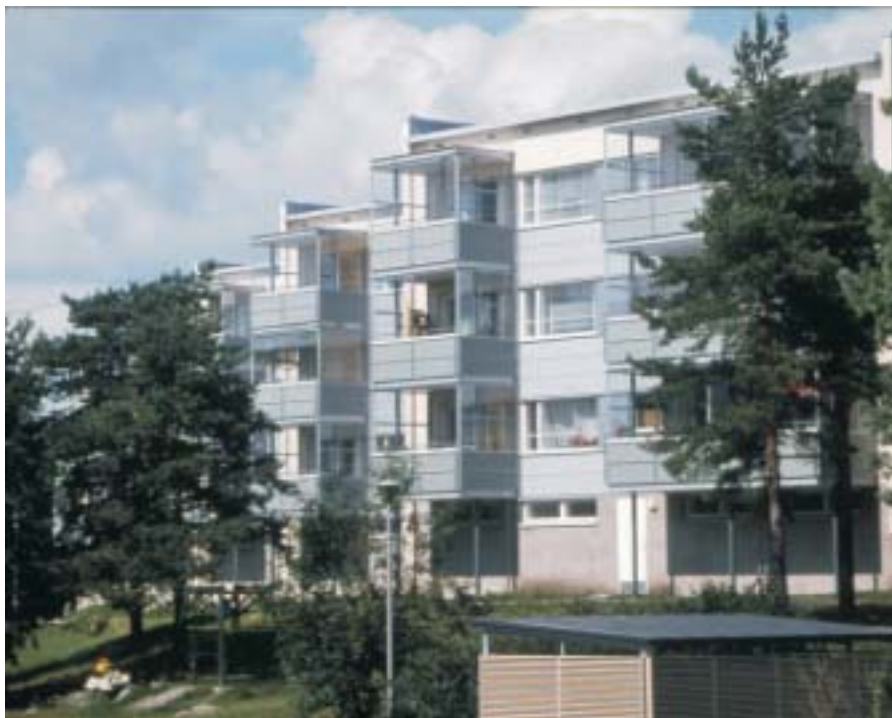
Peruskorjattuja kaupungin vuokra-asuntoja Jakomäessä. Kuva: Ifa Kytösaho (Att).
