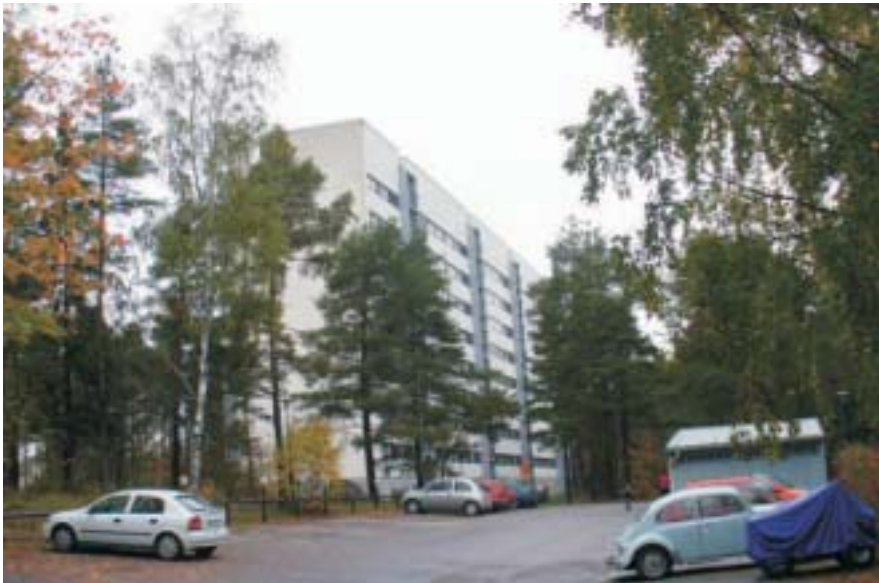
Kaupungin peruskorjattu vuokra-asuntoja Kontulassa (Sakara 2). Kuva Erkki Korhonen.
