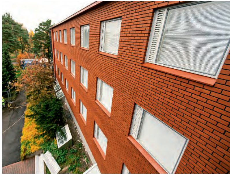
Roihuvuoren palvelukeskuksen julkisivuremontissa vanha tiiliverhoilu korvattiin uusilla tiilielementeillä.
