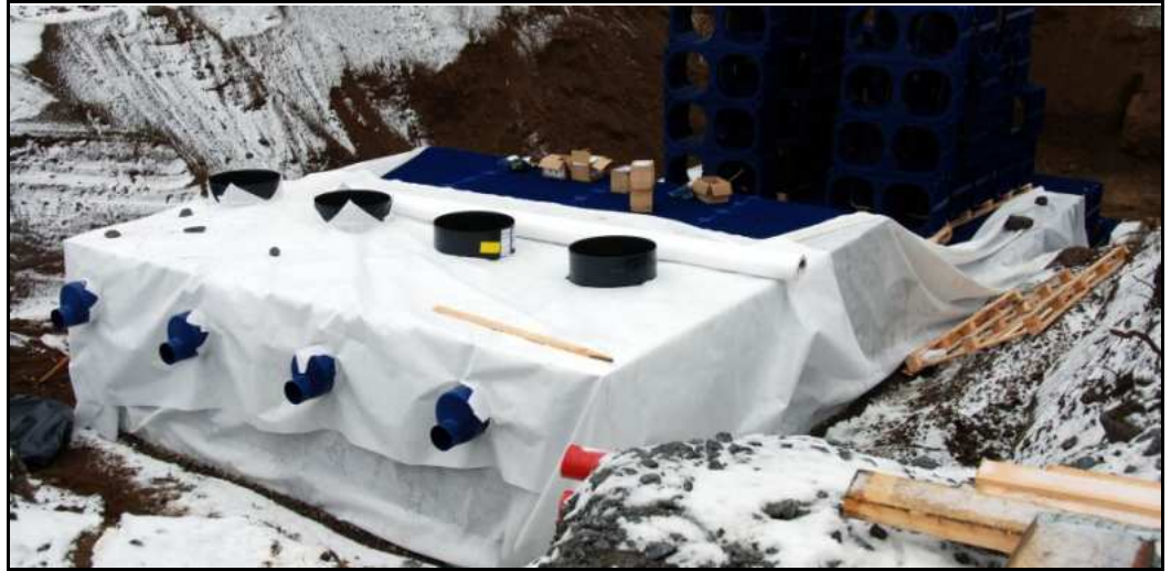
Kuva 32. Maanalaisen 300 m 3 kennoston rakentamista Tampereella 21
