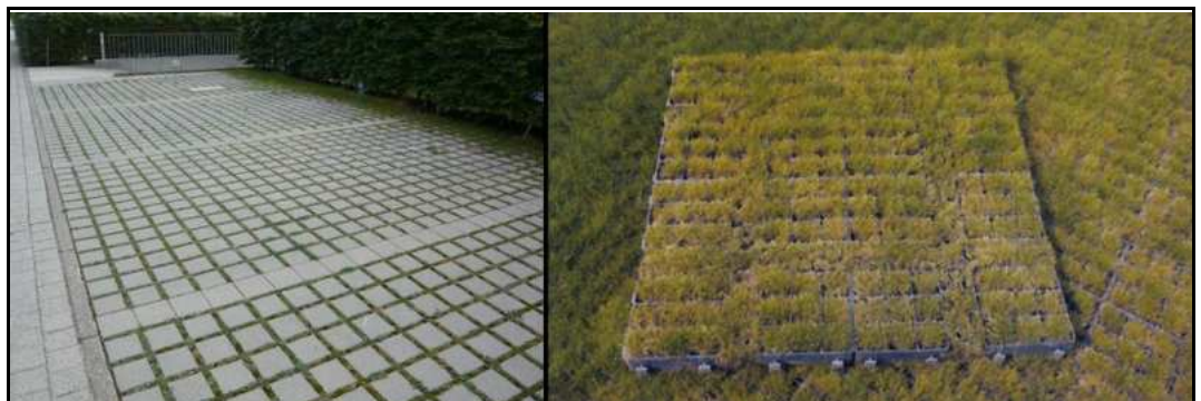
Kuva 28. Esimerkkejä läpäisevistä päällysteistä. Vasemmalla väljästi saumattu kiveys 7 ja oikealla vahvistettu numirakenne. 18
