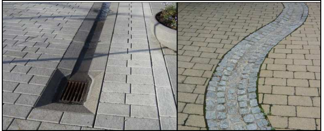
Kuva 30. Esimerkkejä korkeatasoiseen hulevesien pintaohjaukseen.
