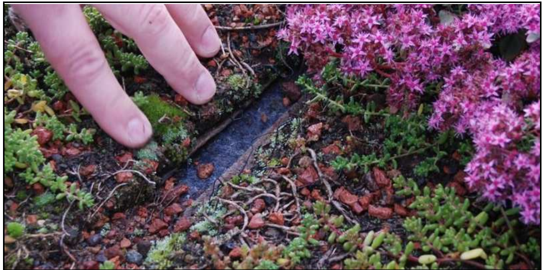
Kuva 22. Esimerkki ohuen sammalmaksaruohokaton rakenteesta Suomen olosuhteissa. Kohde on Espoon Solvallen urheiluopisto. Vesieristeen päällä juurenestomatto, salaojamatto, geoverkko sekä kasvu- ja kasvillisuuskerros. 7
