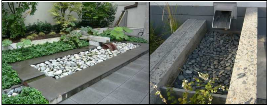
Kuva 27. Kattovedet johdetaan kivipesiin ja näistä istutusalueille. Järjestelmä on osa piha-alueen laadukasta viherrakentamista. 7
