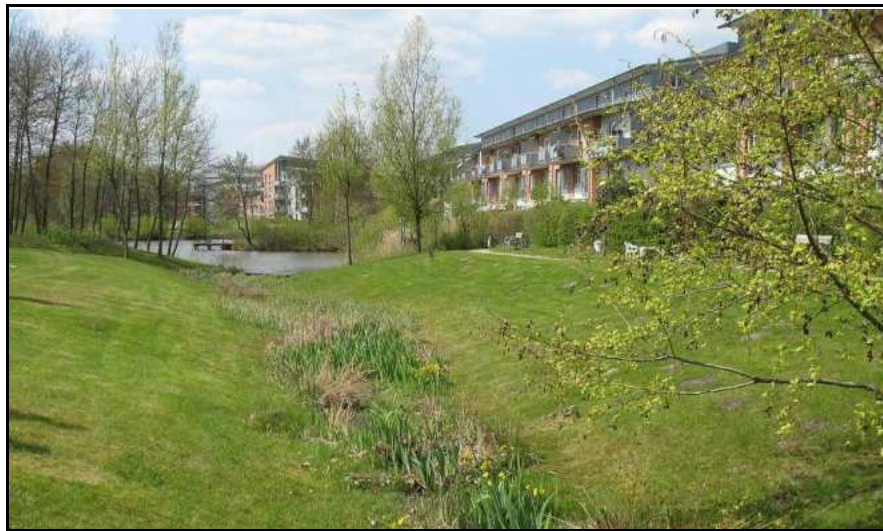
Kuva 37. Hulevesiä johtava viherpainanne puistossa. 7
