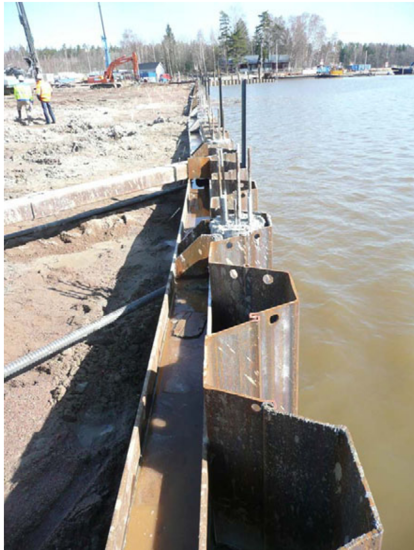
Kuva 16. Paalu-ponttirakenteinen reunamuuri Sipoonrannassa, tausta syvästabiloitu. Teräsrakenteet päällystettiin betonilla. (Kuva: FCG)
