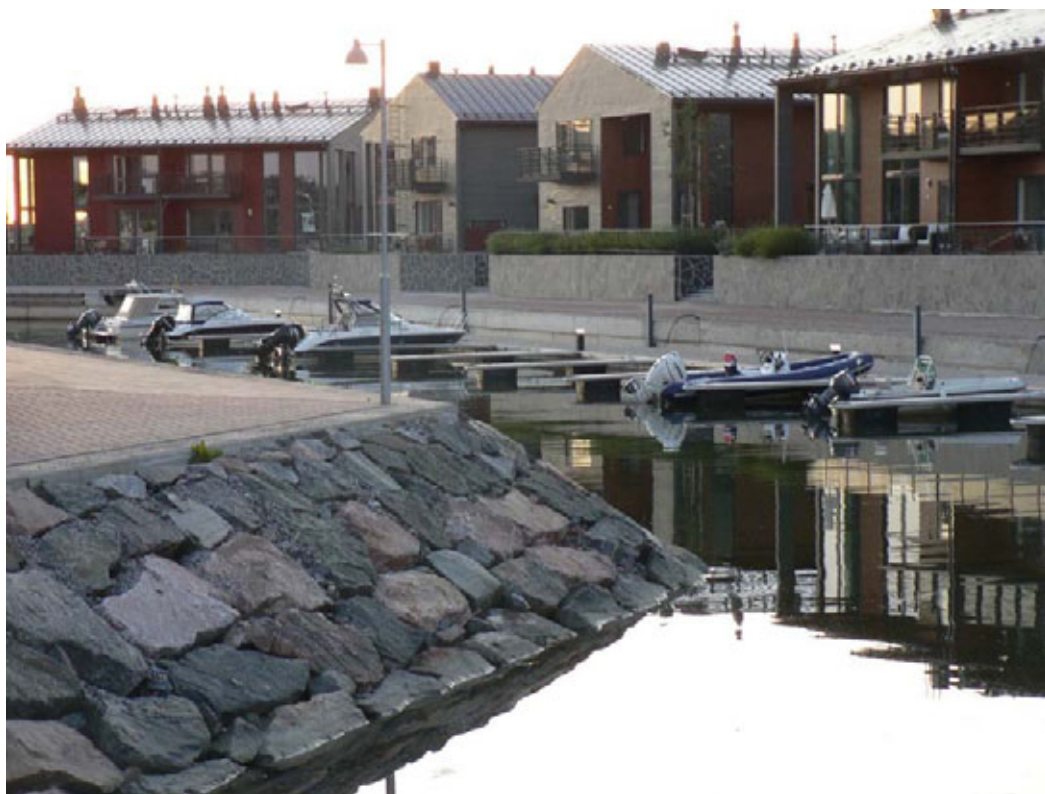
Kuva 17. Reunamuuria ja louheverhoiltua luiskaa Herttoniemenrannassa (Kuva: FCG)
