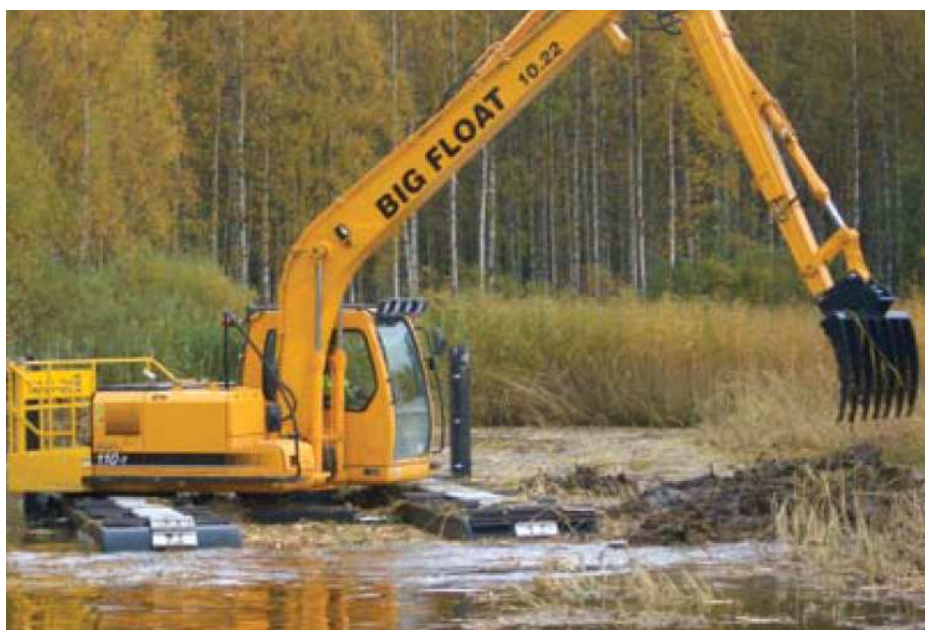
Kuva 11. Ruoppaus voidaan tehdä esim. kelluvalla Big Float -kaivinkoneella. (Kuva: Remu)
