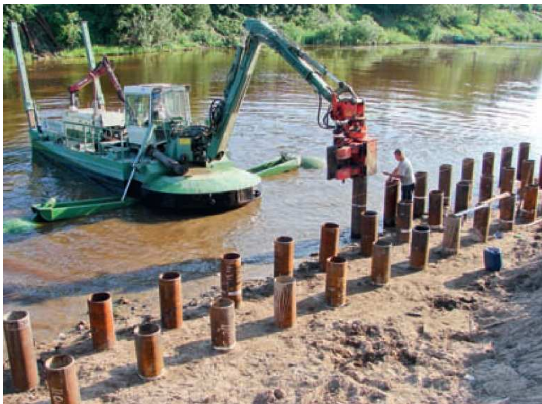
Kuva 18. Paalujen asennusta Watermaster -ruoppausalukseen asennetulla pontiniskijällä (Kuva: Movax Oy)
