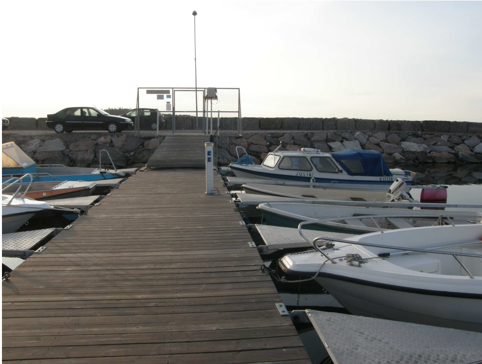
Kuva 11. Svinvikenin purjevenesatamaan rakennetaan ponttoonilaiturit (Kuva: Harri Vehmas)
