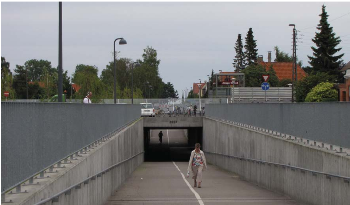
Kuva 8. Metron alikulku Kööpenhaminassa.
