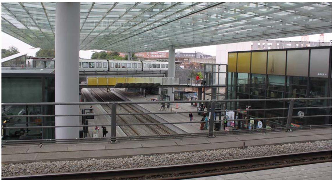
Kuva 6. Flintholmin asema Kööpenhaminassa, missä risteävät metro ja kaksi rautatielinjaa.
