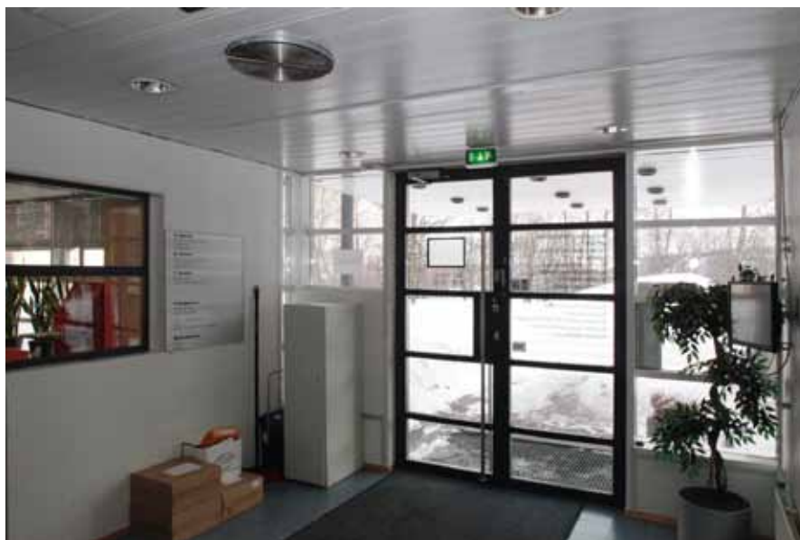
Aula on rakennettu 1980-luvun lopulla. Sieltä on käynti kirjastoon ja pääportaaseen. Kulmahuoneeseen, joka muutettiin 1980-luvulla toimistoksi, on sittemmin sisustettu info-piste (2000-l). Aulan katto on alaslaskettu metallikasettikatto, johon on upotettu valaisimia. Lattiassa on siniharmaa klinkkeri.
