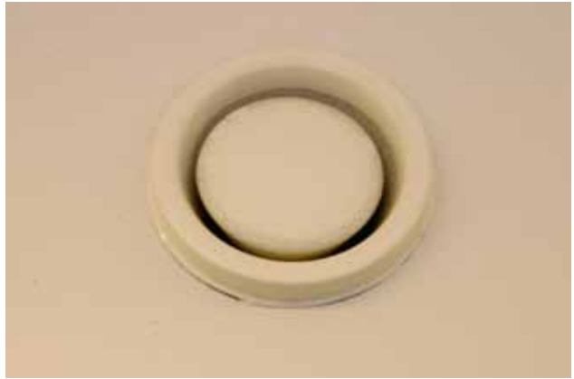
Uudempi lautasventtiilimalli todennäköisesti 1980-luvulta.
