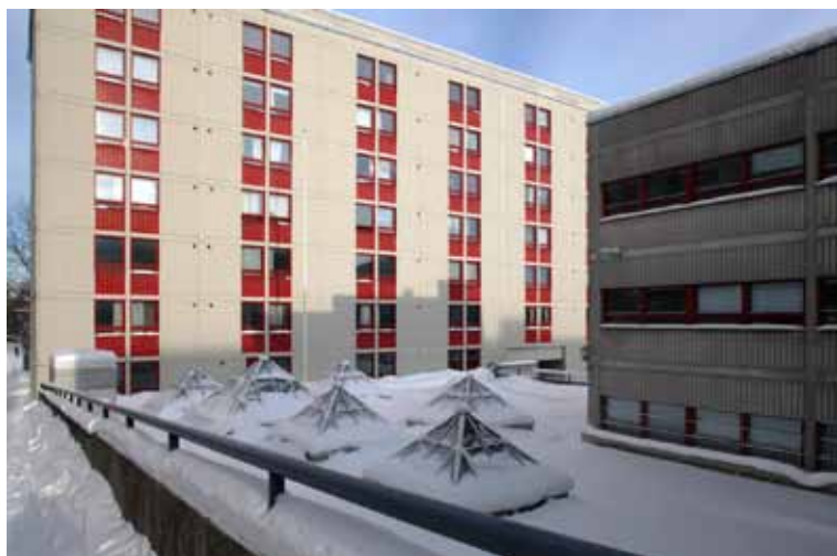
HOASin asuntolan julkisivut on kunnostettu pinnoittamalla ne ohuella, alkuperäistä vaaleammalla laastikerroksella. Harmaan ja punaisen yhdistelmä on myös asuntolarakennukselle leimaa-antava piirre. Edustalla on näkyvissä lumiset kattolyhdyt.
