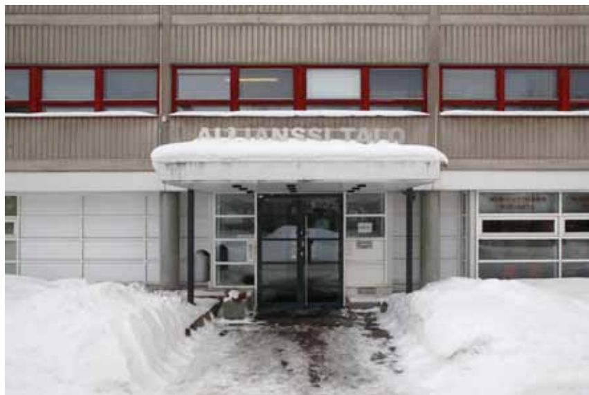
Pääsisäänkäynnin katos on rakennettu 1986.
