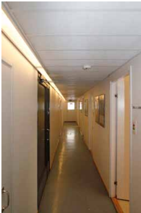
Myöhemmin lisätty tuulikaappi käytävän päässä, 1. kerros.
