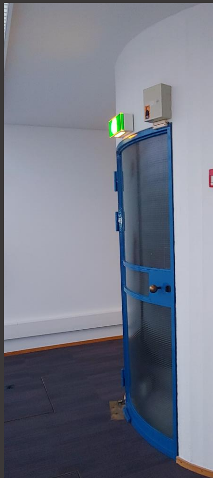
Sininen kaareva teräsovi poistumisportaan erikoisuutena
