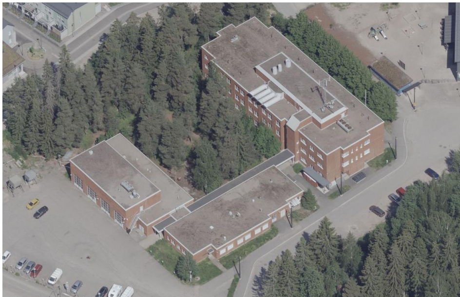
Kuva: Alueella sijaitsevat nykyiset rakennukset.
