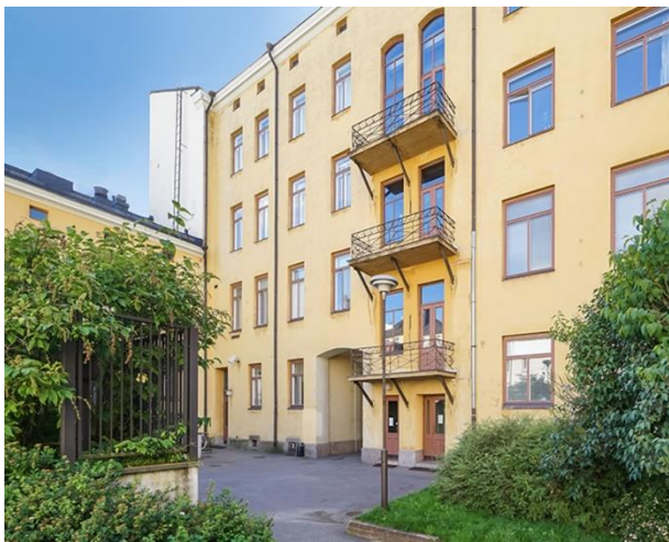
Sisäpihan puoli, sato.fi, 2017
