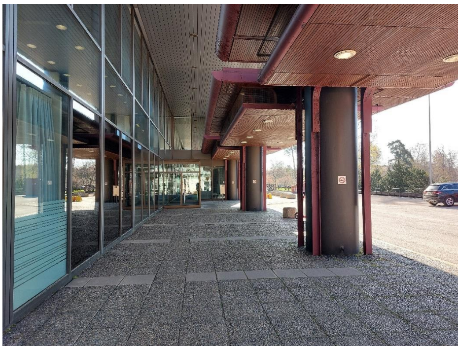
Sisäänkäyntiä korostavat komeat katokset ja suuret ikkunat.
