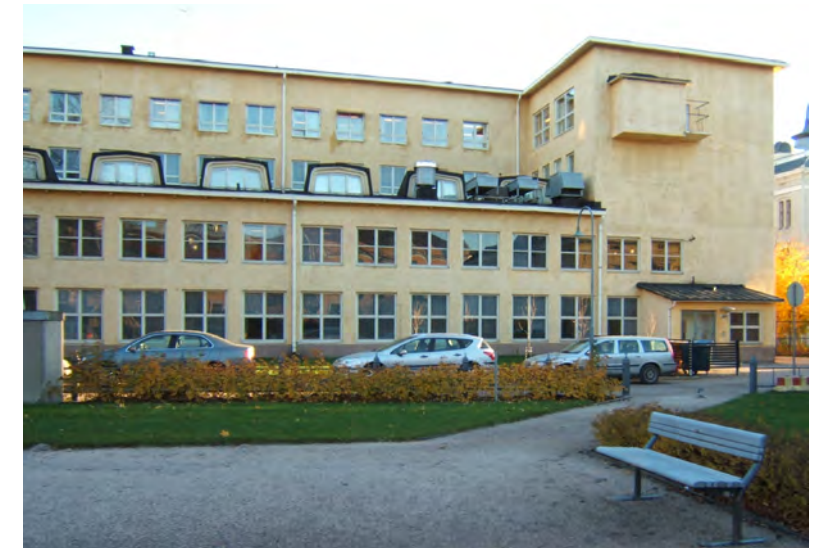
Pihanpuoleinen konepajasiipi yläikkunoineen
