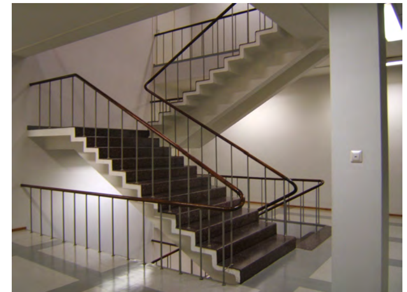
Pääporras, johon alun perin liittyi väljiä aulatilaja
