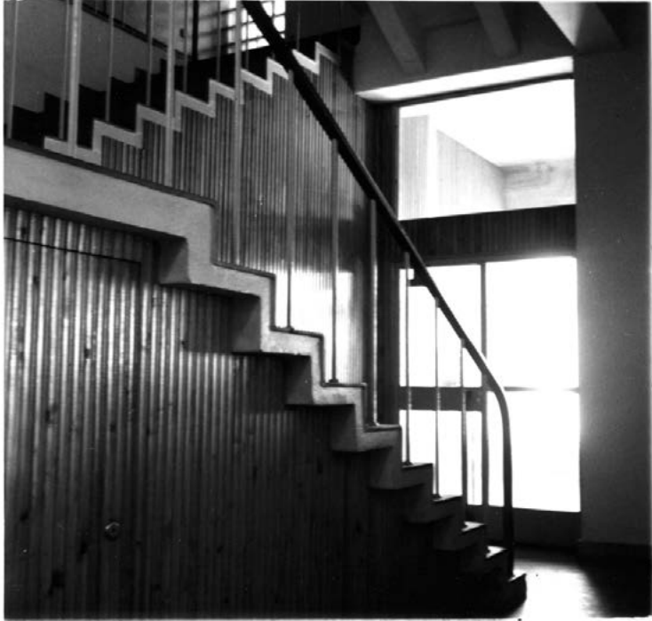
Pääsisääkäynnin portaikon alkuperäinen paneliverhous. VTT
