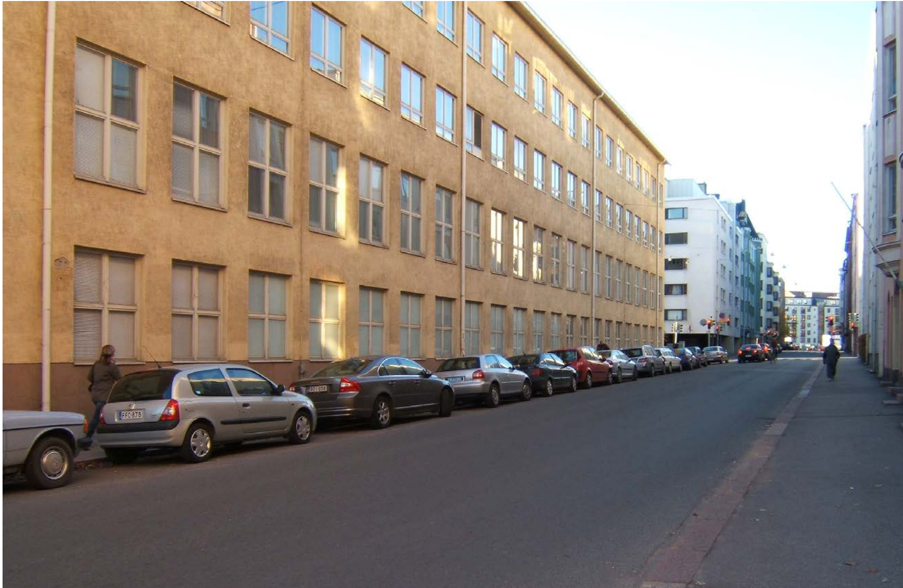
Abrahaminkadun julkisivu. MSKS 2007
