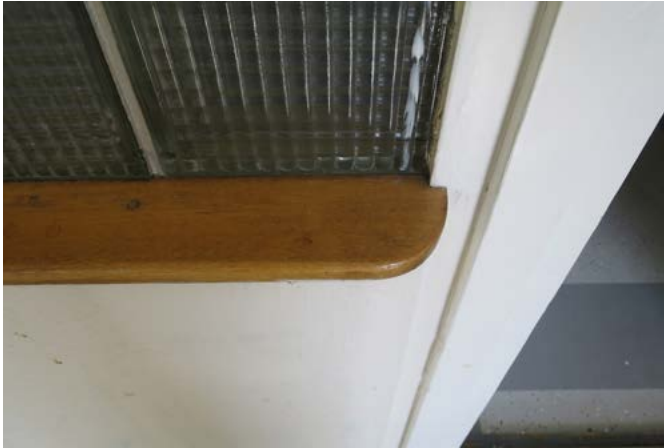
Eteläsivun jälkikäteen rakennetun väliseinän yksityiskohta, 4. krs
