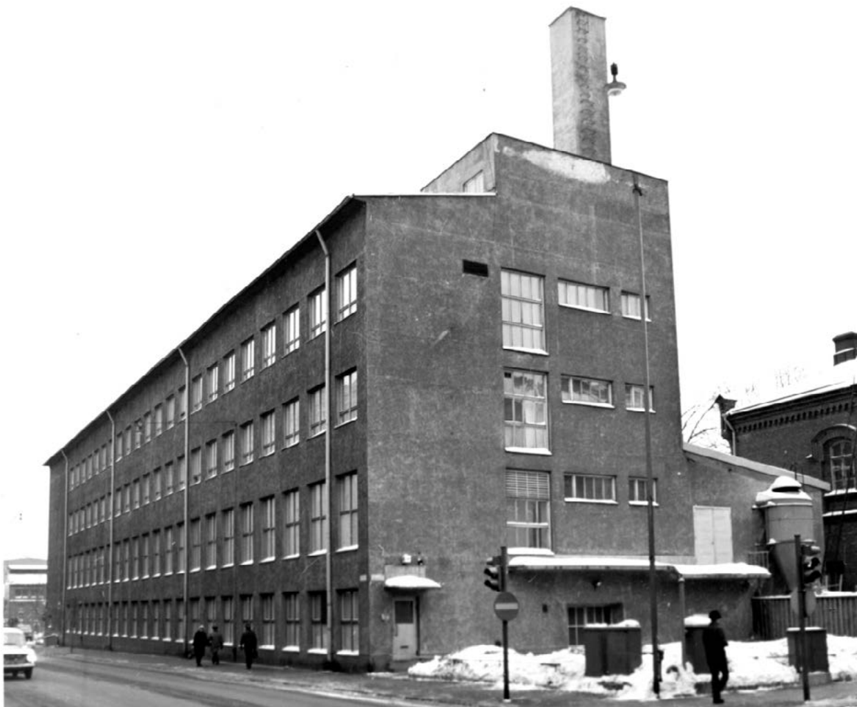
Abrahaminkadun ja Kalevankadun julkisivut, arkistovalokuva VTT
