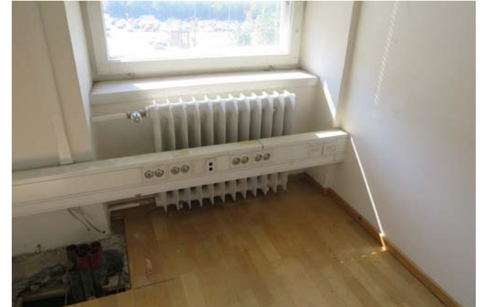
Johtokourun takana alkuperäinen lämpöpatteri
