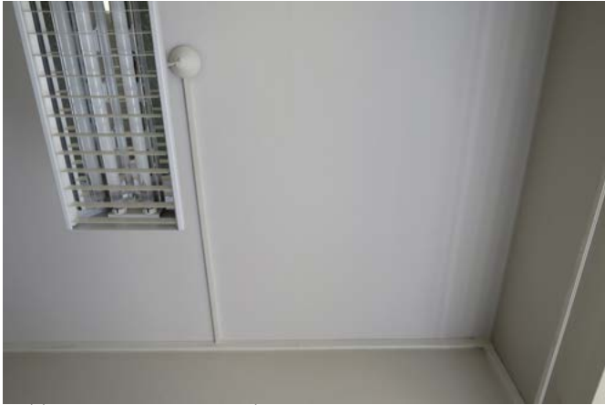
Sähkön pinta-asennus, 4. krs
