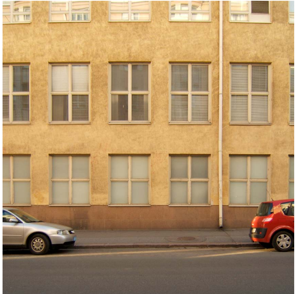
Abrahaminkadun julkisivu. MSKS 2007
