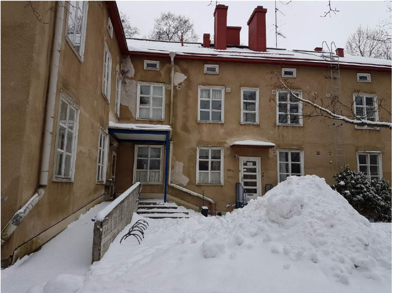
Rakennuksen sisänurkka, helmikuu 2017. Katoksen yläpuolelta rappaus on monin paikoin pudonnut. Luiskan betonikaide on huonossa kunnossa, ja portaiden saumoissa on rapautumista.
