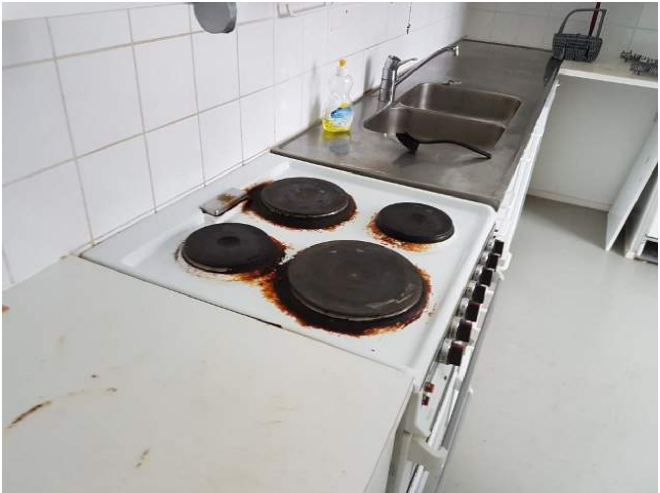
Kalusteet ja laitteet ovat ikääntyneitä ja kuluneita. Helmikuu 2017.
