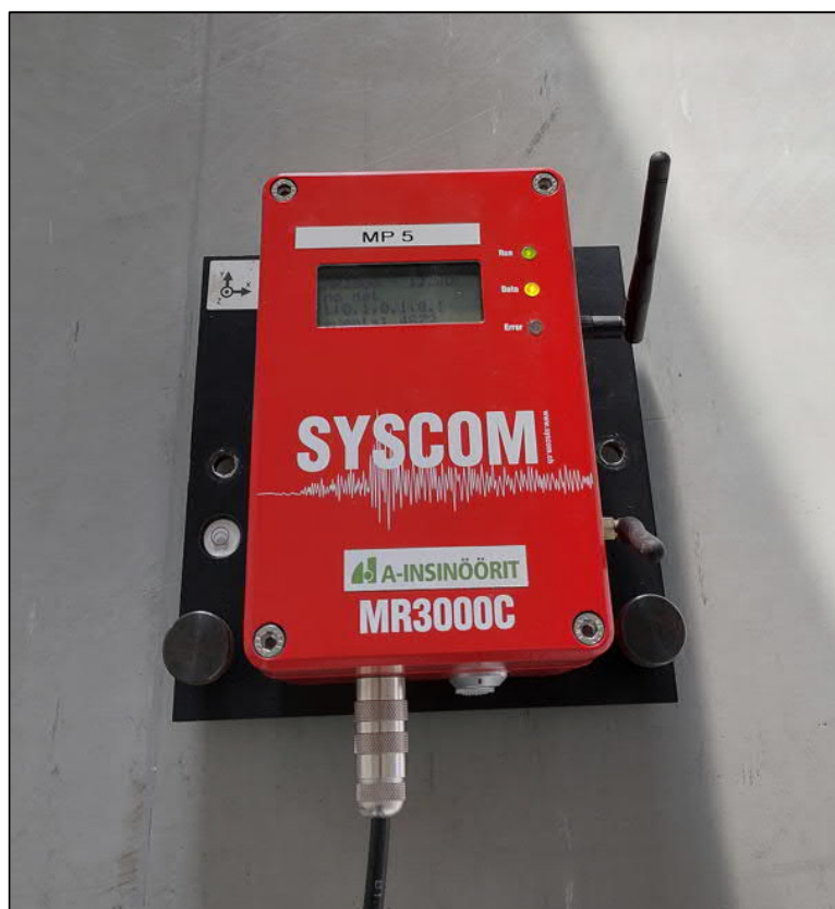
Kuva 5.3. Värähtelymittarin asennus lattialle.
