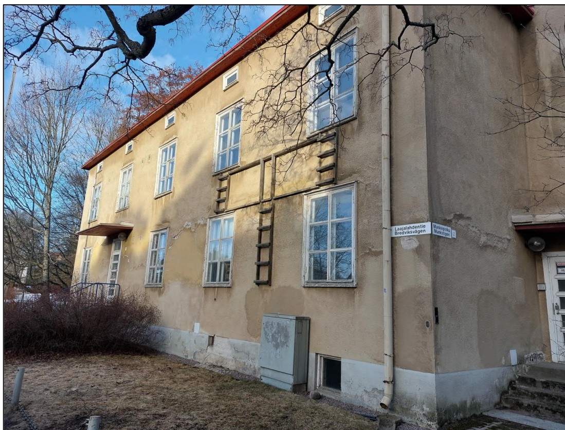
Kuva 1.2. Rakennuksen julkisivua Laajalahdentien puolelta.
