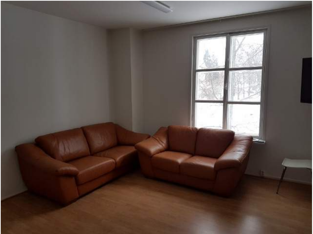
Myöhemmin ilmeisesti vanhan muovimaton päälle asennettu laminaatti toisessa kerroksessa. Helmikuu 2017.
