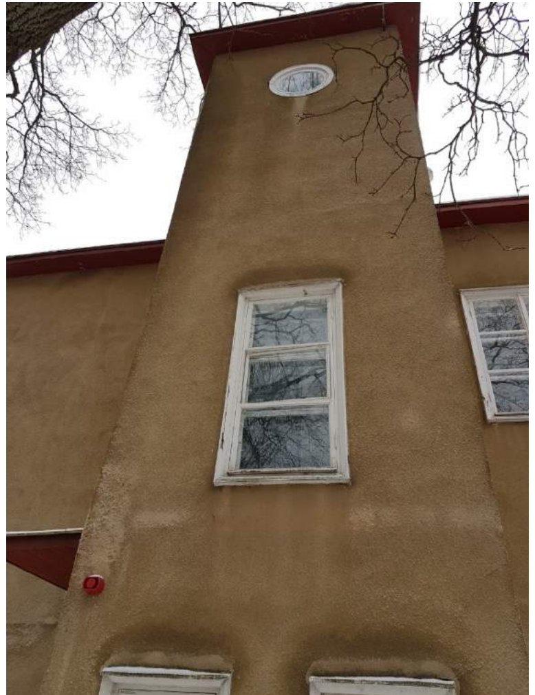
Koillispäädyn porrashuone, helmikuu 2017. Kulunutta rappautta, tornimaisen porrashuoneen yläosassa on nähtävissä 1920- ja -30 -lukujen taitteelle tunnuksenomainen pyöreä ikkuna.
