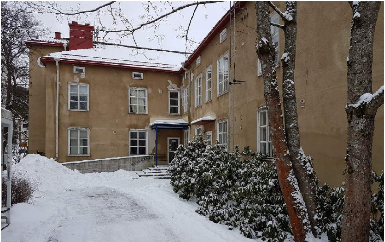
Julkisivut koilliseen ja luoteeseen, helmikuu 2017. Sisänurkan katoksen tienoilla rappaus on kaikkein huonoimmassa kunnossa.
