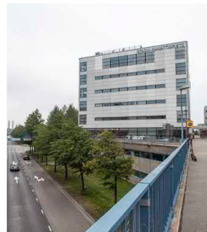
4. Veroviraston länteen suuntautuva kaksijakoinen ilme: maan tasolle avautuvien alimpien kerrosten osalta on päädytty pystyprofiiloituun, käsittelemättömään betoniin. Eloksoiduin alumiinilevyin päällystetty osuus nousee näkyville kansitason päältä. Puskurivyöhykkeenä Sörnäisten rantatietä vastaan on muodostettu laajahko nurmialue, johon on istutettu lehmukia ja lehtikuusia.
