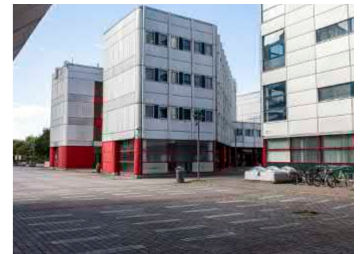
4. Kansirakenteen uusi kiveys tasasi alun perin rakennusta reunustavien kiveytyjen tasojen ja puhtaaksivaletun betonipinnan välisiä korkoeroja. Monivärinen kiveys luo alueelle erään sen harvoista ajallisista kerrostuksista.
