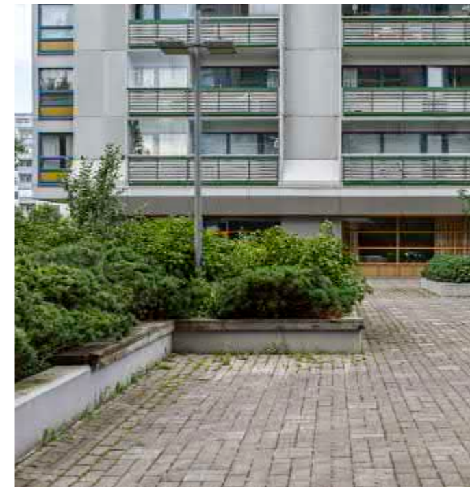
Istutuskaukaloiden on ajateltu toimivan myös penkkeinä. Kasvillisuus on kuitenkin päässyt tätä käyttötarkoitusta ajatellen turhan reheväksi. Penkkiä voi luonnehtia patinoituneeksi.
