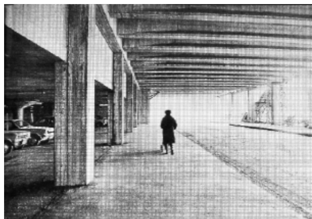
"Merihakaan ja sieltä pois johtaa betoninen tunneli"
