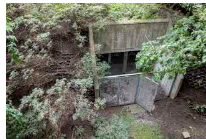
3. Merihaan väestönsuoja, joka sijoittuu maan alle Hakaniemen torin ja Merihaan väliselle alueelle valmistui vuonna 2003. Suojaan tuli tilat noin 6000 lähialueen asukkaalle. Normaalioloissa tilat palvelevat liikuntahallina, johon sisäänkäynti tapahtuu Hakaniemen torin itäpuolelta: maan alta löytyy mm. neljä salibandykenttää. Merihaan päähän, liittojen talon edustalle, valmistui maan tasoon jokseenkin maisemoitu "Porraskuulu B". Unhotuneen oloinen sisäänkäyntirakennus lienee tarkoitettu palvelemaan vain tositilanteessa. Suunnittelijatiedoista löytyy nimi L. Vahtera.
