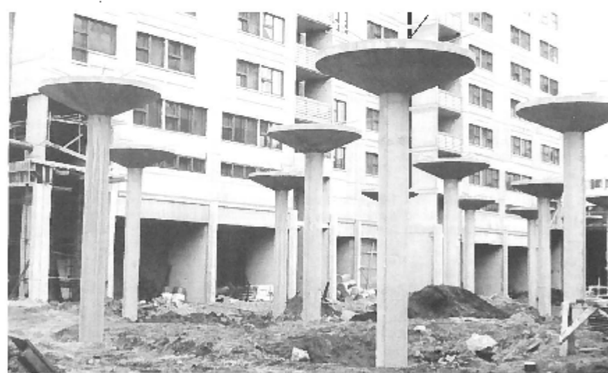
Rakenteilla olevat pöytäsovitteet ja muutamat siivoukset. (Kuva: Anne Kärräntinen)
