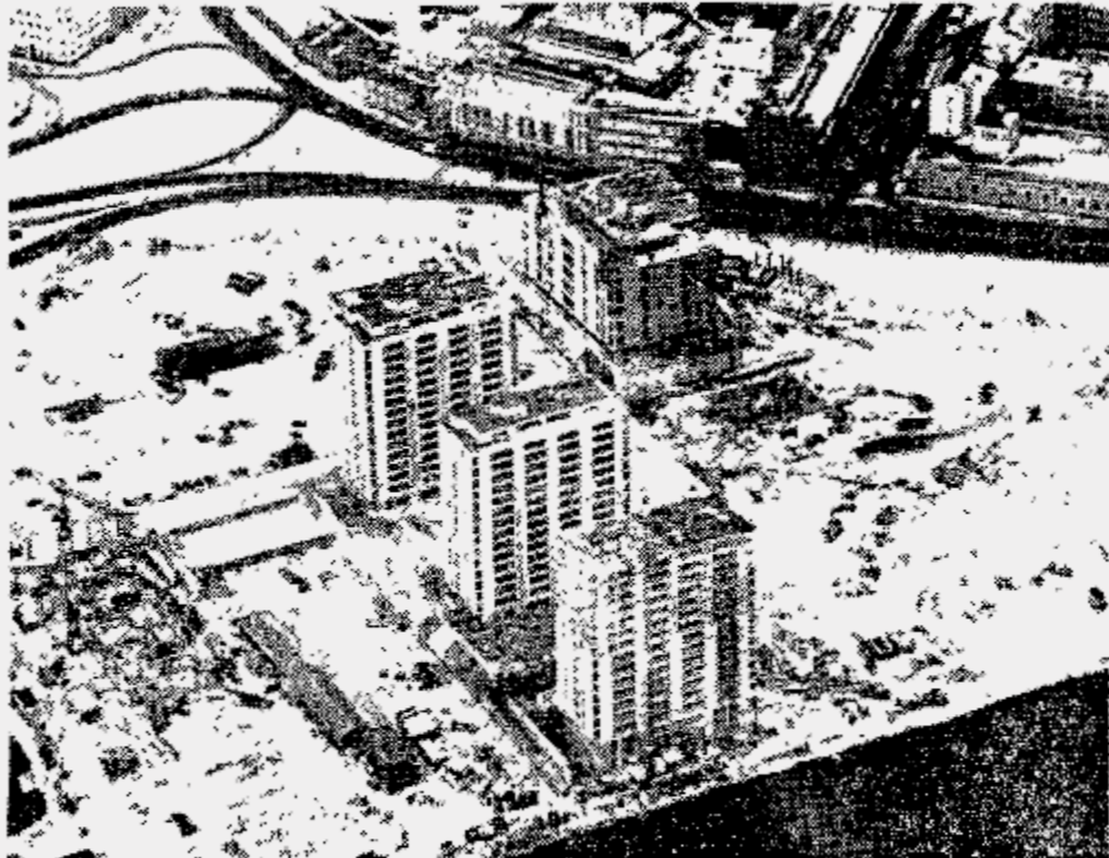
Merihaassa nousi nyt harjakorkeuteen kolmas 14-kerroksinen asuntola (etualla). Tässä rakennuksessa tapahtui kaksi viikkoa sitten hissionnettomuus, jossa kuoli neljä rakennustyöläistä. Harjakorkeuteen nousi myös takana näkyvä Helsingin veroviraston talo.
