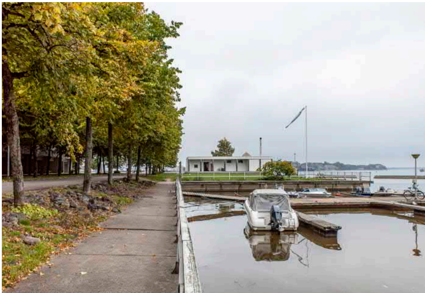
1. Veneliyyin liittyvät rakenteet ovat eräs Merihaan tunnusomaisista piirteistä. Ranta-alueen tunnelma on runsaiden aitojen takia muodostunut paikoin sulkeutuneeksi. Alueen kaakkoiskulmaan noussut Kulttuurisauna on kuitenkin osaltaan vaikuttanut suotuisasti sen virkistyskäyttöön, tarjoten saunapalveluiden ohella mahdollisuuden merelliseen pulahdukseen.
