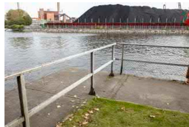
4. ... pohjoiseen askeltaessa katkeaa kulkutie aidan väliintuloon.
