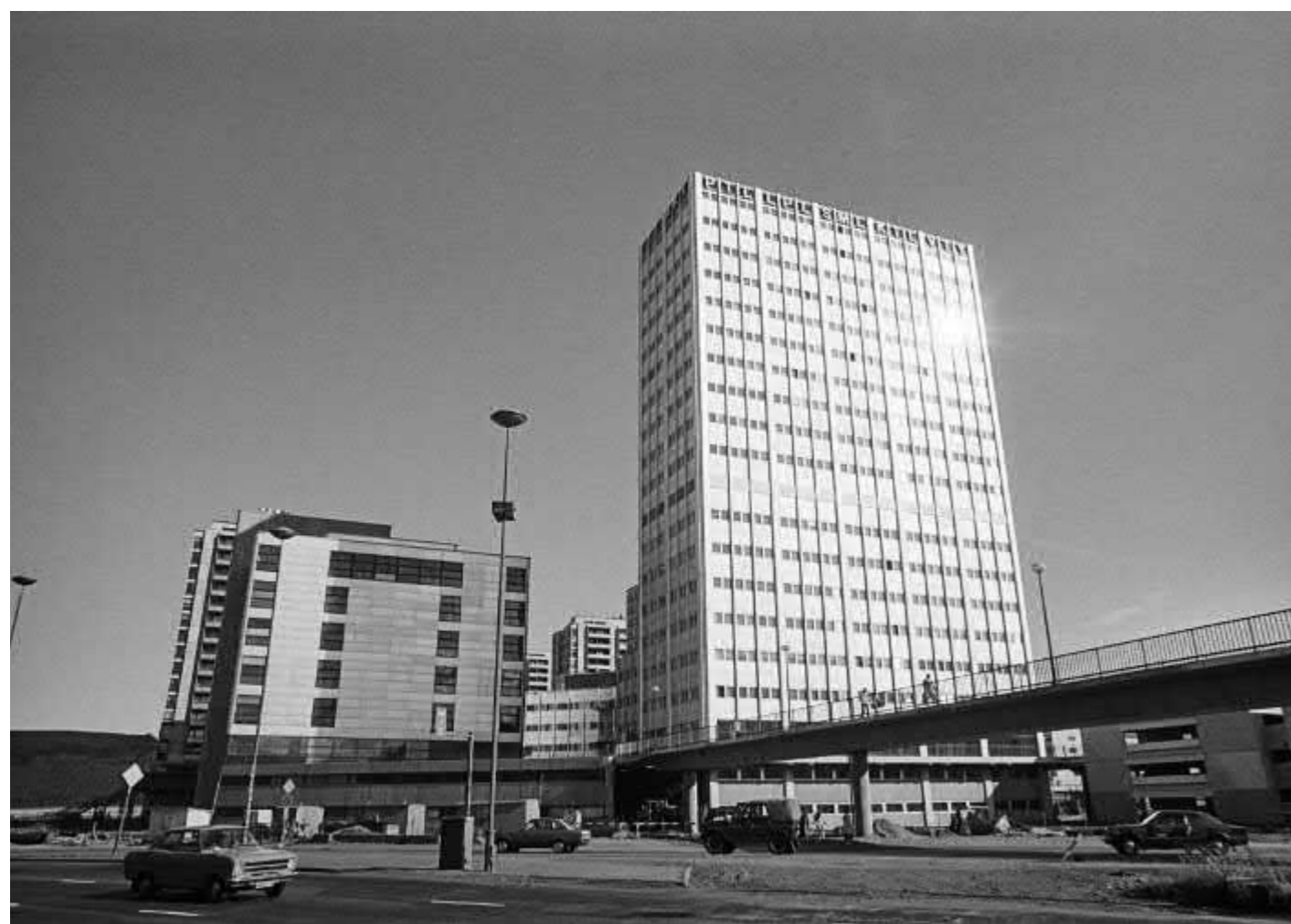
Merihaan kansitason "pääsisäänkäyntinä" toimiva Näkinsilta valmistui vuonna 1975. Kansirakenteen ohella alueen saarekemaista luonnetta korosti vilkasliikenteisen Sörnäisten rantatien ylitys. Maamerkinä kuvanottohetkellä juuri valmistunut 18-kerroksinen liittojen talo. Ilkka Pöyhönen, 1976, HKM.
