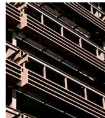
Ote Eero Saarisen suunnitelmasta John Deere pääkonttorirakennuksen corten-teräksisestä julkisivusta. www.deere.com
