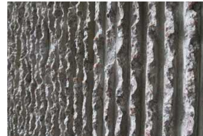
Hakattua profiloitua, eli "esivandaloitua" betonia paikoitustalon kivijalkakerroksessa.
