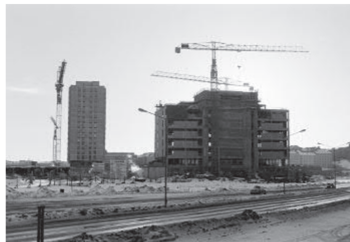
Merihaan rakennustyöt aloitettiin vuonna 1972. Ensimmäisenä valmistui vasemmanpuoleinen, 14-kerroksinen tornitalo. Samanlaisia valmistui alueelle yhteensä viisi. Oikealla valmistumassa Veroviraston käyttöön tullut toimistotalo. Betonipintaisista asuinrakennuksista poiketen toimistorakennusten julkisivut päällystettiin alumiinilevyillä. Kari Hakli, 1972, HKM.
