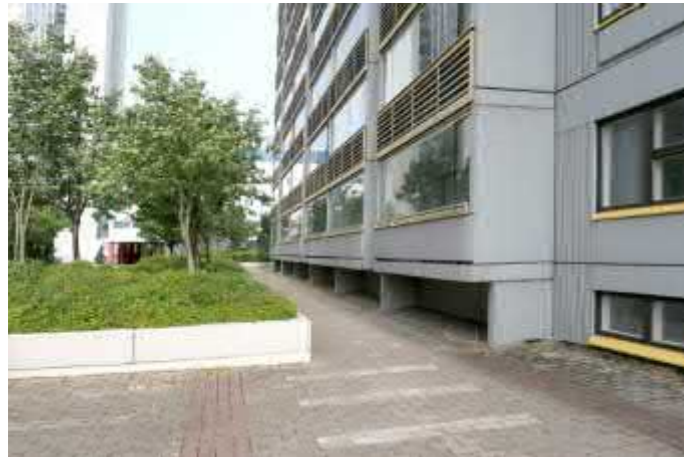
Pohjoinen lamellitalo, länsipuoli
