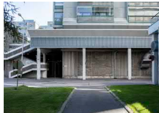
2. Ajoaukon veistoksellinen sommitelma. Porrasmuoto lisäti suunnitelmiin ilmeisesti vasta, kun eritasoristeuksen toteuttamiskelpoisuus oli luovuttu. Alatasen Leca-harkotettu seinämä antaa kannenalaisten tiloille omanlaisen ilmeen. Oikealla siivu Merihaan asumiskoneen luonteelle ominaisella tavalla näyttäytyvä ilmanvaihtokanavisto.
