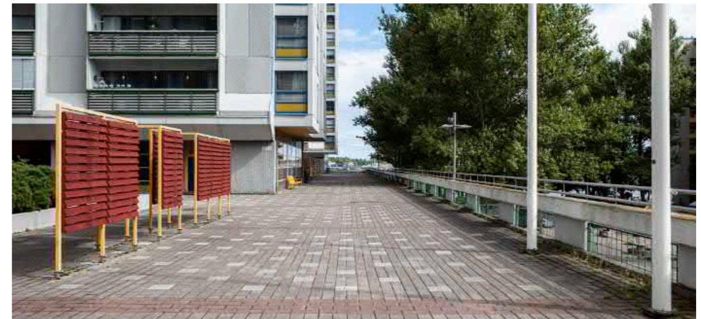
4. Näkymä itään Haapaniemenkatu 16a:n kohdalta kuvattuna. Vasemmalla tuulilaitoja. Punaista laattaa on tässä käytetty osoittamaan pelustusreitit, kun taas muualla ruudukko on tummanharmaata laattaa.
