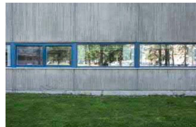
3. Veroviraston katutason julkisivua kiertävä ikkunanauha, edustallaan nurmikaistale.
