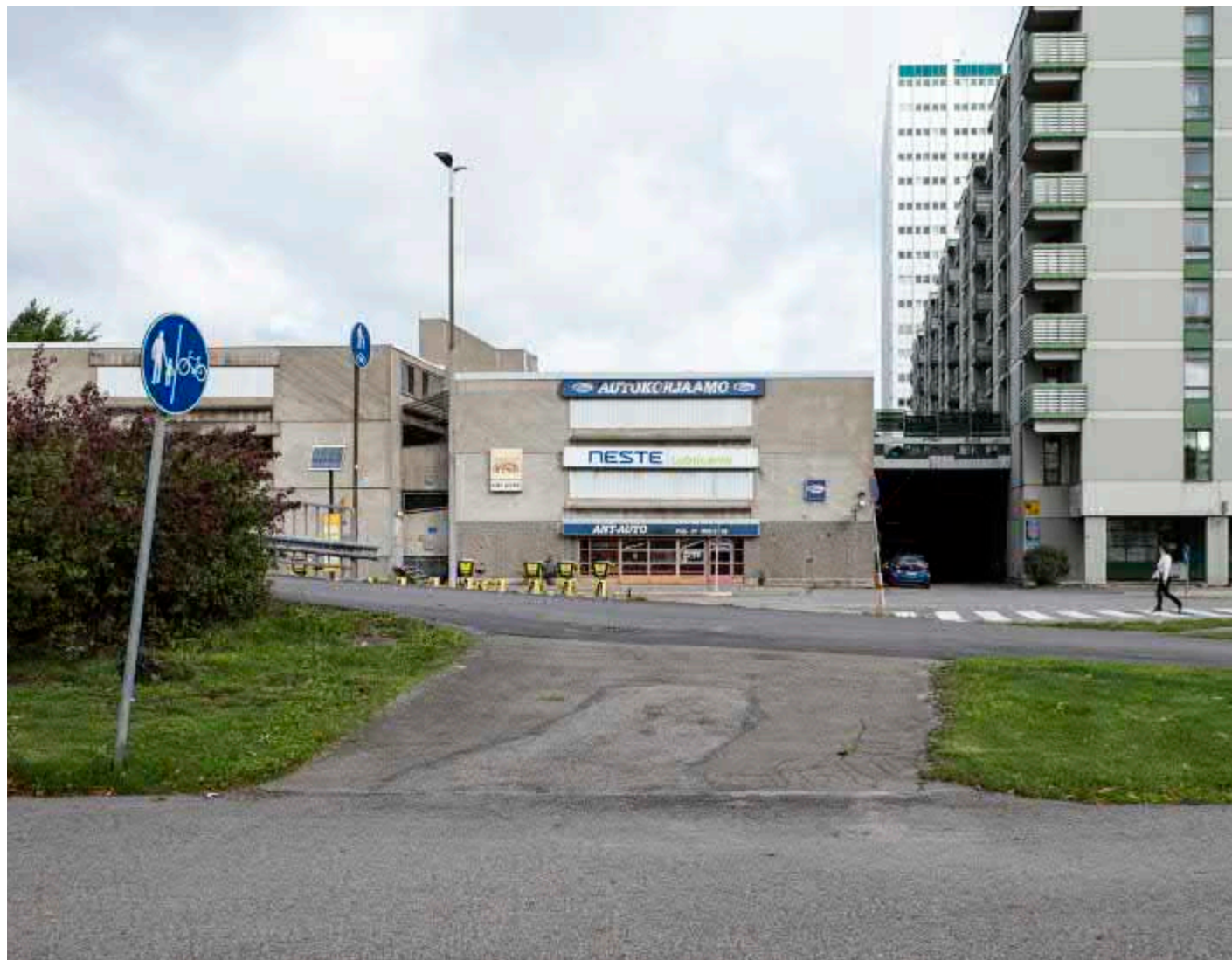
1. Hakaniemestä rantareittiä seurailevaa tai sillalta laskeutuvaa tervehtivät Merihaan päässä tällaiset näkymät. Liikenteen infrastruktuuri on leveästi läsnä, ja erityisesti vieressä vilkkaana sykkivä moottoriliikenteen valtakunta tuntuu paitsi korvissa myös alueen yleisessä olemuksessa. Etualalla näkyvässä pysäköintilaitoksessa P1 toimii autokorjaamo, eikä rakennus ole toistaiseksi käynyt läpi alueen asuintalojen ilmeeseen vaikuttanutta betonielementtien maalausoperaatiota. Pikantina yksityiskohtana umpeen pellitetty aukotus.
