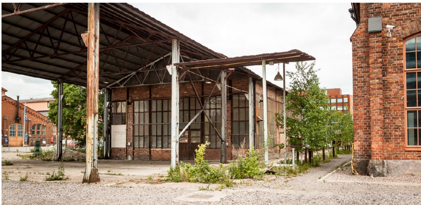
Eteläinen katos ja siihen liittyvä pienempi sivukatos, 2018.
