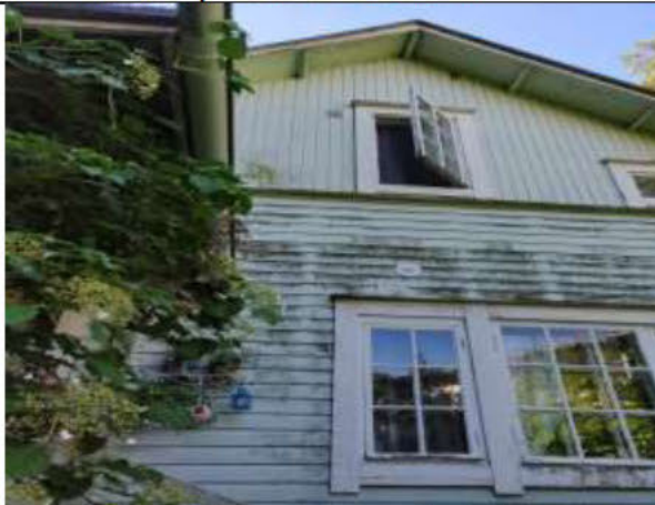
Kuva 21 Maalipinnat kuluneet, lisäksi ne ovat mustuneet orgaanisen lian vuoksi.
