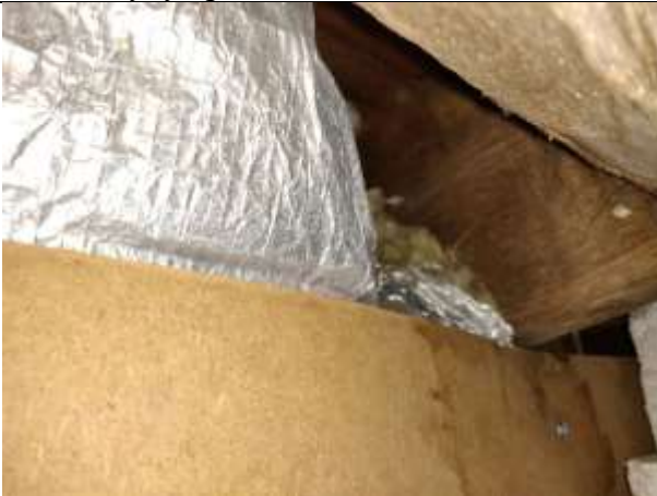
Kuva 3 Kotelointia rakennuksen ulkopuolella
