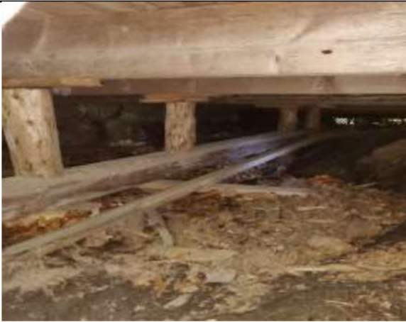
Kantavia hirsirakenteita. Orgaanista jätettä talon alla.
