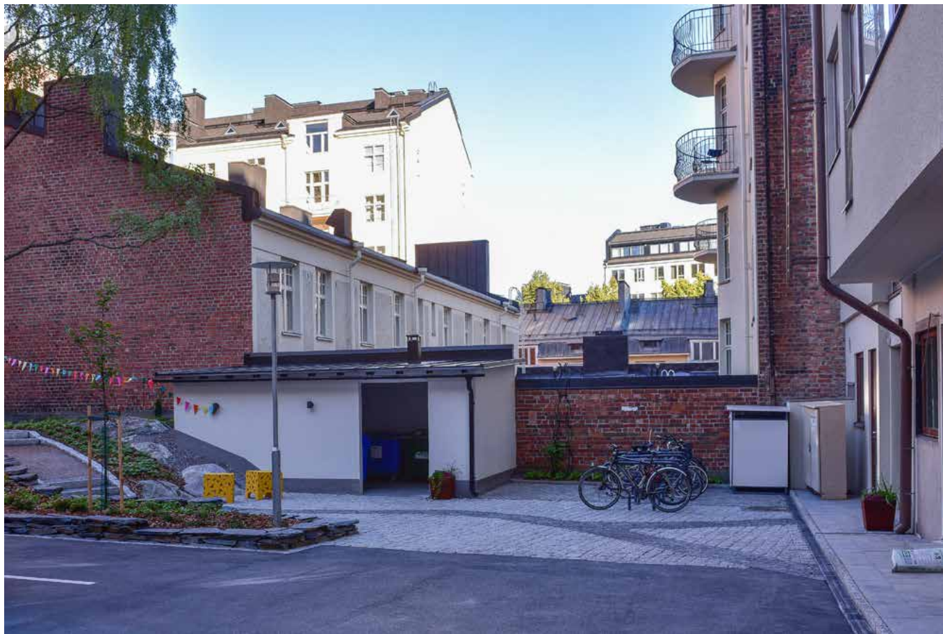
VALOKUVA SISÄPIHALTA, UUSI JÄTEHUONE JA UUDET PIHAJÄRJESTELYT
