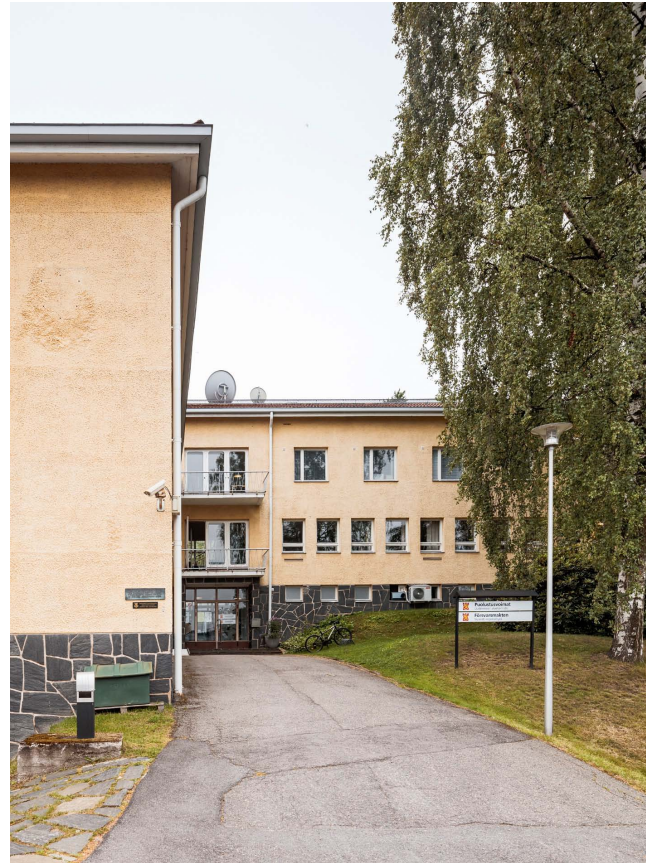
Suojeltavan päärakennuksen (RAK A) sisäänkäynti
