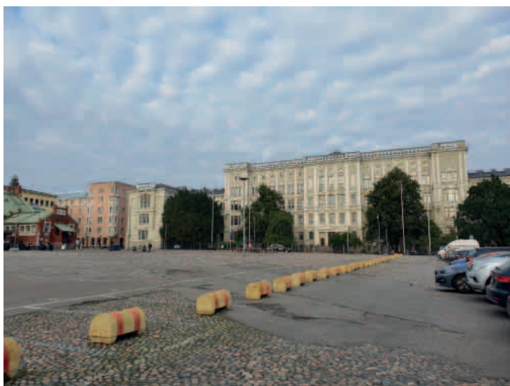
Kuva 119. Hietalahdentorin kiveystä ja asfalttia.
