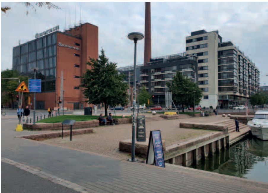
Kuva 115. Rantamuuria ja ranta-alueen rakenteita.
