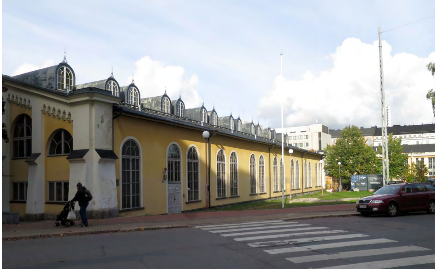
Vanhin säilynyt rakennus on 1900 valmistunut tiilirunkoinen, kaari-ikkunoilla varustettu vaunuhalli.
