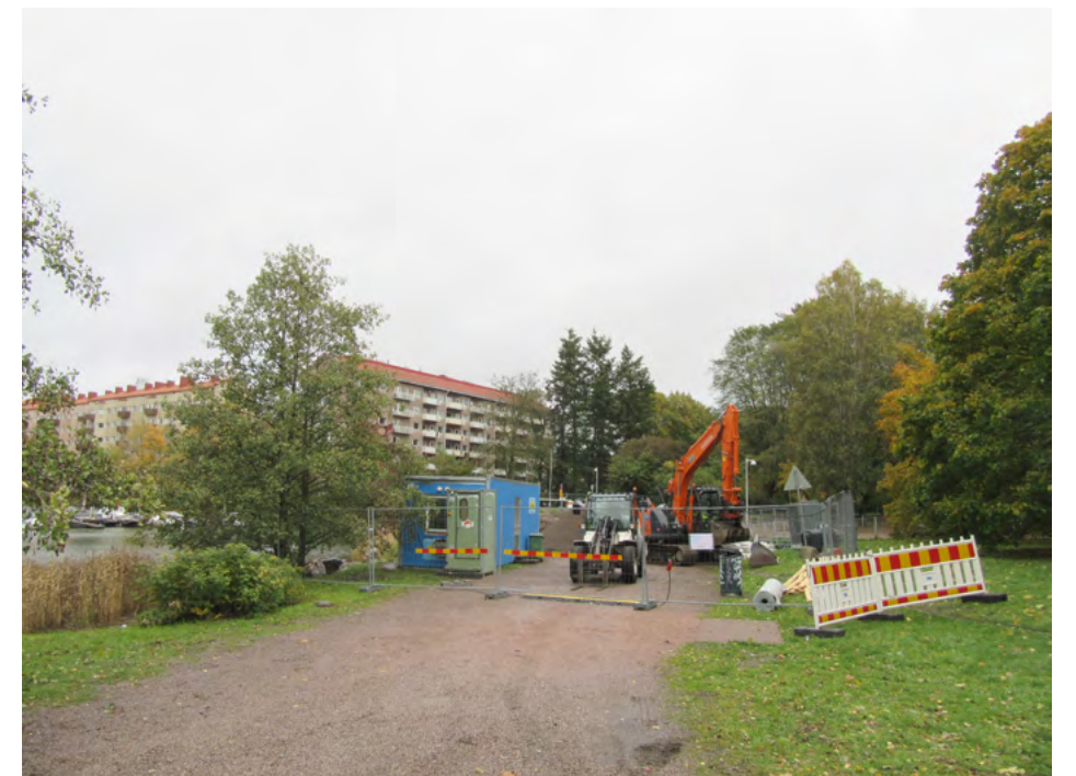
Sigurd Frosteruksen puiston itäosassa tehtiin kunnallisteknistä huoltotyötä syksyllä 2018.
