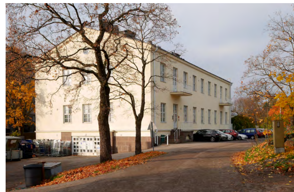
Rakennus 15, keittiörakennus vuodelta 1928.
