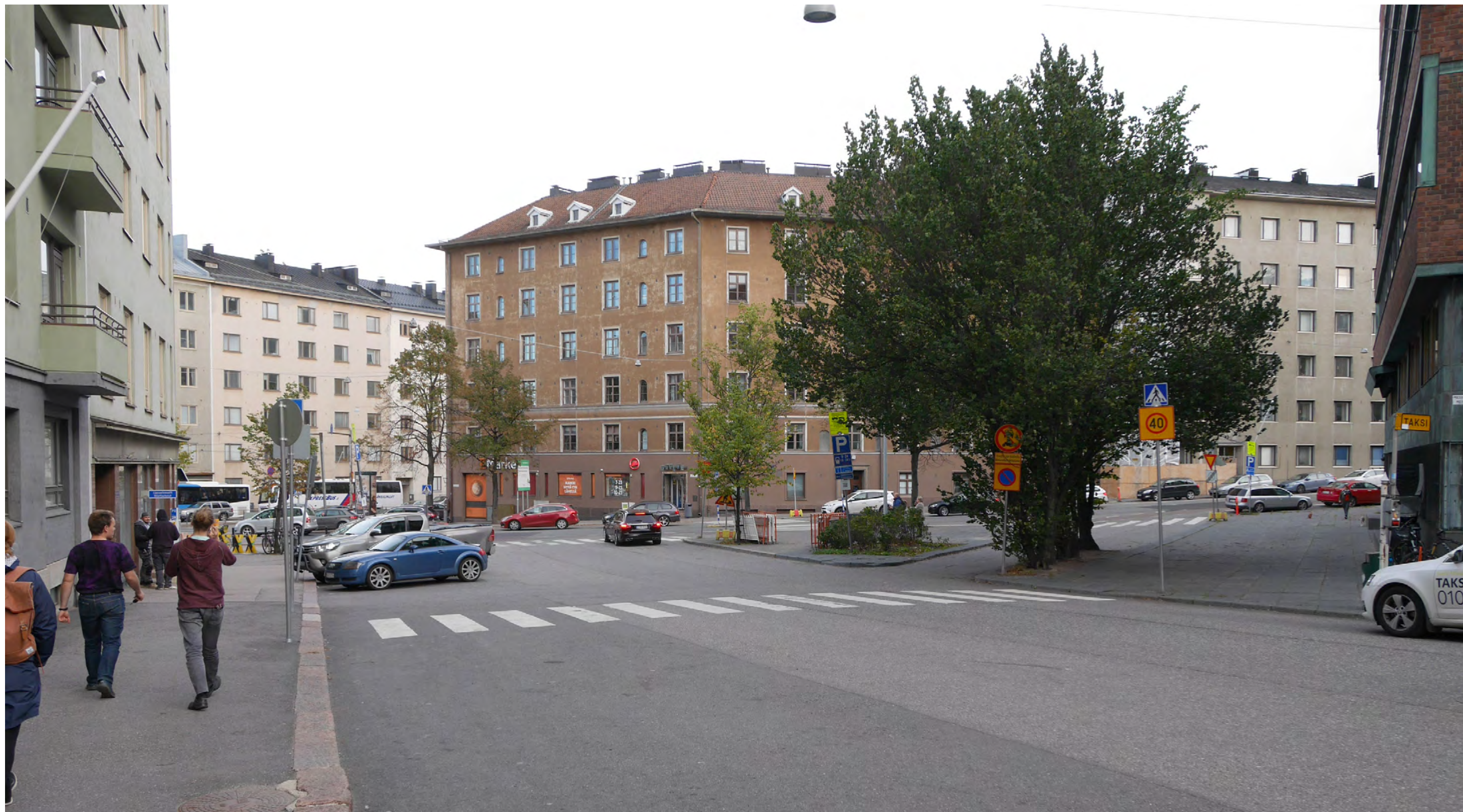
Aukiota kehystäville asuinrakennuksille on ominaista asemakaavassa määritelty kattolistan korkeus, vaaleahko rapattu julkisivu, ulkoneva kattolista ja laakea vesikatto. Kuva MSKS Oy
