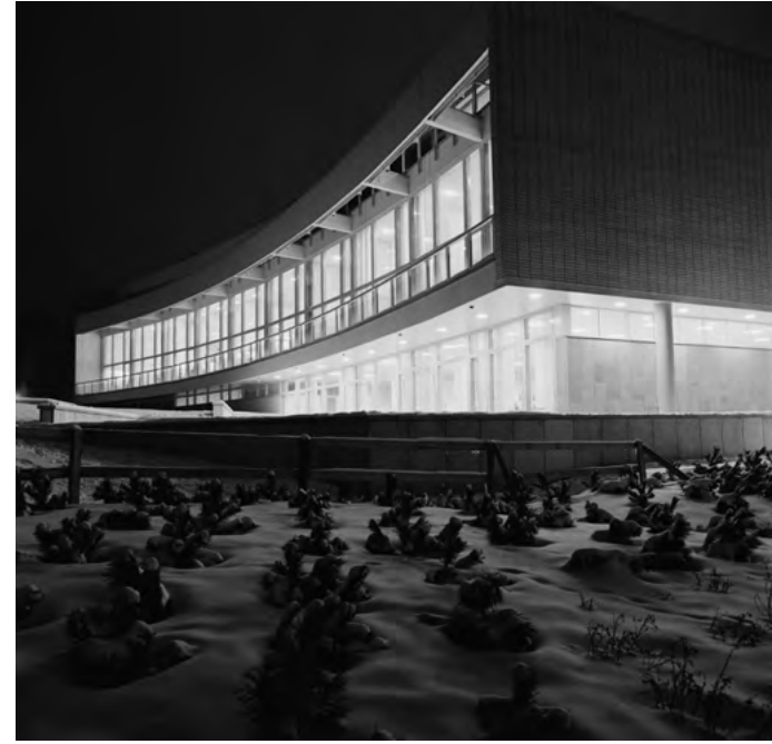
Iltavalaistus korostaa puiston puoleisen seinän merkitystä. Volker Von Bonin, 1961. HKM
