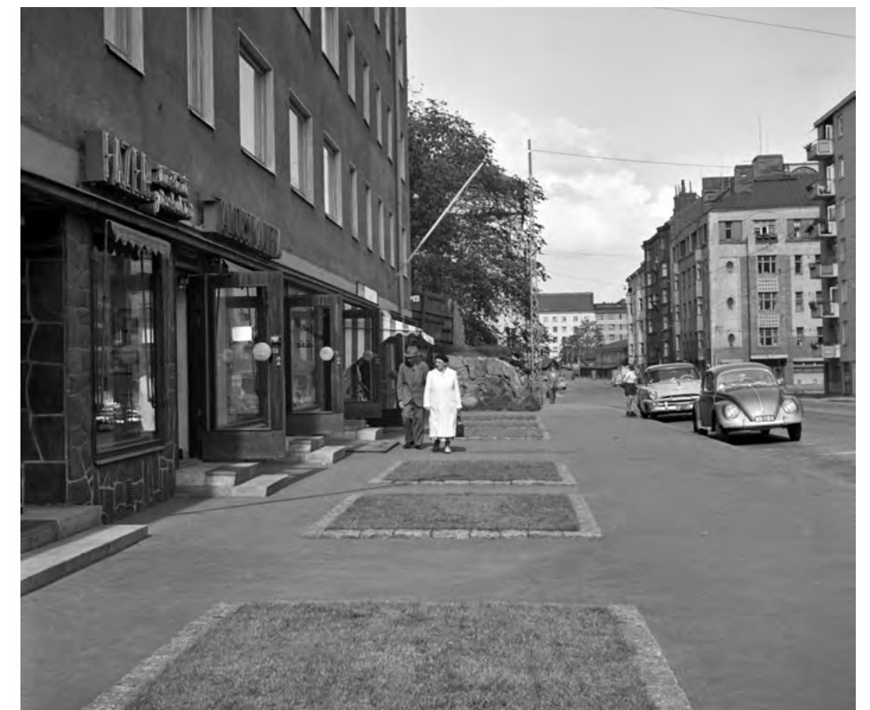
Näkymä Ruusulankadulta vuodelta 1956, kuvaaja Yrjö Lumio, HKM. Vasemmalla vierekkäisten pienten myymälähuoneistojen sisäänkäyntiportaat ja näyteikkunat. Mainoskyltit on sijoitettu ikkunoiden päällä kulkevaan friisiin.
