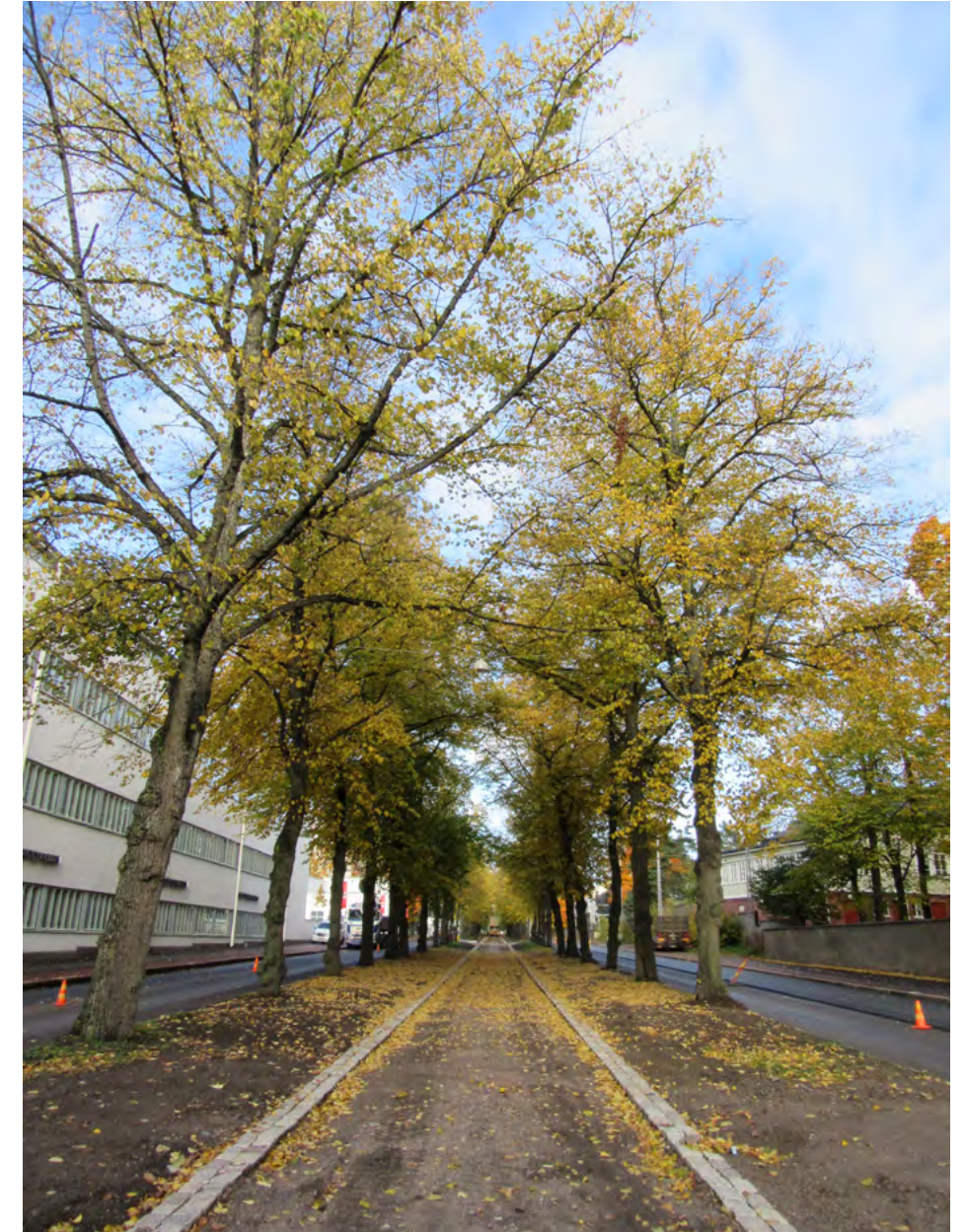
Mechelininkadun katutöiden yhteydessä on 2010-luvulla uusittu suuri osa puustosta uusittiin samalla. Hesperian esplanadin ja Sibeliuspuiston välissä olevan puistokatuosuuden puut on pystytetty säilyttämään. Alueen kunnostustyö on kuvassa vielä kesken.
