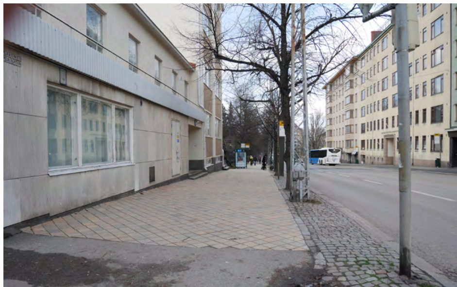
Topeliuksenkadun risteyksen kohdalla on koroke, jonka päällysteenä on Topeliuksenkadun jalkakäytävillä aiemmin laajemmin käytetty keltainen keraaminen laatta.
