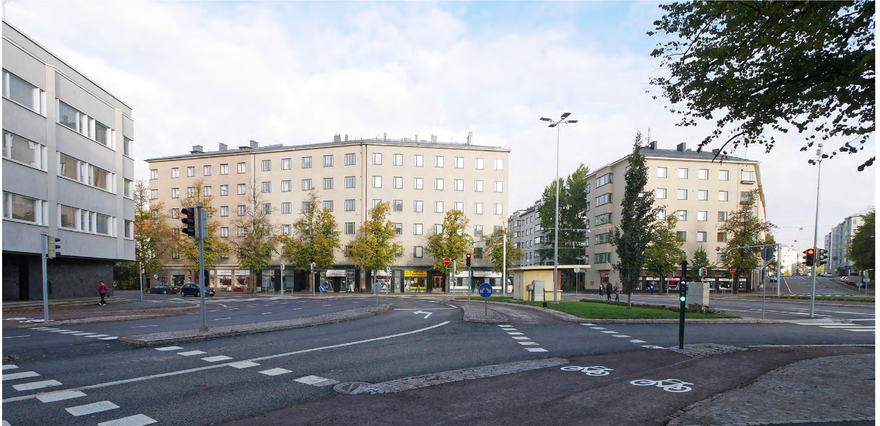
Topeliuksenkadun molemmin puolin kohoavat rakennukset muodostavat porttiaiheen.
