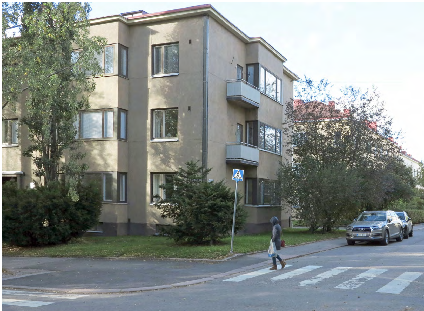
Linnankosken kadun molemmin puolin sijaitsevat, 1930-luvun kaavamuutoksella muodostetut lamellitalokorttelit muodostavat arkkitehtuuriltaan ja asemakaavaltaan yhtenäisen funktionalistisen kokonaisuuden, joka on Suomen oloissa harvinainen. Kolmikerroksiset rakennukset noudattavat pidätyväistä yhtenäistä linjaa rapattuine julkisivuineen, ikkuna-aukkoineen ja erkereineen.
