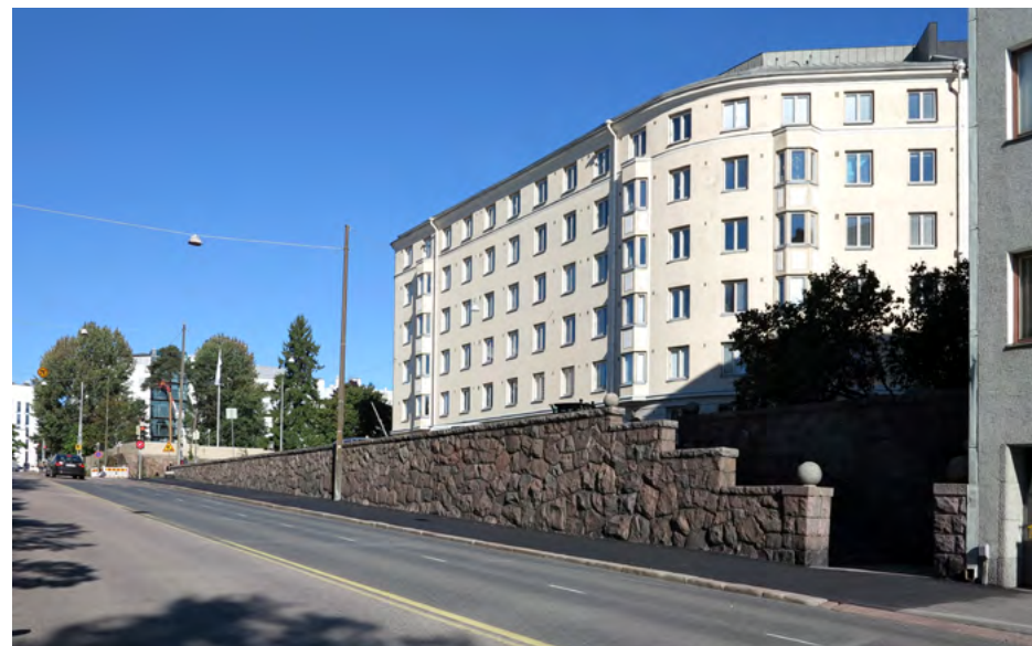
Messeniuksenkatu laskeutuu pohjoiseen kohti Stenbäckinkatua. Tasoeron kohdalla Topeliuksenkadun puolella säilynyt vanha pengermuuri porraskaiteineen on huolella viimeistelty elementti katukuvassa.
