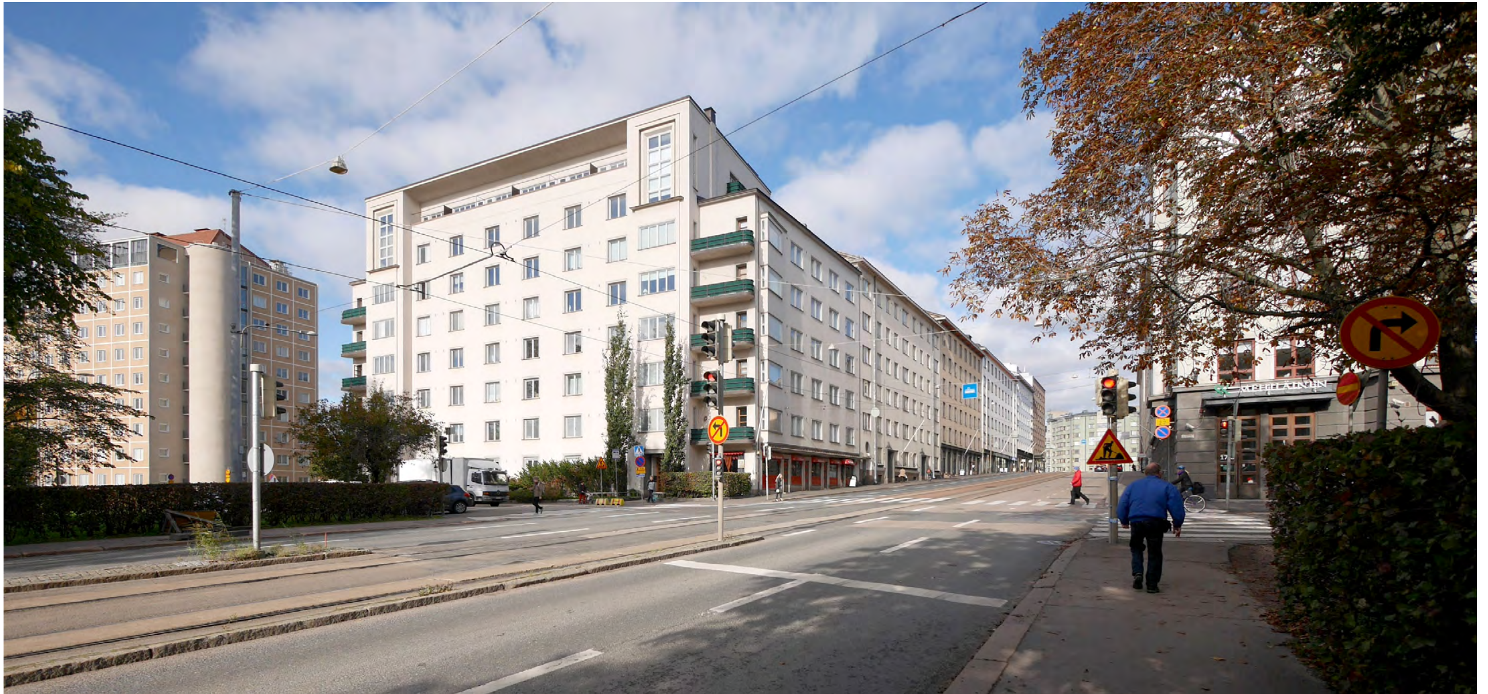
Taka-Töölön porttiaiheen muostaa viereisen Mehiläisen sairaalan kanssa Töölön Helmi, Kaarlo Borgin suunnittelema asuinrakennus tunnusomaisine ateljeeikkunoineen vuodelta 1932. Koko kortteli on suojeltu asemakaavassa. Julkisivun symmetrinen jäsentely ja itsenäinen ilme liittyvät rakennuksen asemakaavalliseen sijaintiin Pohjoisen Hesperiankadun kääntyvän katulinjan kohdalla. Hesperian esplanadin länsiosa oli saanut lopullisen, länteen avautuvan muotonsa Birger Brunilan asemakaavatyön yhteydessä vuoteen 1928 mennessä. Vastapäätä Hesperian esplanadin eteläpuolella sijaitsivat 1920-luvun lopulla valmistuneet, ns. Sonckin korttelin (449) klassistiset rakennukset. Töölön Helmen länsipuolella näkyvät sairaala-alueen tornitalot valmistuivat 1955.
