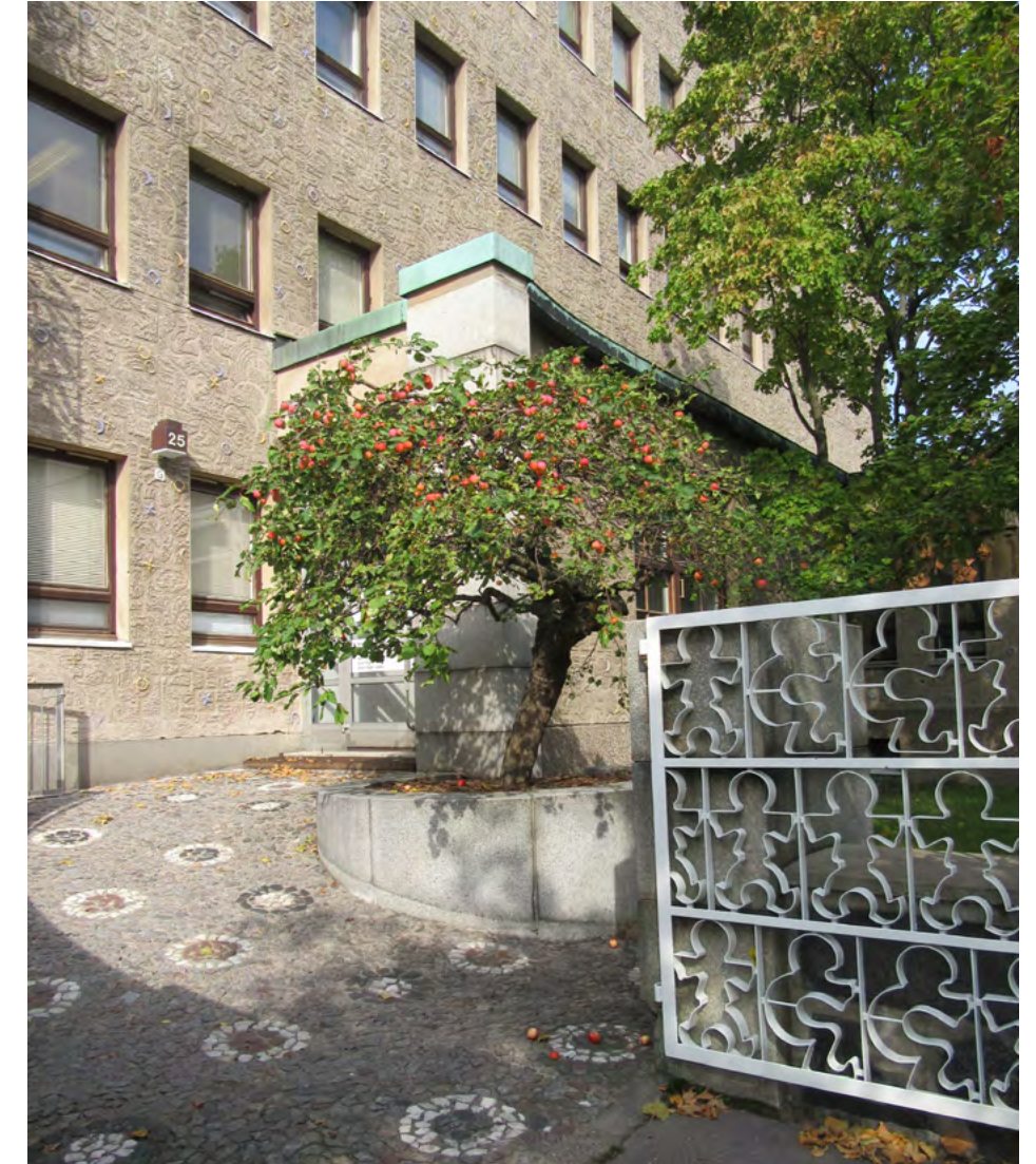
Lastenlinnan pihassa on säilynyt mosaiikkikiveystä, vanhoja rakenteita ja kasvillisuutta, kuten tämä omenapuu.
