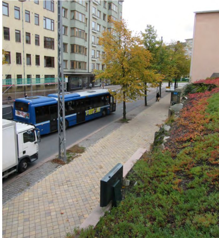
Topeliuksenkadulla, Töölön Kirkon ja Töölö gymnasiumin edustalla on Höganäsian keltaisilla terrakotatilaatoilla laatoitettu alue. Neliömäiset laatat on ladottu 45 asteen kulmaan. Aiemmin vastapäinen jalkakäytävä on ollut laatoitettu tällaisilla laatoilla, joiden alkuperä liittyyneen Töölön sairaalaan.
