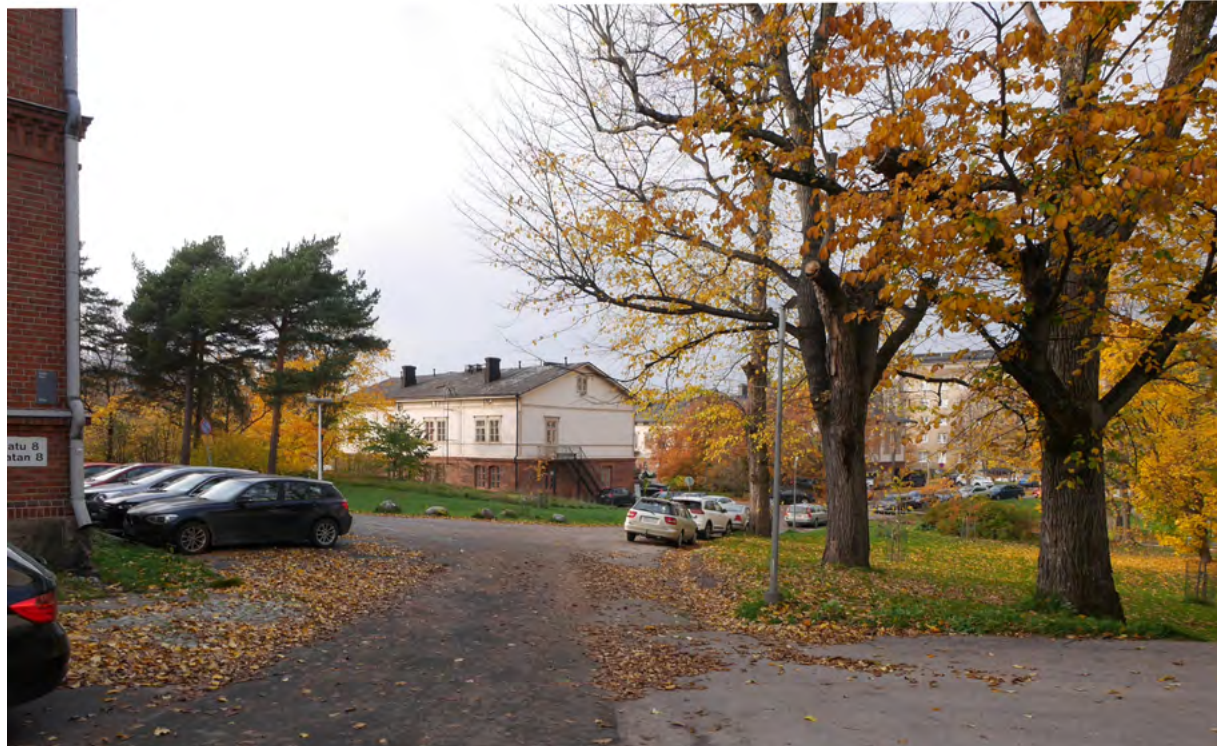
Rakennus 7. Sebastian Gripenbergin (1889) suunnittelema kaksikerroksinen työrakennus.
