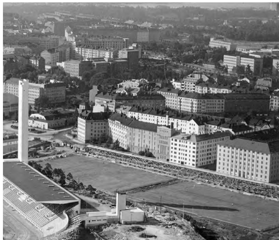
Stadionin ympäristö, viistokuva pohjoisesta 8.8.1939 (osa). Kuvassa näkyy Urheilukadun korttelirintama etupuistikoineen, keskellä kortteli 525 kolmion muotoisine puistikoineen.
