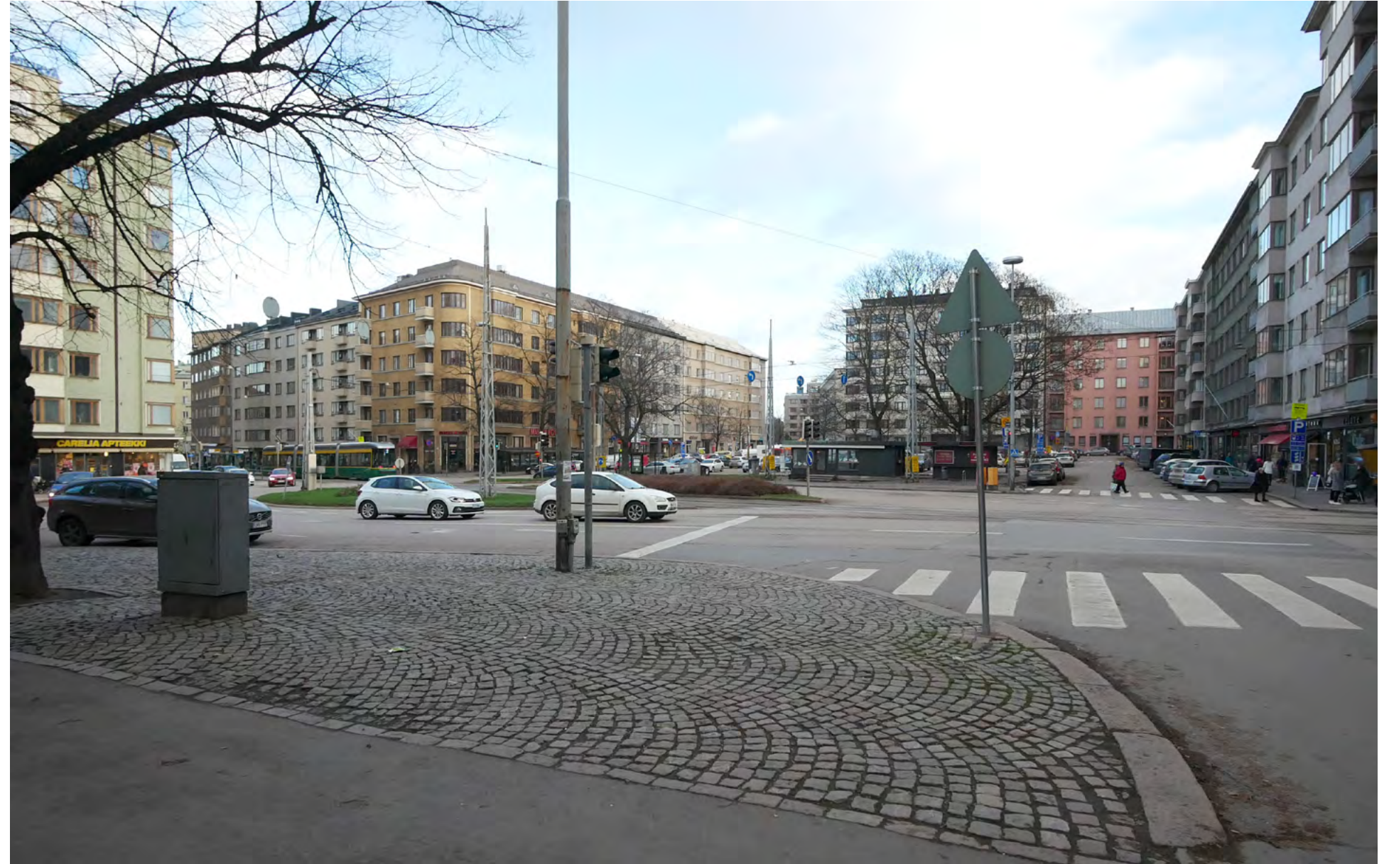
Näkymä Sandelsin koulun suunnalta. Jalkakäytävien, torialueen, liikenneväylien ja korokkeiden pintamateriaaleja ovat asfaltti, graniittireunakivet ja noppakiveys.
