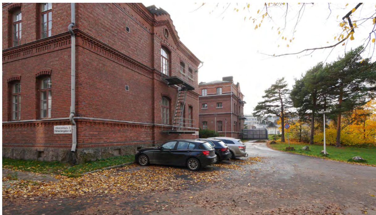
Rakennus 10. Onni Törnqvistin suunnittelema kaksikerroksinen, punatiilinen mielisairaalapaviljonki valmistui vuonna 1894.
