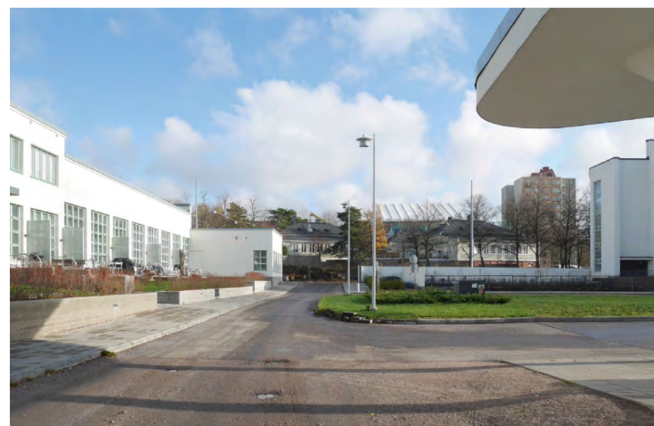
Piha korjausten jälkeen.
