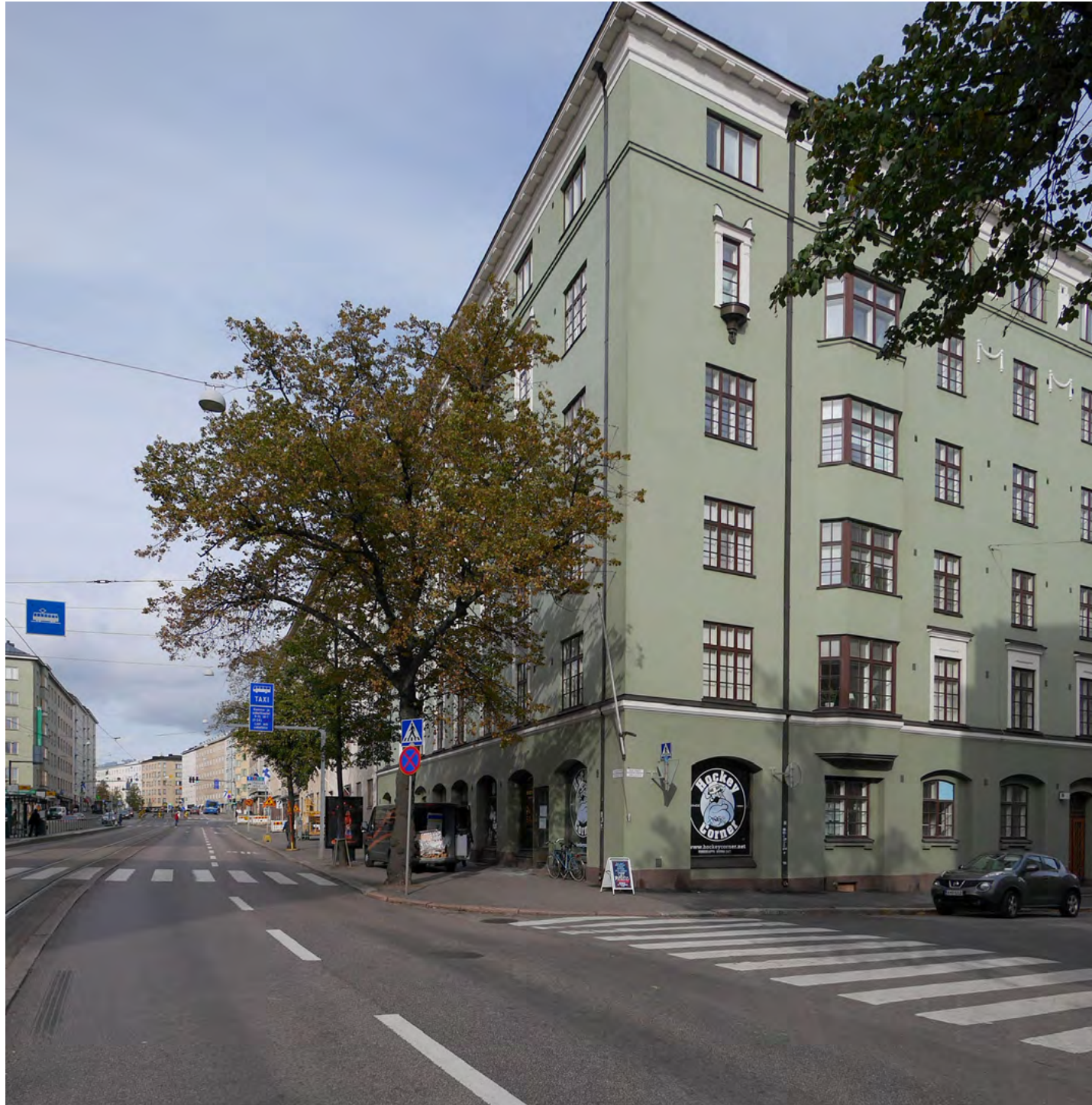
Mannerheimintie 39, Savilankadun kulmatalo, kortteli 522. Vuonna 1927 valmistuneen rakennuksen on suunnitellut Ole Gripenberg. Julkisivun tunnusomaisia piirteitä ovat viistokulmaiset erkkerit ja raskas kattolista.
