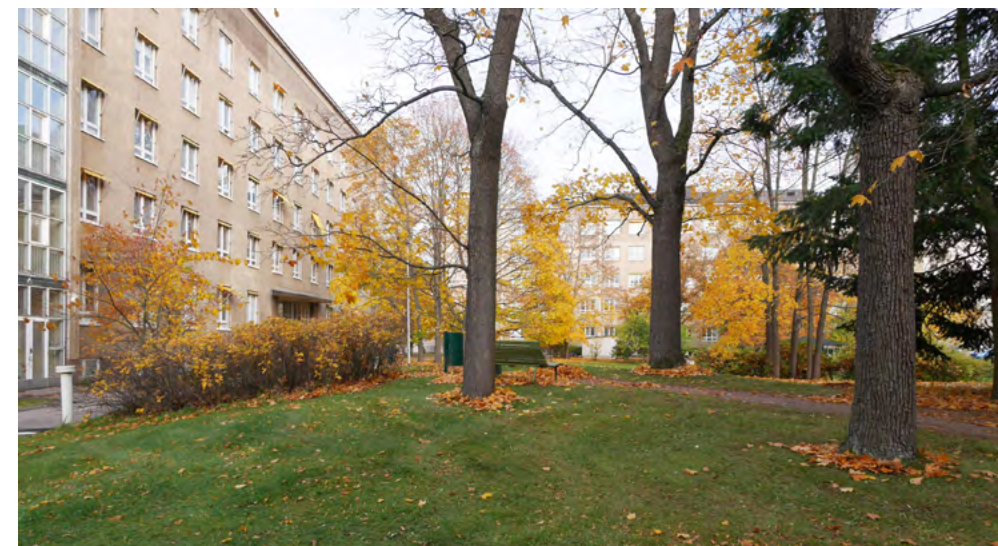
Rakennus 18 pihan suunnalta, taustalla rakennus 17.
