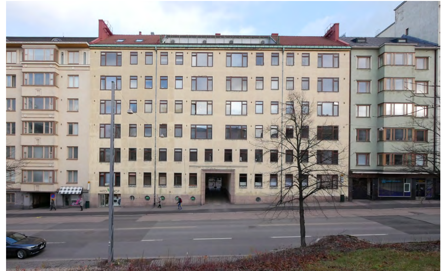
Väinö Vähäkallion suunnittelema, 1932 valmistunut Topeliuksenkatu 3a, kortteli 479. Harvinaisella pitkällä kattoterassilla varustettu rakennus valmistui 1932 ja tunnetaan siitä, että asuntoihin saatiin kaupungin ensimmäiset sähköhellat (Lahti 1960, 195). Rakennuksen edessä olevan jalkakäytävän päällystysnä on aiemmin ollut Höganäsin keltaisia, diagonaaliladottuja klinkkerilaattoja. Ainoat säilyneet laatat on siirretty vastapäiselle jalkakäytävälle.
