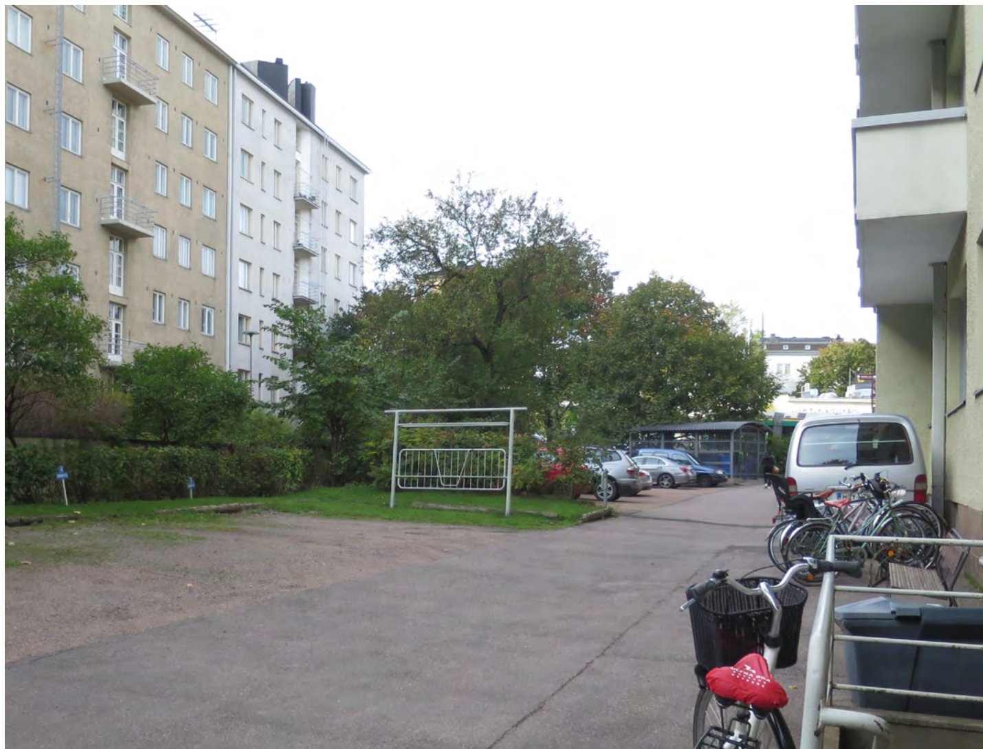
Urheilukadun ja Nordenskiöldinkadun risteyksessä sijaitsevan, avointa korttelityyppiä edustavan korttelin 521 pihaa reunustavat korkeat lamellitalot. Piha avautuu etelään ja pohjoiseen. Keskialueella on runsasta kasvillisuutta ja leikattu pensasaita, rakennusten seinustalla asfalttia, huoltoalueita ja autopaikkoja.
