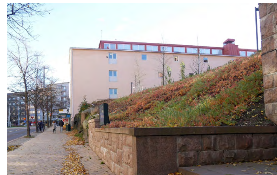
Näkymä Topeliuksenkadulta kohti koulun pohjoisseinää.
