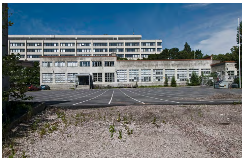
Piha-alueen ja rakennusten ilme oli päässyt rappiotilaan ennen korjaus- ja muutostöiden alkua. Kari Hakli, HKM.
