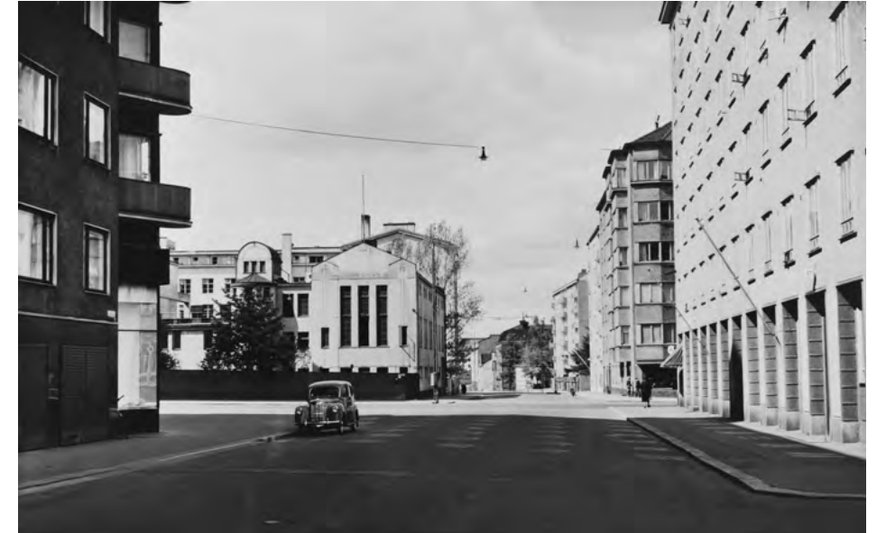
Vasemmalla Töölön sähköasema kuvattuna toukokuussa 1955. Kuva HKA
