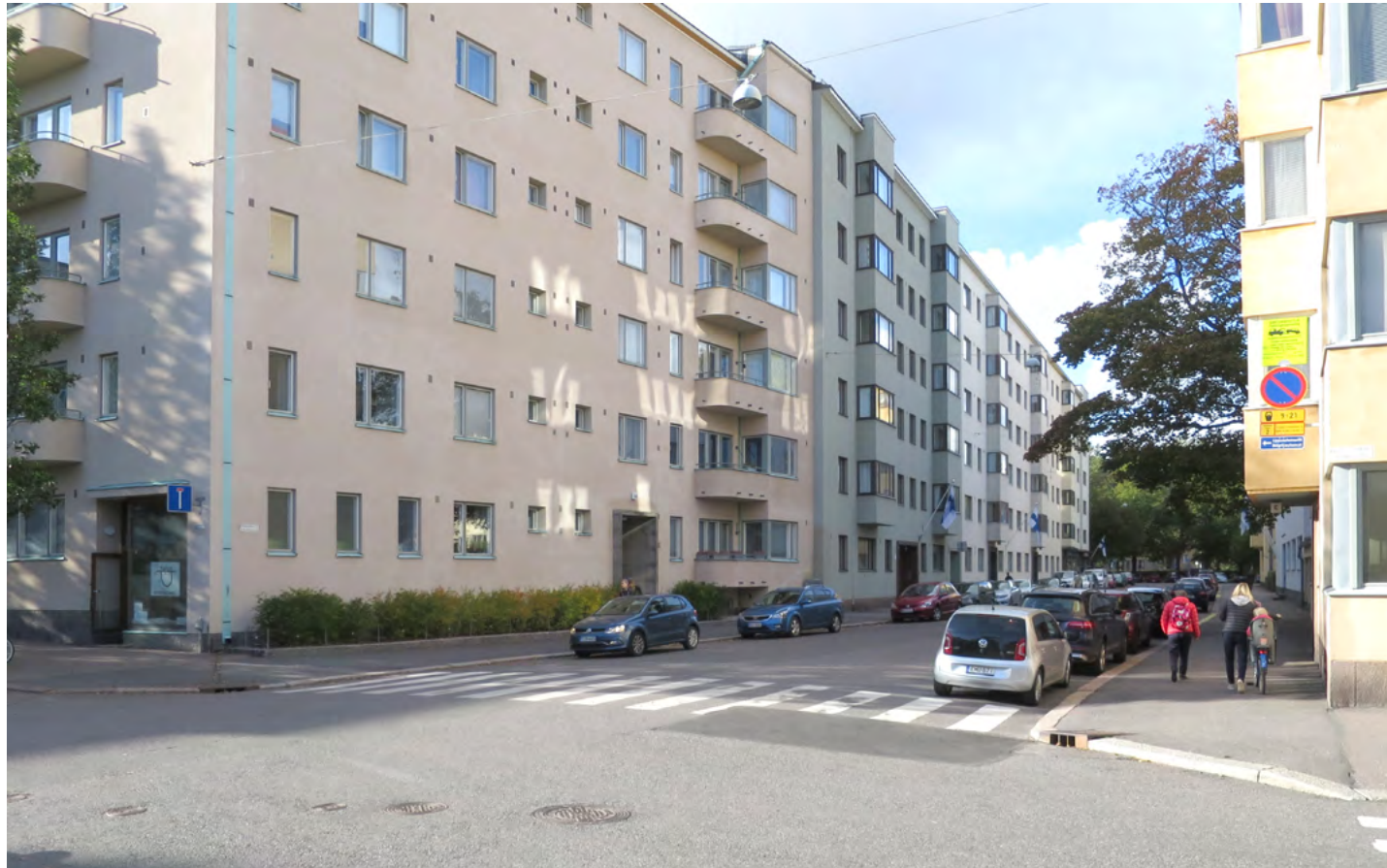
Yhtenäinen korttelijulkisivu Töölönkadun pohjoispäässä edustaa tunnusomaista töölöläisfunkista kulkimikkaine erkkereineen ja pyöristettyine parvekkeineen.
