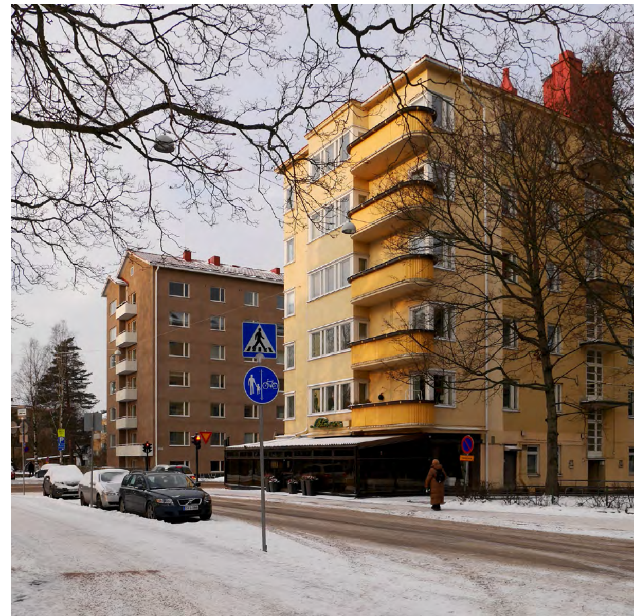
Mechelininkadun pohjoisosan porttiaiheen muodostavat Humalistonkadun puoleiset korkeat, kapeat päädyt. Edessä olevan, Jalmari Peltosen 1938 suunnitteleman rakennuksen päätyerkkereihin liittyvät funktisarkkitehtuurille tunnusomaiset, pyöristetyt parvekkeet.
