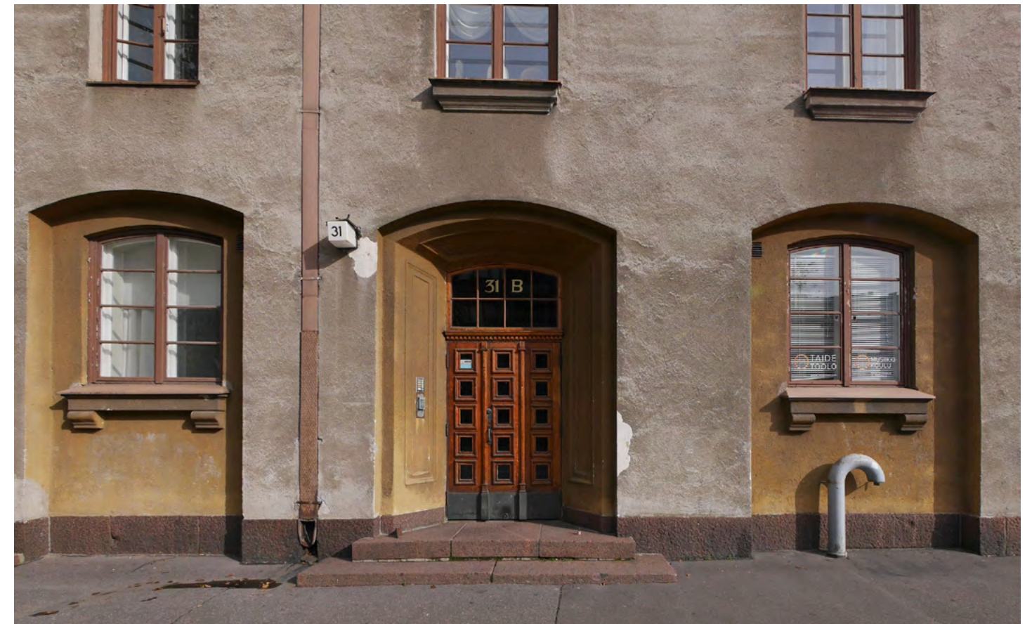
Yksityiskohta Ole Gripenbergin suunnittelemasta, 1926 valmistuneesta rakennuksesta, joka kuuluu yhte-näisen korttelisuunnitelman mukaan rakennettuun kortteliin 523, Mannerheimintie 35. Pohjakerroksen syvälle julkisivupintaan nähden sijoitetut, segmenttikaareen päättyvät ikkunakomerot ja syvennykseen sijoitettu ulko-ovi ovat pohjoismaisen klassismin tunnusomaisia tehokeinoja.
