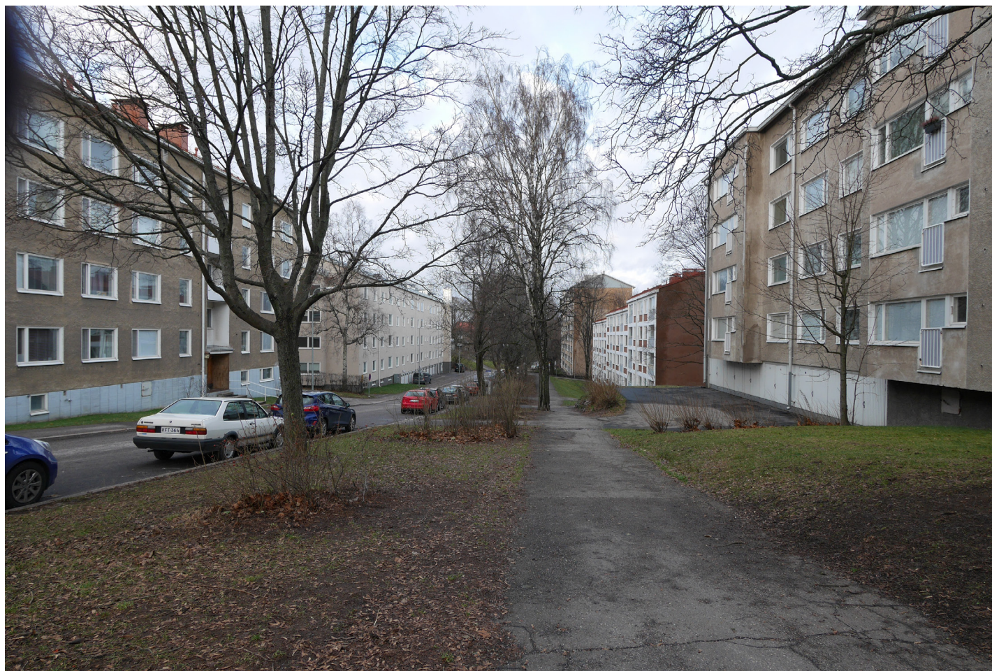
Näkymä Vellamonkatua pitkin pohjoiseen. Vasemmalla Arkkitehtien Kokko&Kokko 1956 suunnittama nelikerroksinen asuinrakennus, ja kauempana samalla puolella Klaus Grothin 1956 suunnittelema rakennus. Oikealla etualalla Esko Suhosen 1958 suunnittelema rakennus ja sen jatkeena kadun varrella Sakari Niroson 1955-1957 suunnittelema rakennus, joka on saanut ympäristöönsä nähden yksilöllisen ulkoasun. Kaukana taustalla kohoaa alkuperäisen asemakaava-alueen ulkopuolelle rakennettu korkeampi lamellitalo.
