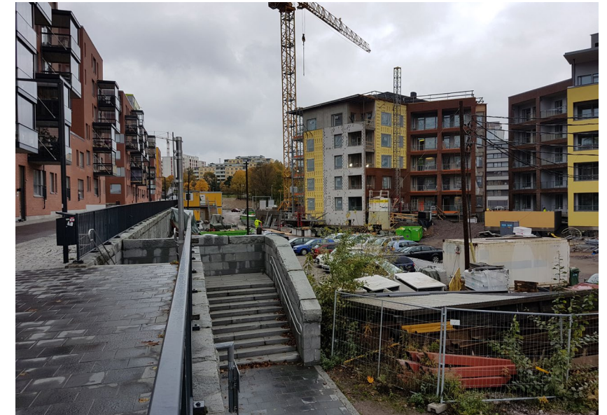
Konepajanpuisto on rakenteilla. Kuva: Näkymä Oy
