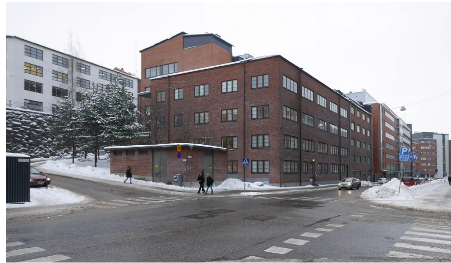
13. Elimäenkatu 23 - Pälkäneentie 20, 22-694-23 Teollisuusrakennus
