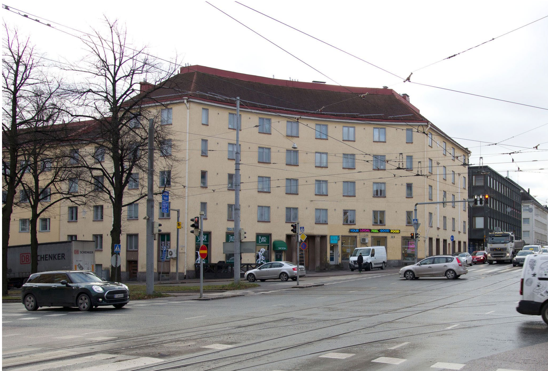
Sturenkadun ja Mäkelänkadun kulma Liike- ja asuinkerrostalo Mäkelänkatu 28 Arkkitehti Väinö Vähäkallio 1927-1928
