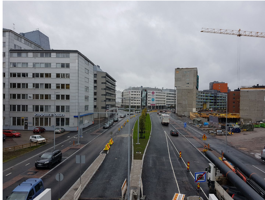
Teollisuuskatua rakennetaan uudelleen. Valokuva otettu Savonkadun sillalta. Oikealla näkyy Konepajan asuinalueiden rakennustyömaata. Kuva: Näkymä Oy
