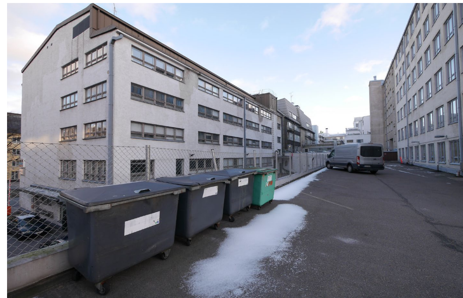
Asfalttipinnoitteiset pihakannet autopaikkoineen ovat teollisuusalueelle ominaisia piirreitä, esimerkkinä kortteli 707.
