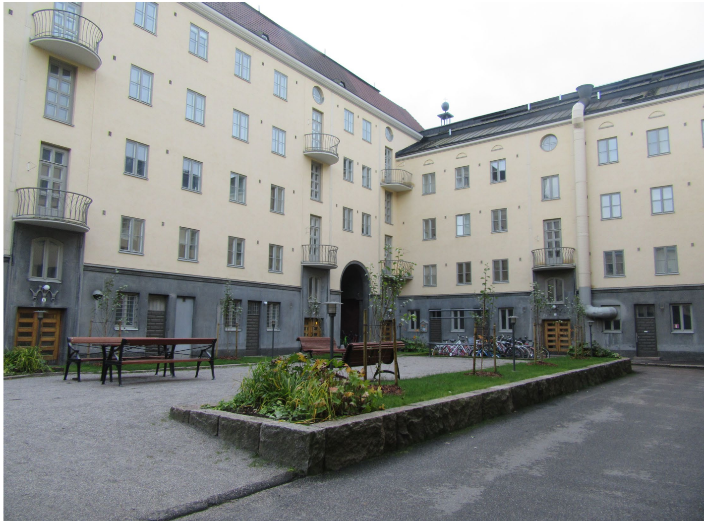
Arkkitehti Martti Välikankaan 1920-luvulla suunnitteleman As Oy Sturen sisäpiha kuuluu Vallilan suurpihakortteleiden sarjaan. Pihaa on vastikään kunnostettu, putaimet ovat uusia. Kuva: Näkymä Oy
