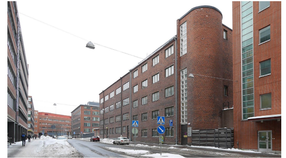
14. Elimäenkatu 21 - Pälkäneentie 18, 22-694-21 Teollisuusrakennus
