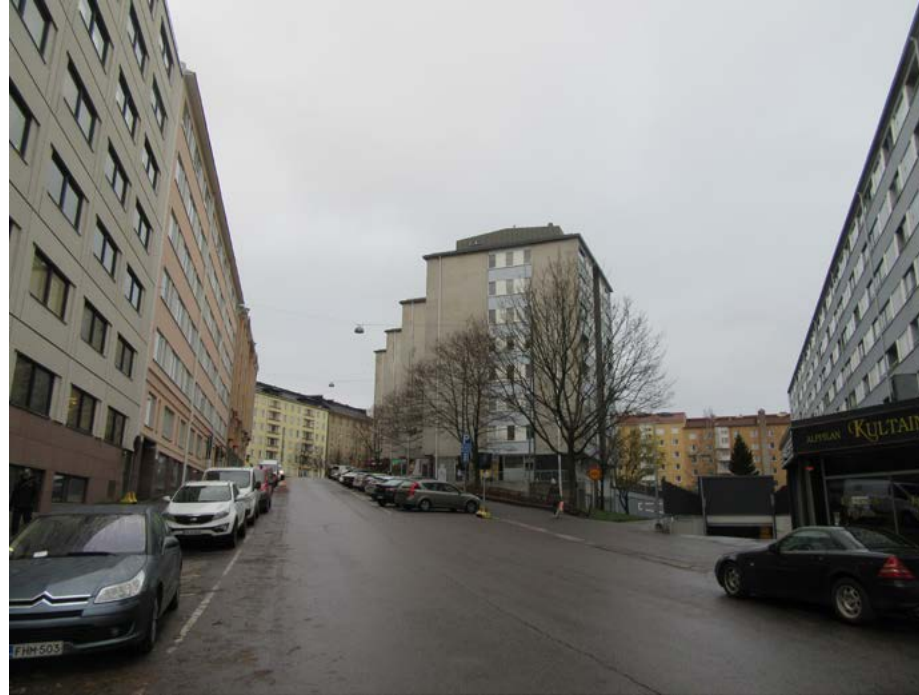
Viipurinkadun varren lamellitalot ja niiden kulmauksissa olevat istutukset. Kuva: Näkymä Oy
