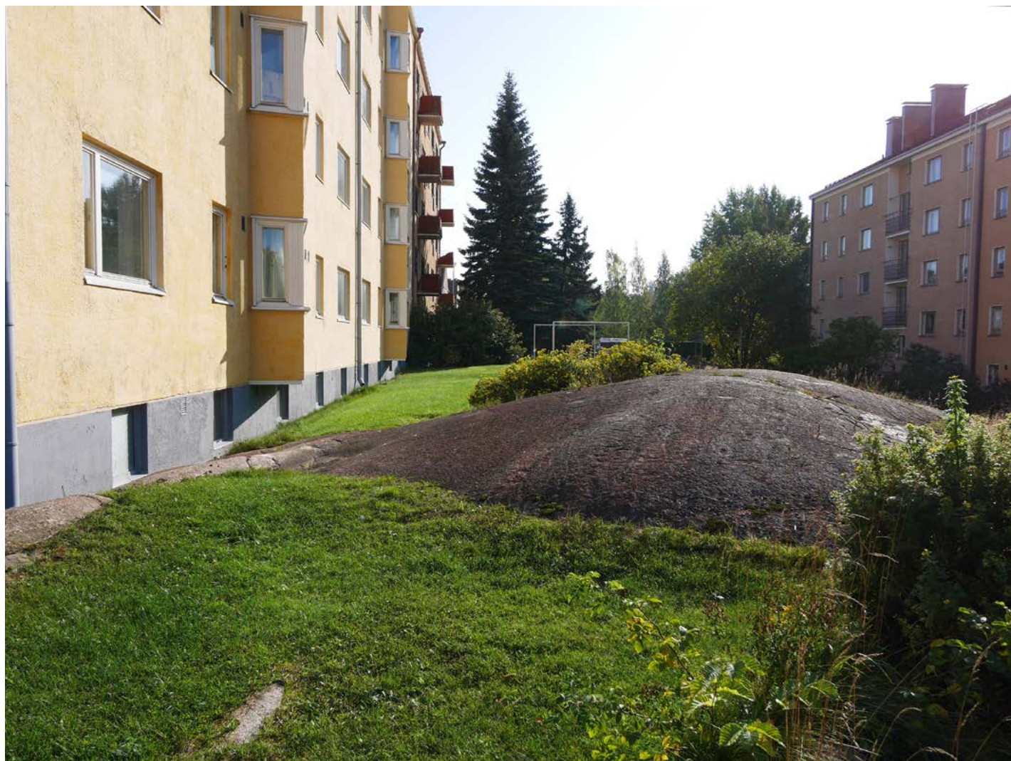
Alppilan länsiosassa on 1950-luvulla rakennettuja avokorttelien asuinrakennuksia, joiden pihakasvillisuus soljuu alueen läpi ja luovat alueelle puistomaisen tunnelman.
