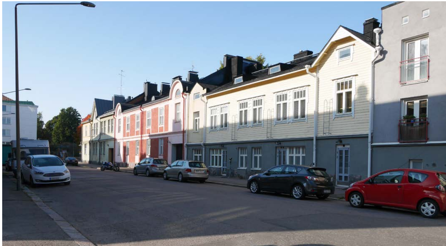
Siuntionkadun varrella säilyneitä, 1910-luvun taitteessa rakennettuja asuintaloja, joiden alakerros on tiiltä ja yläkerros puuta.
