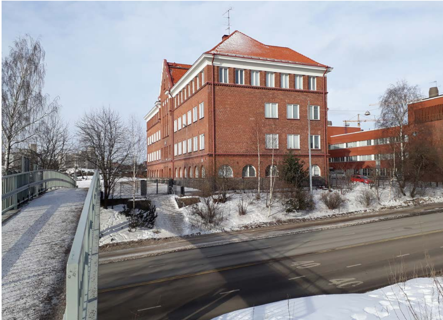
1910-luvulla rakennettu koulurakennus on saanut näkyvän paikan korkealla Pasilan ratapihan yläpuolella. Koulupihalle johtaa silta ratapihantien yli.
