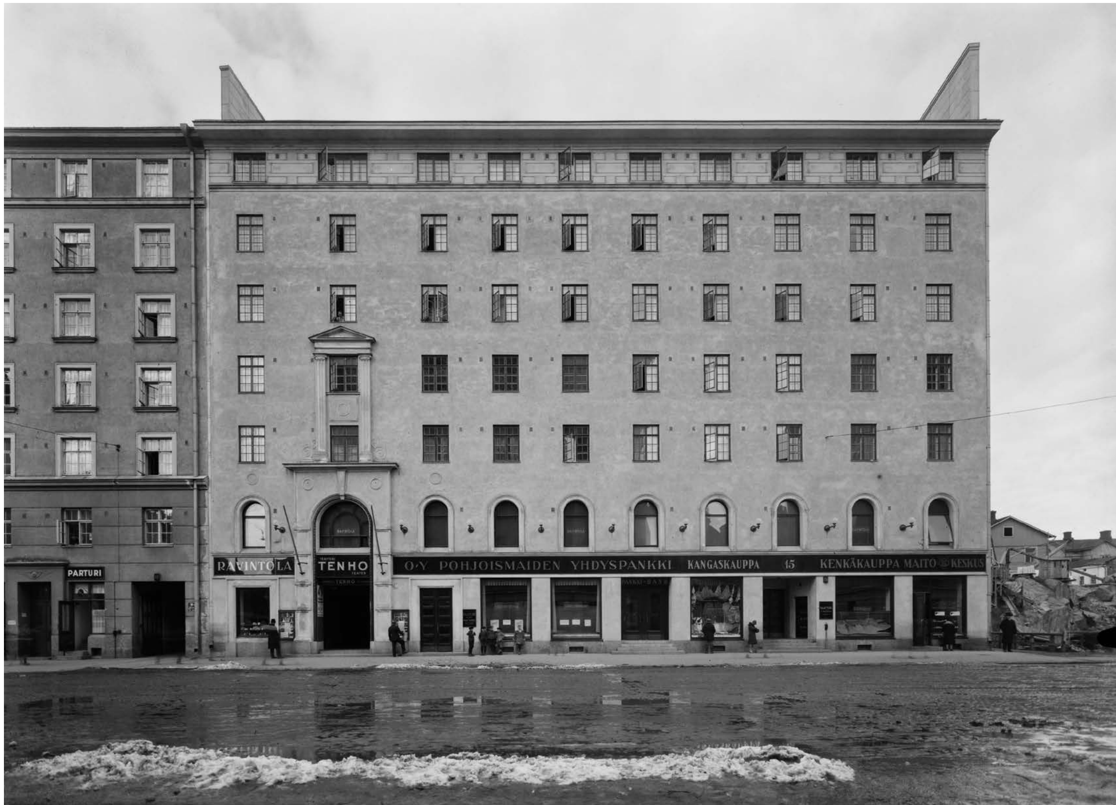
Tunnetun arkkitehtitoimiston suunnitteleman seitsemänkerroksisen kivitalon porttikäytävä on saanut näyttävät kehykset. Voimakkaasti ulkoneva kattolista korostaa klassistista, palatsimaista julkisivua. Helsinginkatu 15 vuodelta 1928. Arkkitehtitoimisto Frosterus & Gripenberg. Kuvaaja R. Roos 1931, HKM.
