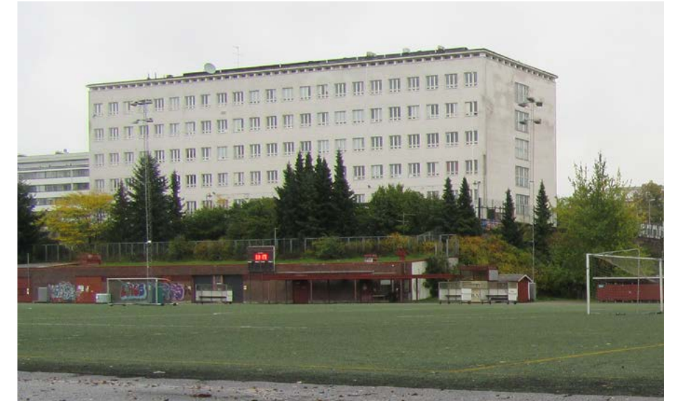
Kuva: Näkymä Oy
