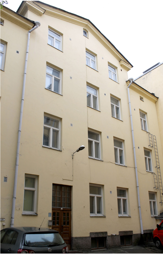
Piharakennuksen julkisivut ovat massiivitiilirakenteisia ja vaaleaksi rapattuja. Ikkunat on vaihdettu.
