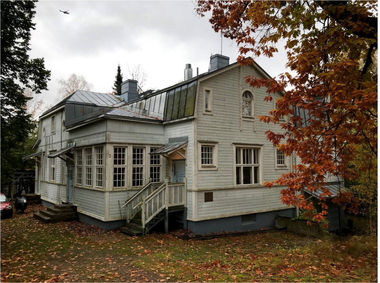
Kuva 2. Katunäkymä Patomäentien ja Ruutanakujan risteyksestä.
