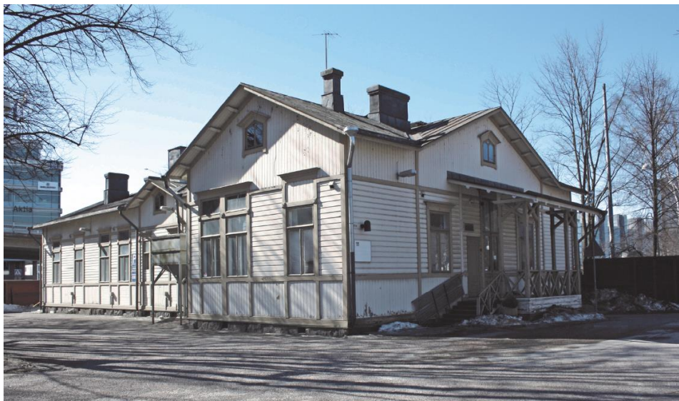
Kuva 2. Marian sairaalan rakennus 11, kulkutautipaviljonki
