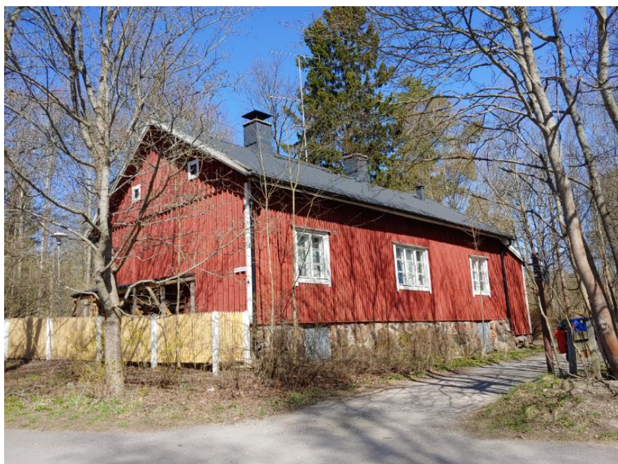
Kuva 4. Osoitteessa Mikkolantie 25 sijaitseva, asemakaavassa suojeltu rakennus (tontilla 34028/2)
