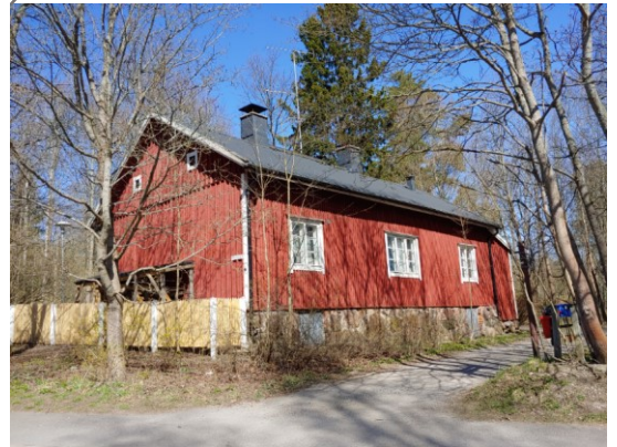
Osoitteessa Mikkolantie 25 sijaitseva suojeltu rakennus (tontilla 34028/2)
