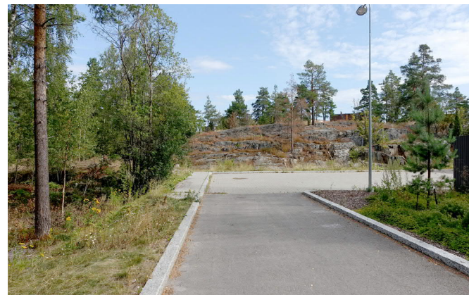
Ensi Parven katutila, näkymä kohti rakentumattomia asuintontteja
