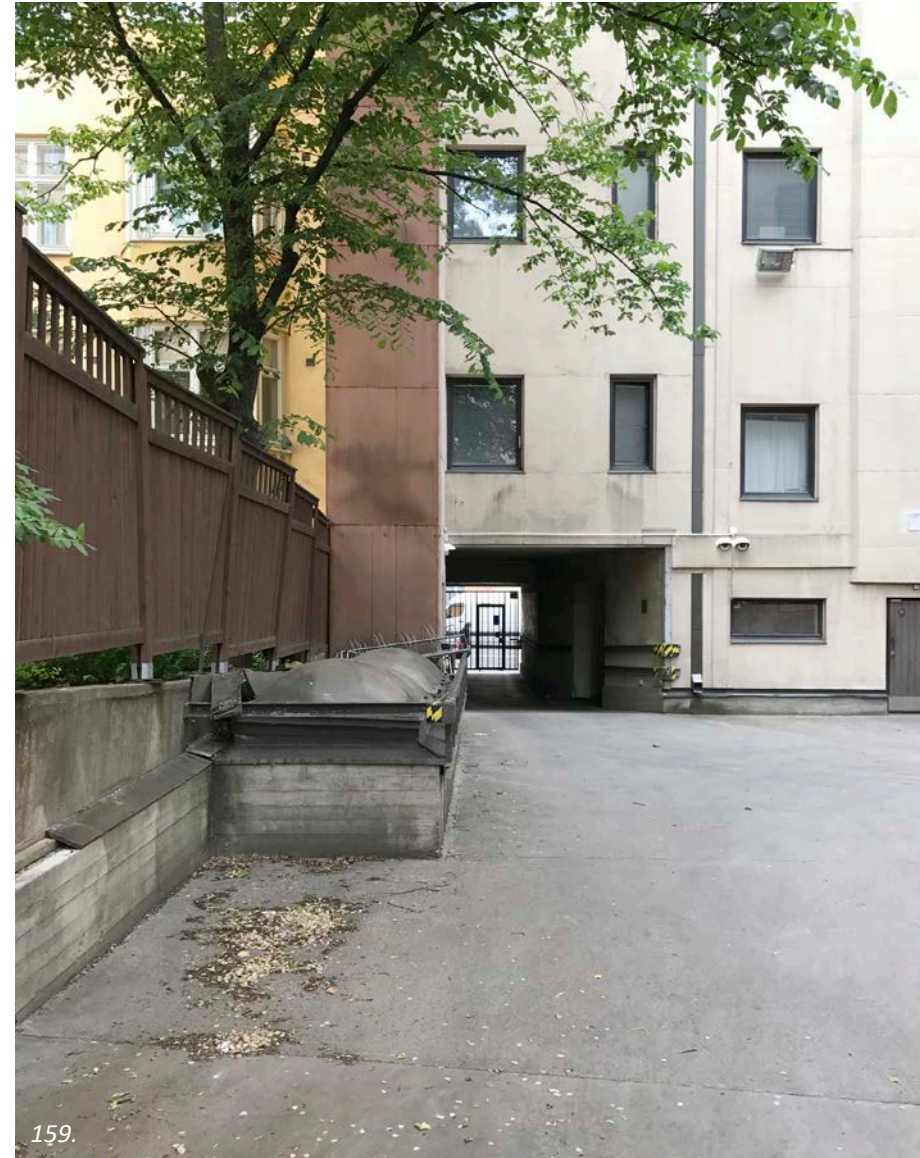
159. Kellarin kattokupuikkunat on varustettu törmäyssuojin, samoin ajokäytävä.
