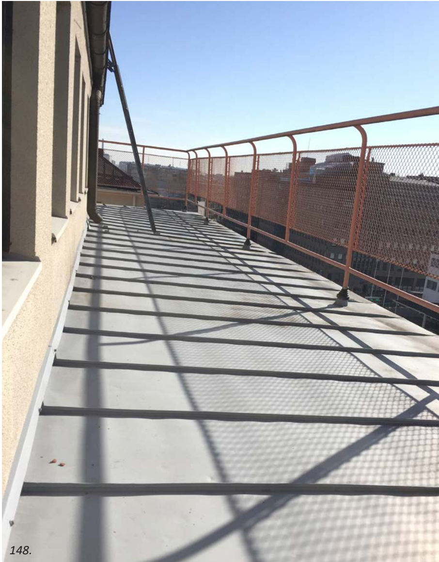
148. Kattoterassin peltikate on Pohjoisen Rautatiekadun puolella maalattu harmaaksi. Kaide on alkuperäinen mutta huoltomaalattu.
