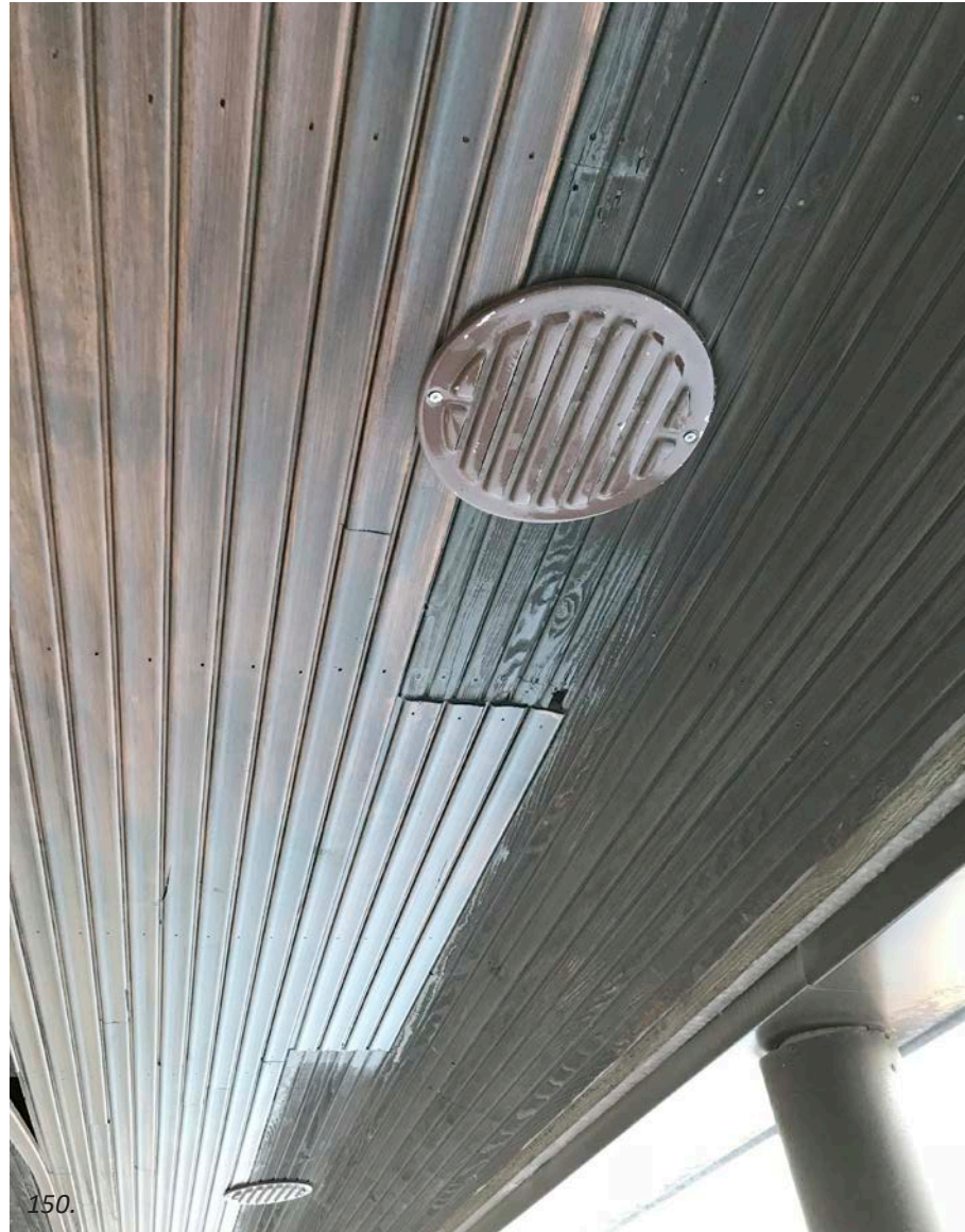
150. Seitsemännessä kerroksessa on paikkailtu räystäään alapinnan rimoitusta.
