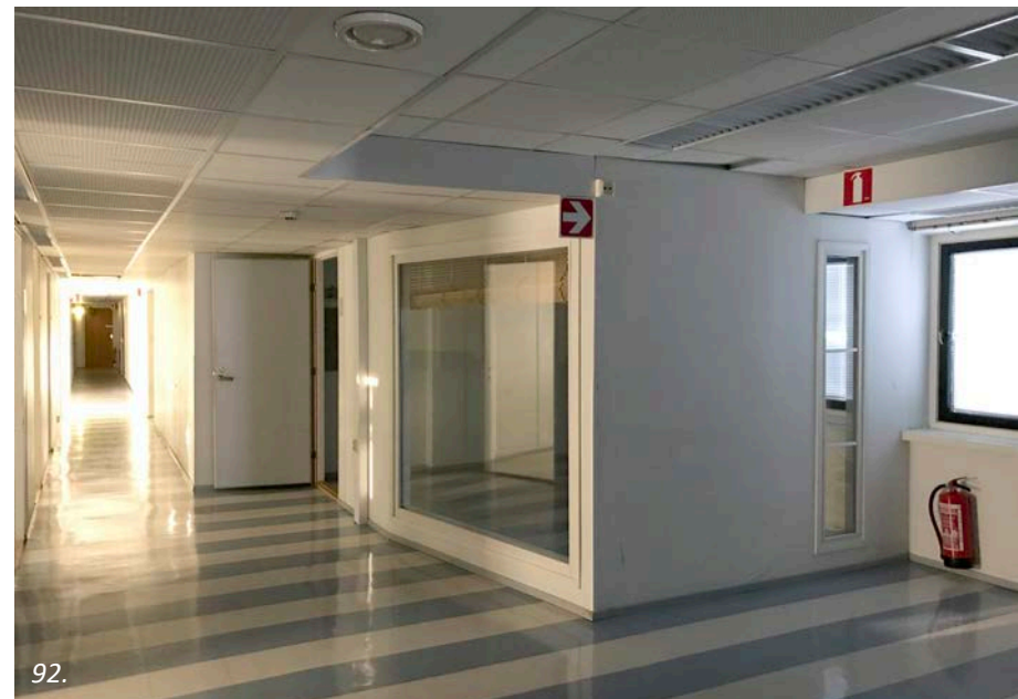
91. ja 92. Vanhana ullakkona seitsemäs kerros on muita kerroksia matalampi. Lattiat on pääsääntöisesti päällystetty muovipohjaisilla laatoilla.
