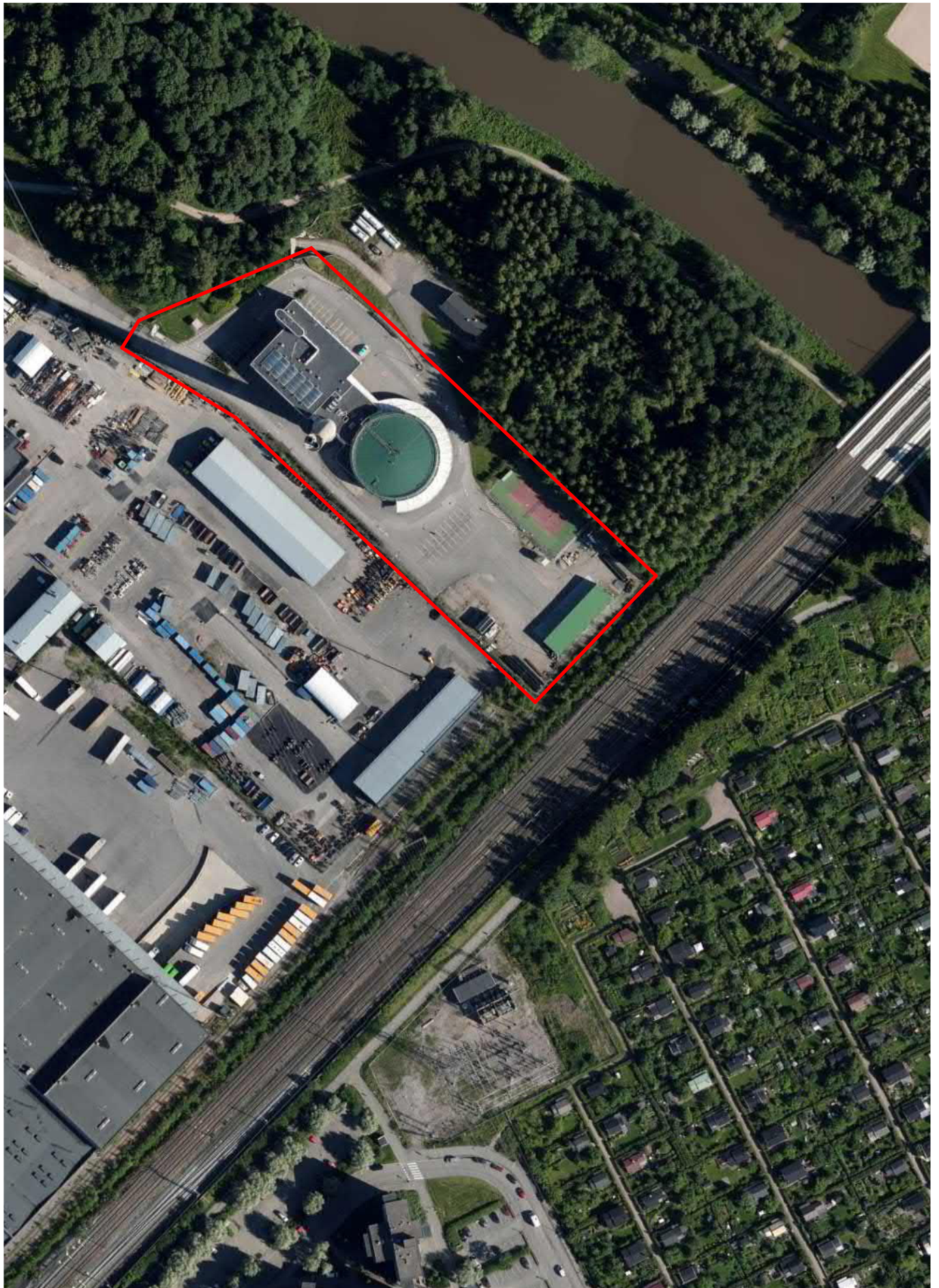
Ilmakuva Oulunkylä Lämpökuja 6
