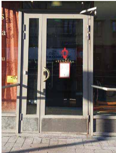
Ravintolan itäinen sisäänkäyntiovi on täysin moderni..
