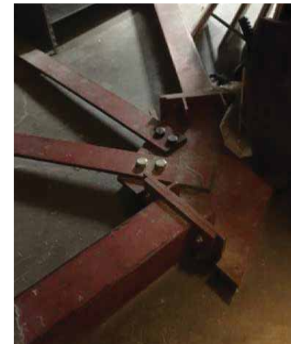
Ullakon käyttöönottamisen mahdollistamiseksi on rakenteita vahvistettu teräksin.
