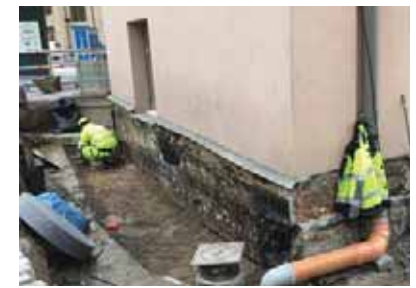
Päädyn vanha ikkuna (ei alkuperäinen). Veturitallia kohti sokkeli on tiiltä, se on alun perin ollut väliseinää, ei ulkoseinää kannattamassa.
