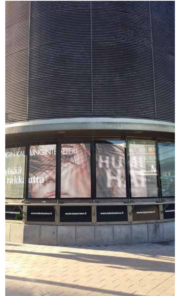
Alkuperäistä ja uutta sokkeliä. Alkuperäisestä on jäljellä enää ylin osa, sillä maantaso on vuosien kuluessa noussut rakennuksen ympärillä.
