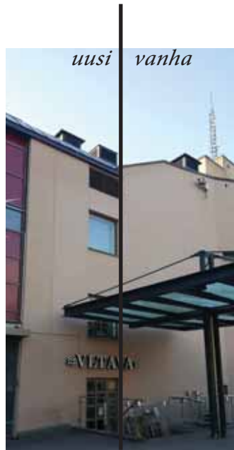
Bussikatos ulottuu rakennukseen. 90-luvun ikkuna valepuitejaolla.
