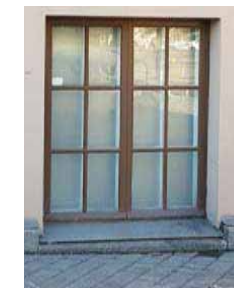
Päädyn vanha ikkuna (ei alkuperäinen). Veturitallia kohti sokkeli on tiiltä, se on alun perin ollut väliseinää, ei ulkoseinää kannattamassa.
