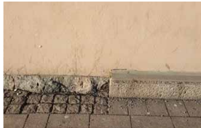
Alkuperäistä ja uutta sokkeliä. Alkuperäisestä on jäljellä enää ylin osa, sillä maantaso on vuosien kuluessa noussut rakennuksen ympärillä.
