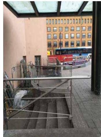
Huoltosyvennys, josta on myös käynti ravintolaan. Maasto on noussut alkuperäisestä
