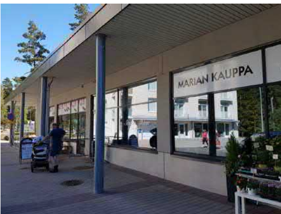
Vuosaaren pohjoisen ostoskeskuksen laajennus rv. 2016
