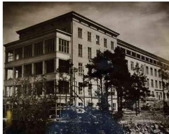
Tuberkuloosisairaalan rakennustyömaa vuonna 1929. (Arkkitehtuurimuseo)
