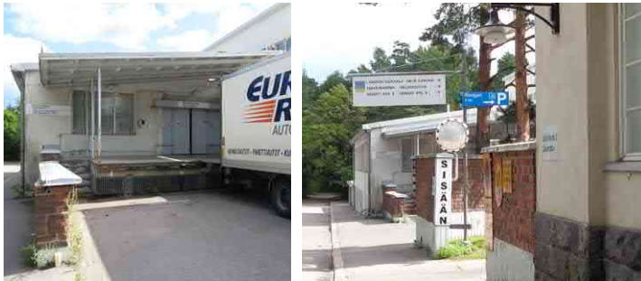
1. Vanha muuri autotallilta kappelin portille asti on poistettu. Sen tilalle on tullut tiilimuuri, jossa uusi sisäänkäynti ja keittiön huoltopiha.
