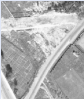
Reijolankatu rakenteilla. Läntisen Viertotien itäpuoli vielä viljelysmaata ja Urheilukadun pohjoisosa rakentumatta.
