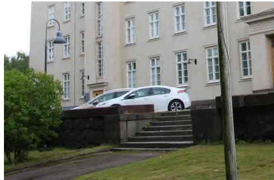
Laakson sairaalan sisäänkäynti nykytilassaan. Kulkureitti on asfaltoitu ja kukkaistutukset ovat hävinneet. Pensaita ja puita on huomattavasti alkuperäistä vähemmän. Lipputankoja sekä lyhtypylväitä on lisätty.
