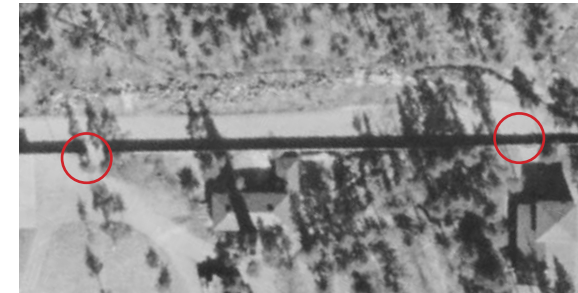
2.—3. Omat sisäänkäynnit autotallille ja lämpökeskukselle sekä kappelille vuonna 1932.
