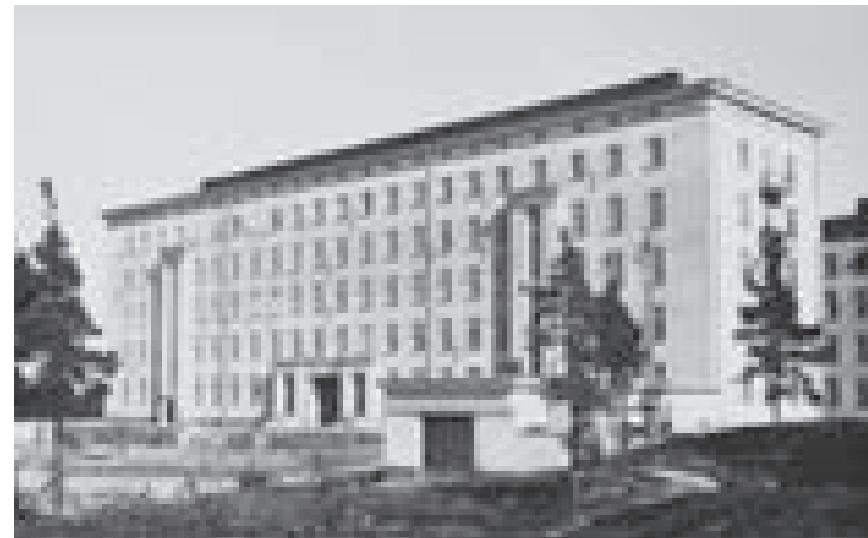
Tuberkuloosisairaalan hallintorakennus (L1) ja edustalla toinen autotalli (nyk. purettu) vuonna 1973. (MVKa)
