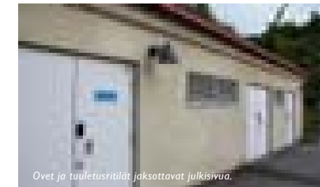
Ovet ja tuuletusritilät jaksottavat julkisivua.
