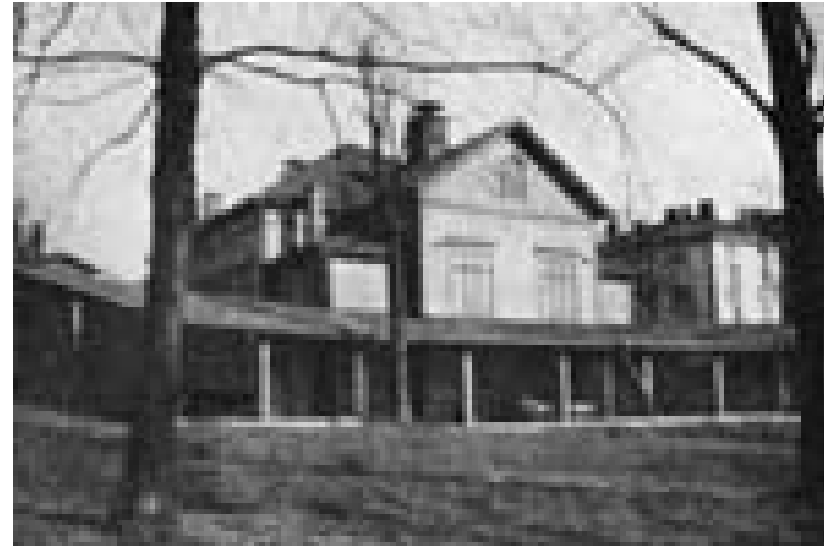
Marian sairaalan tuberkuloosipaviljongin ulkomakuuhalli. (Kuva julkaisusta Helsingfors stads tuberkulossjukhus)
