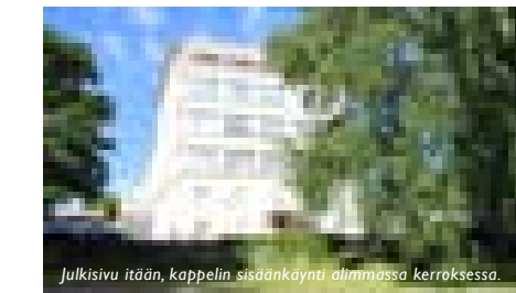
Julkisivu itään, kappelin sisäänkäynti alimmassa kerroksessa.
