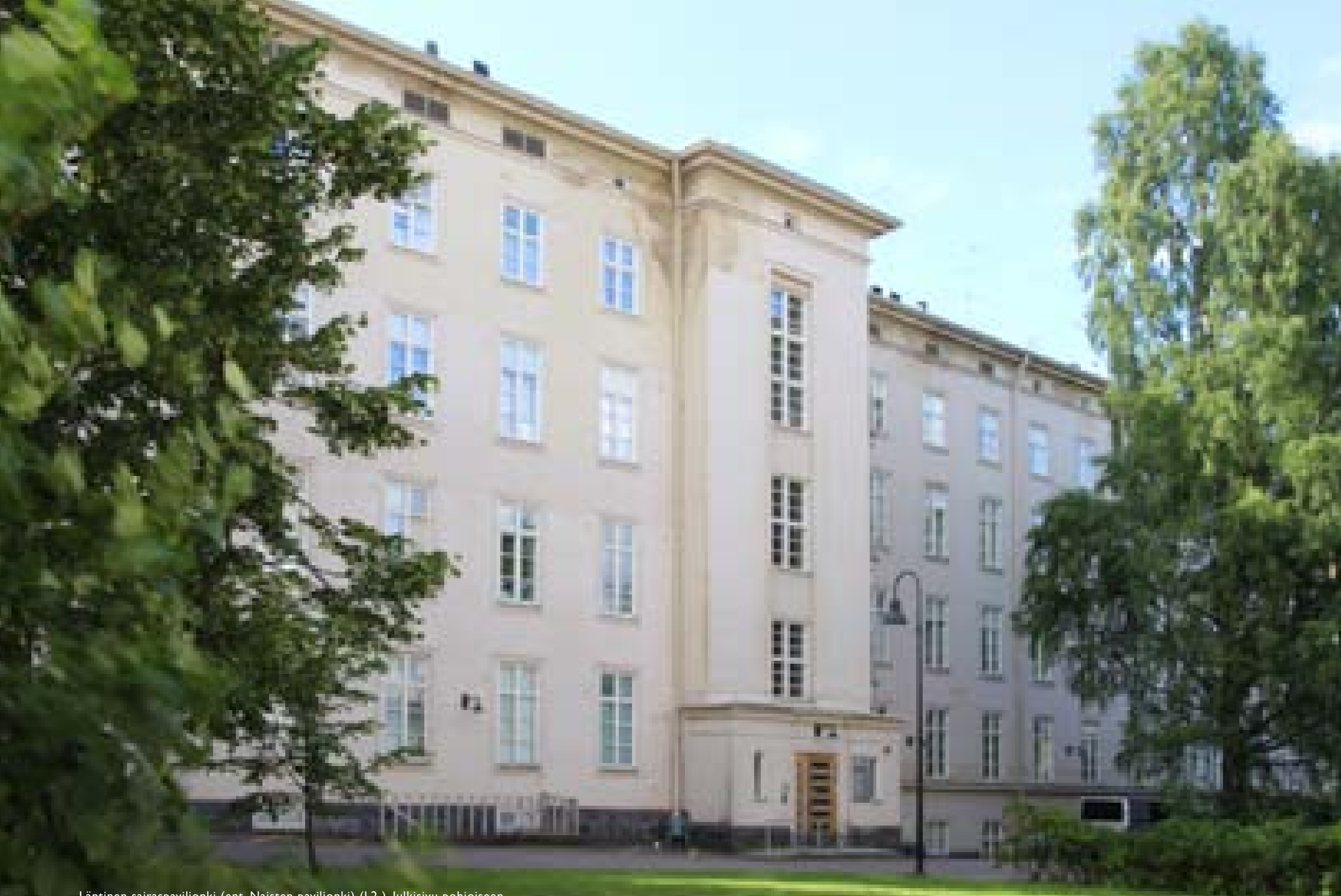
Läntinen sairauspaviljonki (ent. Naisten paviljonki) (L2 ). Julkisivu pohjoiseen.
