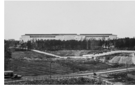
Näkymä etelästä kohti Laakson sairaalaa vuonna 1929. Etualalla Nordenskiöldinkadulla kulkeva raitiovaunu. (HKM)
