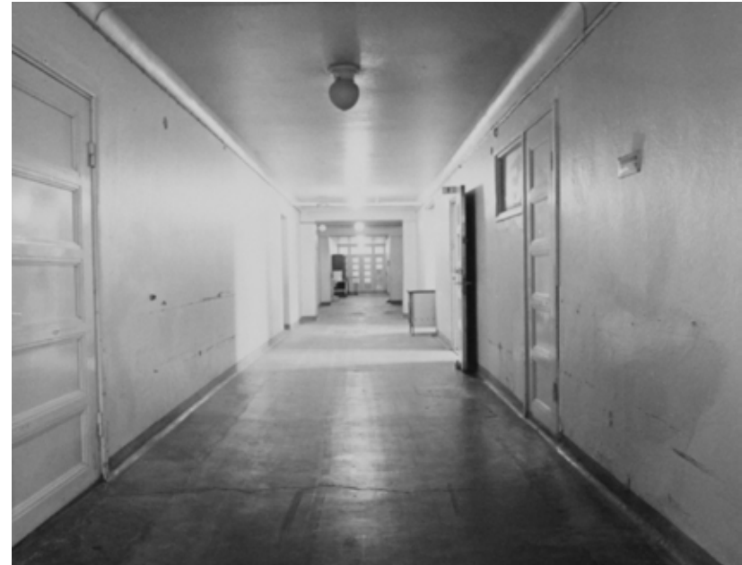
Läntinen tunneli (kellari) 1970-luvulla ennen peruskorjausta. (LSA)
