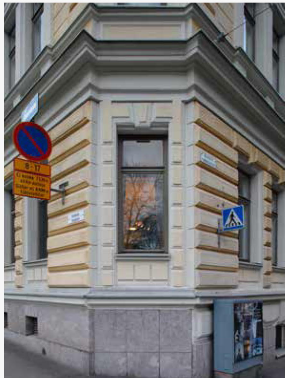
7. Kulmatalon etelänurkan alkuperäinen ikkuna muutettiin 1920-luvulla sisäänkäyntioveksi ja molemmat puolet ikkunat suurennettiin näyteikkunoiksi. Julkisivu palautettiin myöhemmin alkuperäiseen asuun.
