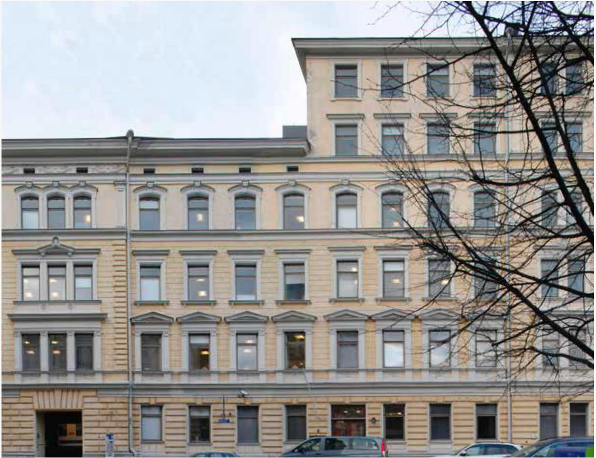
8. Ratakadun siipi rakennettiin kiinni kulmarakennukseen.
