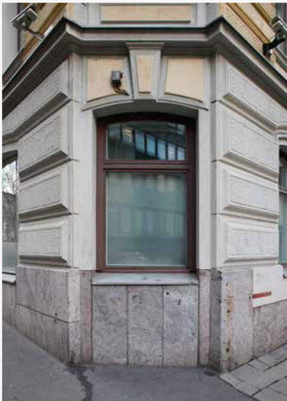
6. Kulmatalon pohjoisnurkan pohjakerroksen asuntoon oli alunperin oma sisäänkäyntiovi. Ovi muutettiin ikkunaksi 1975.
