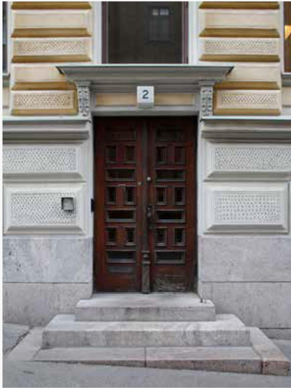
4. Kulmatalon entinen pääsisäänkäynti Yrjönkadulla. Ovi on todennäköisesti 1930-luvulta.
