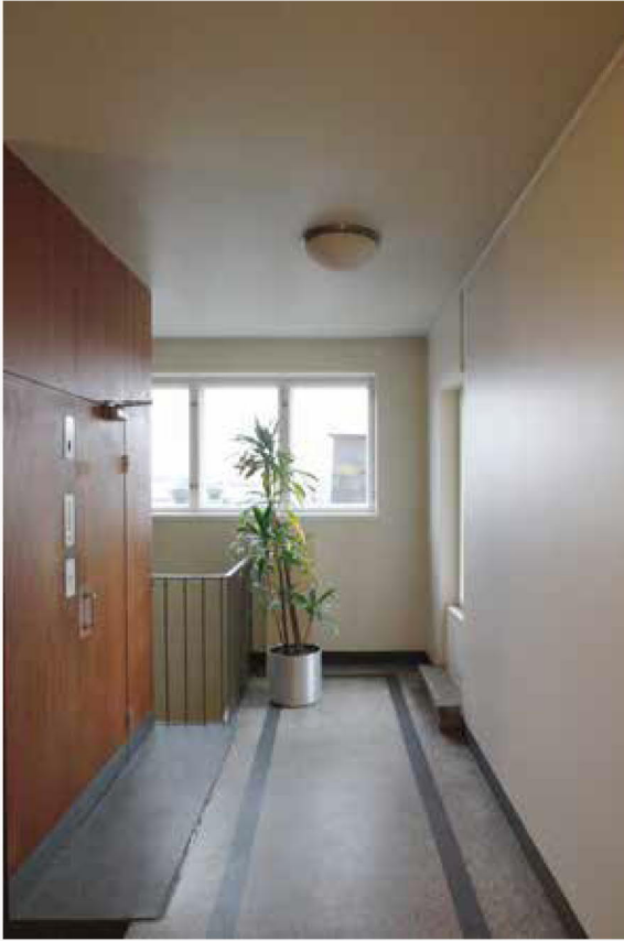
40. Kulmatalon pääportaan hissi ja portaat jatkettiin 5. ja 6. kerrokseen 1930-luvulla.
