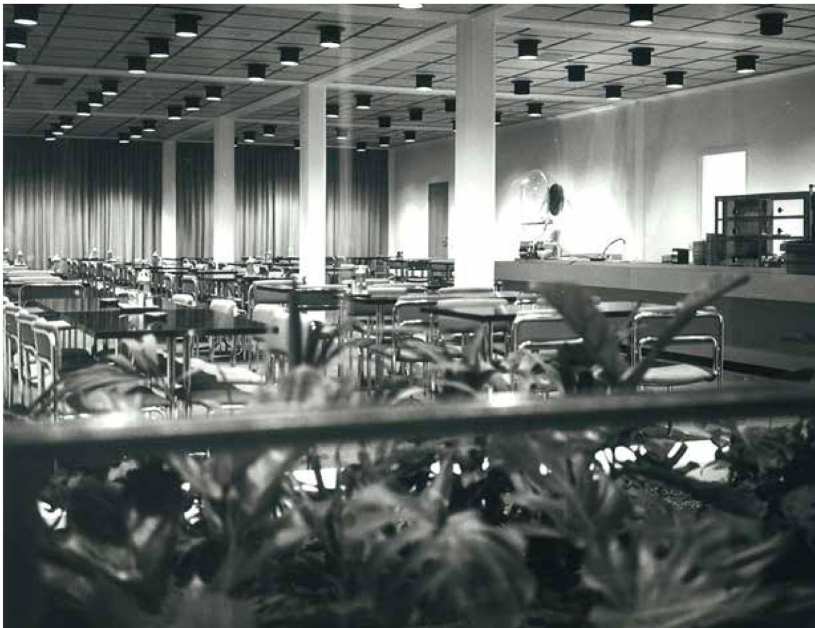
Kellarin ruokailutila peruskorjauksen jälkeen vuonna 1977. Kuva:Aimo Kokkosen kuva-arkisto.
