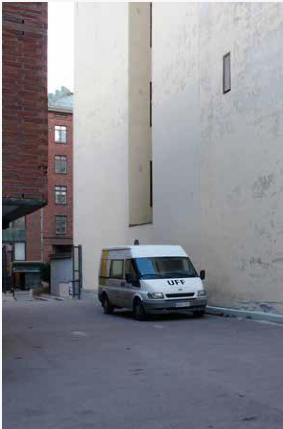
17. Piharakennuksen umpinainen takajulkisivu.
