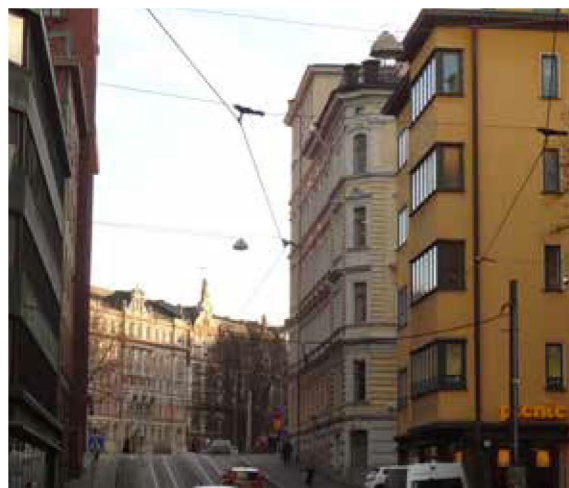
Näkymä Yrjönkadulta kohti kaakkoa joulukuussa 2014. Alueen rakennukset ovat hyvin eri-ikäisiä. Kadun päätteenä näkyy Korkeavuorenkatu 21:n koristeellinen uusrenessanssitalo (arkkitehti Axel Högberg, 1888). Ratakatu 3 (1888-1890) sijaitsee loivassa rinteessä Yrjönkadun länsipuolella (oikealla). Sen tummankeltainen naapuri Yrjönkatu 4/Iso Roobertinkatu 2 valmistui vuonna 1938 (arkkitehti Ole Gripenberg). Kuvan vasemmassa laidassa näkyvä rakennus valmistui 1963 (arkkitehti Pauli Lehtinen). Kuva: ark-byroo.
