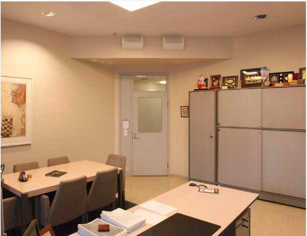
18. Kulmatalon toisen kerroksen kulmahuone. Oven yläpuolella näkyy myöhemmin rakennettu ilmanvaihtojärjestelmä.
