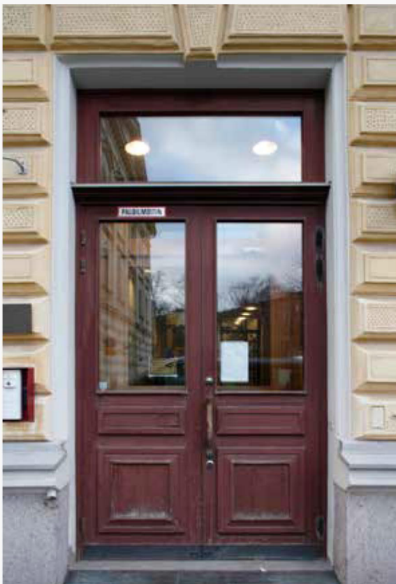
9. Uusi pääsisäänkäynti rakennettiin Ratakadulle vuonna 1975. Nykyinen ovi on 1980-luvulta.
