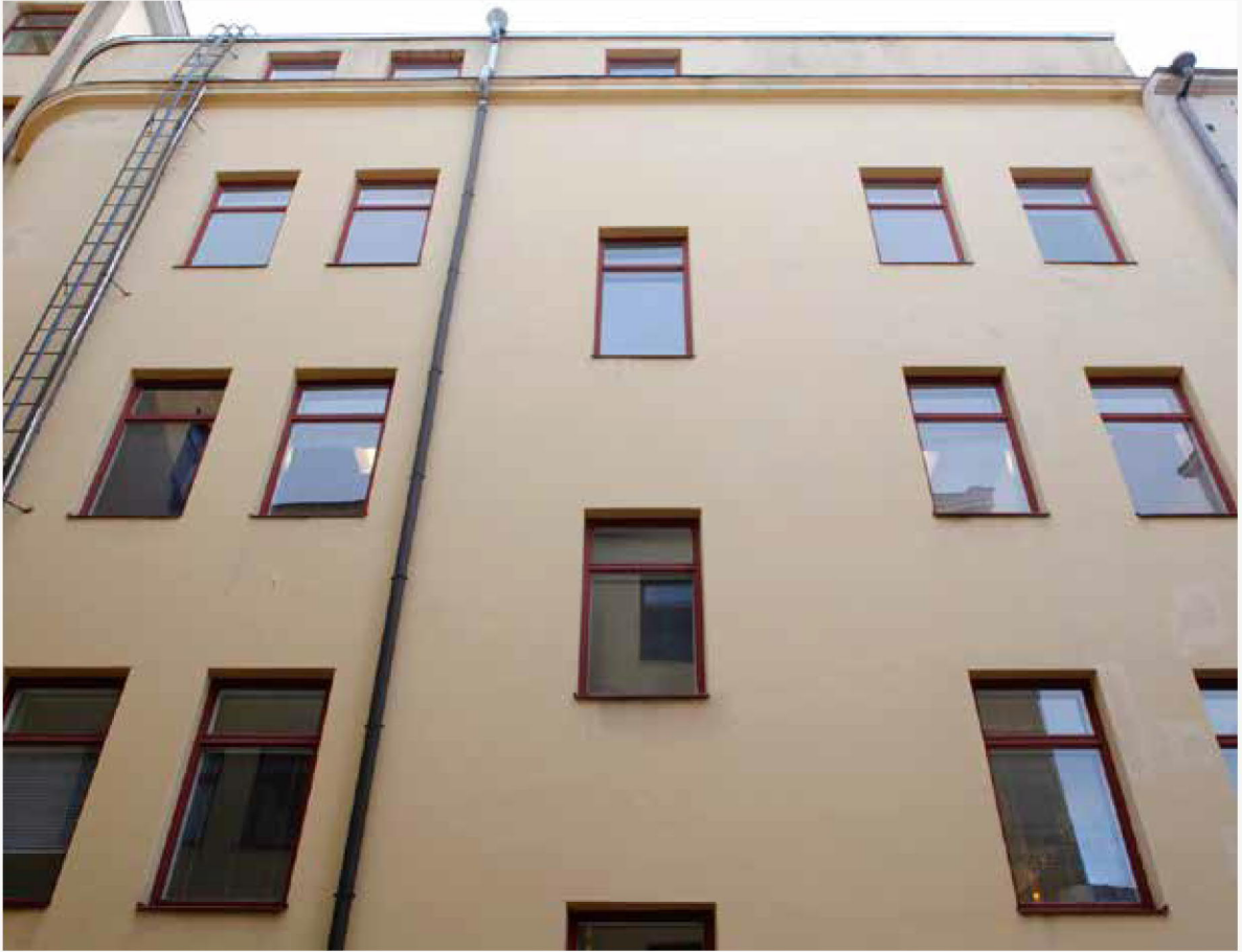
13. Ratakadun siiven pihapuoleisen vesikaton lapetta korotettiin 1970-luvulla.
