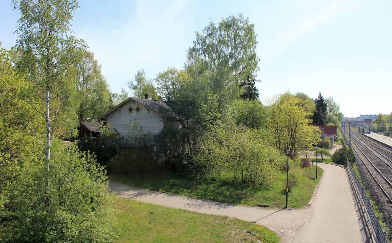
Kuva 55. Näkymä lähiliikenteen laiturille johtavalta kävelysillalta kohti kaksoisvahtituvan mäkeä.
