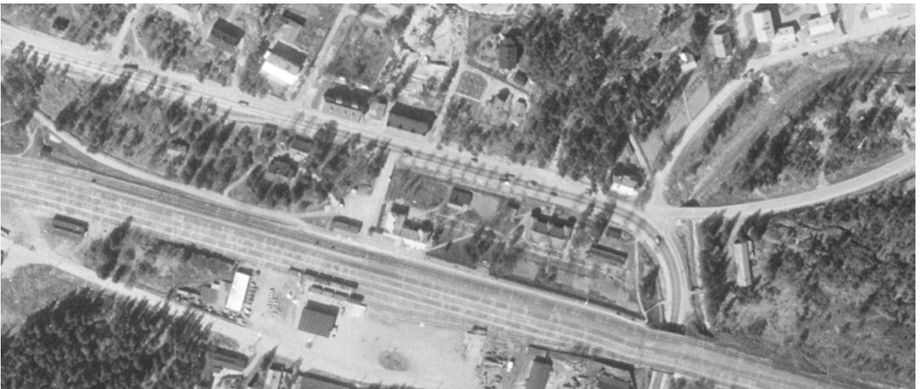
Kuva 24. Ilmakuva 1956. Vesijohtotyöt käynnissä asemapuistossa.
