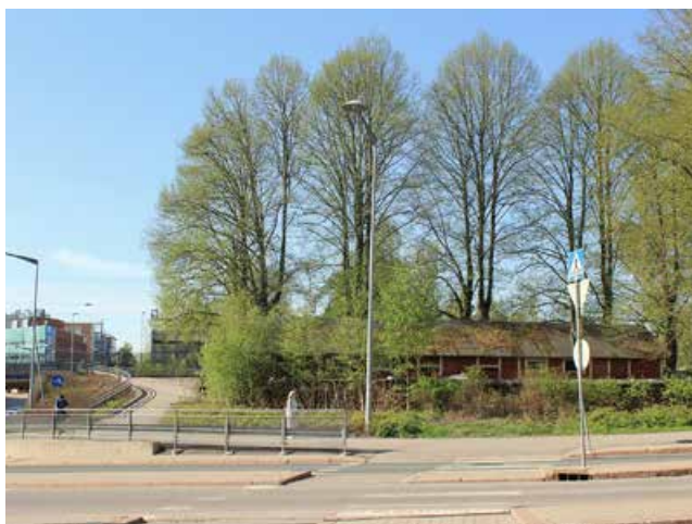
Kuva 52. Asuinkasarmen vanha talousrakennus asema-alueen itäpäässä, Pitäjänmäentien kurvissa. Taustalla näkyy lehmuskujanne. Alueen rajalle on tehty halkopinoista rajaava muuri. Talousrakennuksessa sijaitsee asukkaiden autotallit.
