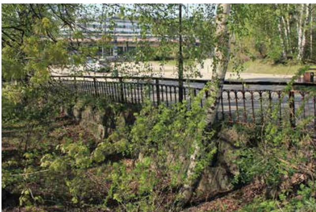
Kuva 60. Sisäänajotien pengermuuri on todennäköisesti peräisin 1910-luvun puolesta välistä, jolloin uusi sisäänajo otettiin käyttöön. Muurin päälle kiinnitetty metallinen aita lienee myöhempi.
