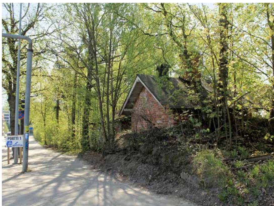
Kuva 74. Pitäjänmäentie on leventynyt asemapuistoon päin niin, että kaksoisvahtituvan mäen maakellari taustalle on syntynyt ikävä viimeistelemätön maaleikkaus. Puistoa rajannut hernepensasaidanne ei ole tässä kohtaa säilynyt.
