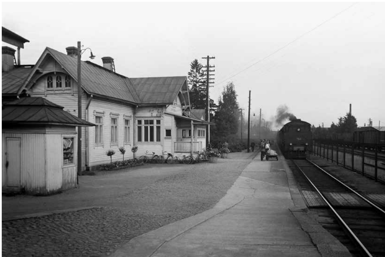
Kuva 30. Aseman edusta ennen kunnostustyön alkua vuonna 1958. Puistoa asemalaiturista rajannut ruusuaidanne kuvan keskellä. Asemalaituri ja asemarakennuksen edusta on ollut osin mukulakivetty. HKMKA.
