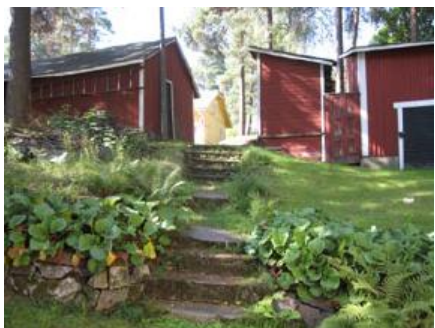
GRANELUND, TALOUSRAKENNUKSET, 2 KPL HEIKINNIEMENTIE 1
