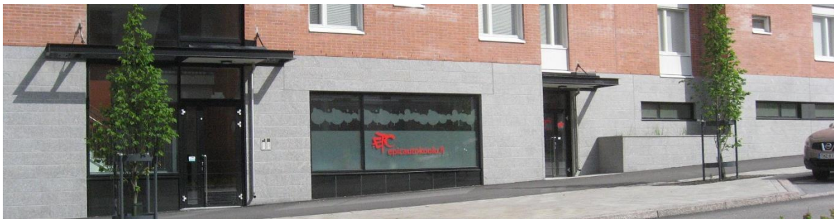
Pitkät ”tyhjät” seinätilat heikentävät kauppakadun tunnelmaa ja kokonaisuuden vetovoimaisuutta
