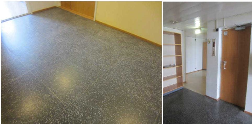
4. ja 5. kerroksen aulojen mosaiikkibetonilattioita (AAM / Malmberg).
