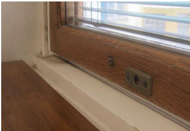
Myös säilyneiden ikkunoiden kilvet ja painikkeet on uusittu (AAM / Malmberg).
