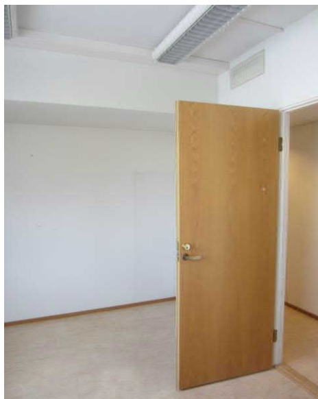
Ilmanvaihdon sisäänoton alaslaskuja toimistohuoneissa, säleikköjä on asennettu ulkoseinään ja ikkunoiden tuuletusluukun kokoa pienentämällä (AAM / Malmberg).
