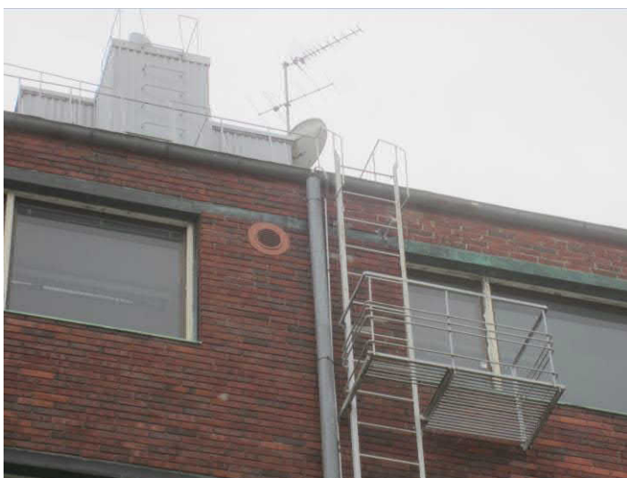
Pihajulkisivulla on alkuperäiset varatietikkaat. Tikkaiden vasemmalla puolella on uusi ilmanvaihdon säleikkö, joka lienee lisätty 1997 (AAM / Malmberg).
