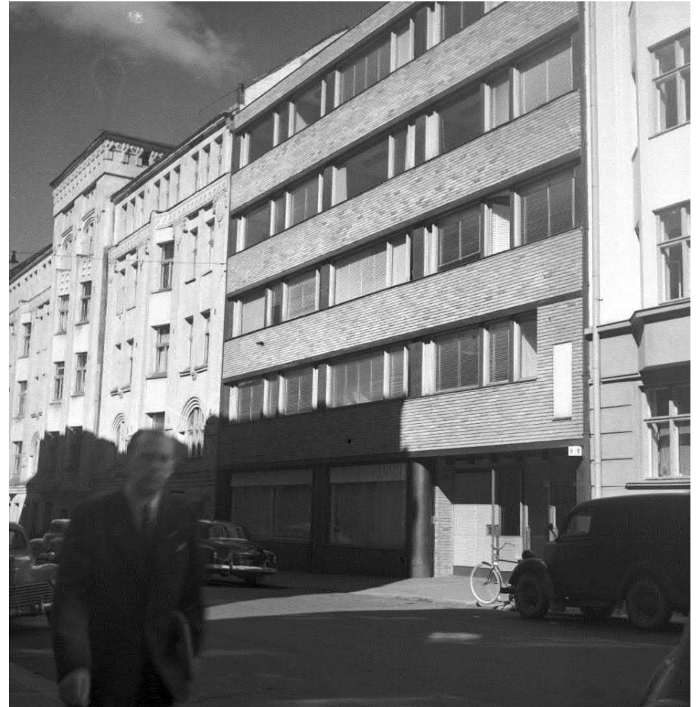
Insinööritalo alkuperäisasussaan (AAM 100929 / Eino Mäkinen).
