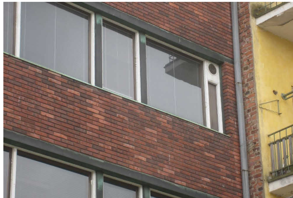
Pihajulkisivujen tiilet ovat alkuperäisiä, reunimmaisissa ikkunoissa olevat pyöreät säleiköt on lisätty ilmanvaihdon perusparannuksen yhteydessä 1997. Ikkunoiden väleissä ja yläpuolen palkeissa on hienosti patinoituneita kuparipeltejä (AAM / Malmberg).
