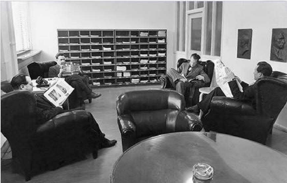
Lehtihuone toisessa kerroksessa väliseinäkkuinoineen ennen uuden portaan rakentamista (www.tek.fi).
