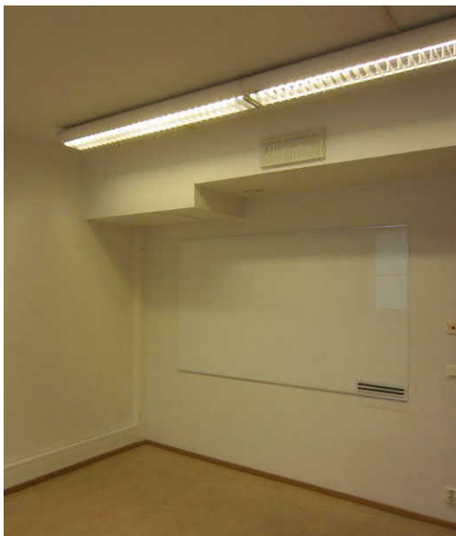
Toisen kerroksen työhuone huhtikuussa 2016 vuoden 1997 alaslaskuineen ja sähköasennuksineen, loistevalaisinten pintajohdotus ei vastanne alkuperäistä asennustapaa. WC:n ulkoasu lieenee vuodelta 1997 (AAM / Malmberg).
