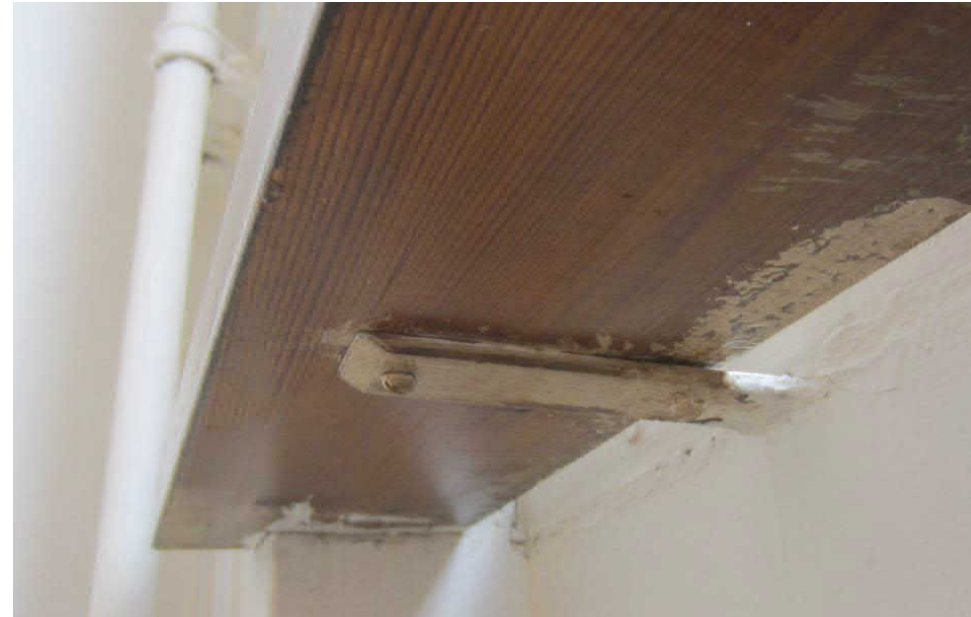
Alkuperäisiä ikkunalaudan kannakkeita on säilynyt säilyneiden ikkunoiden yhteydessä, puuosissa on huomattavan iäkkäitä ja uudehkoja (AAM / Malmberg).
