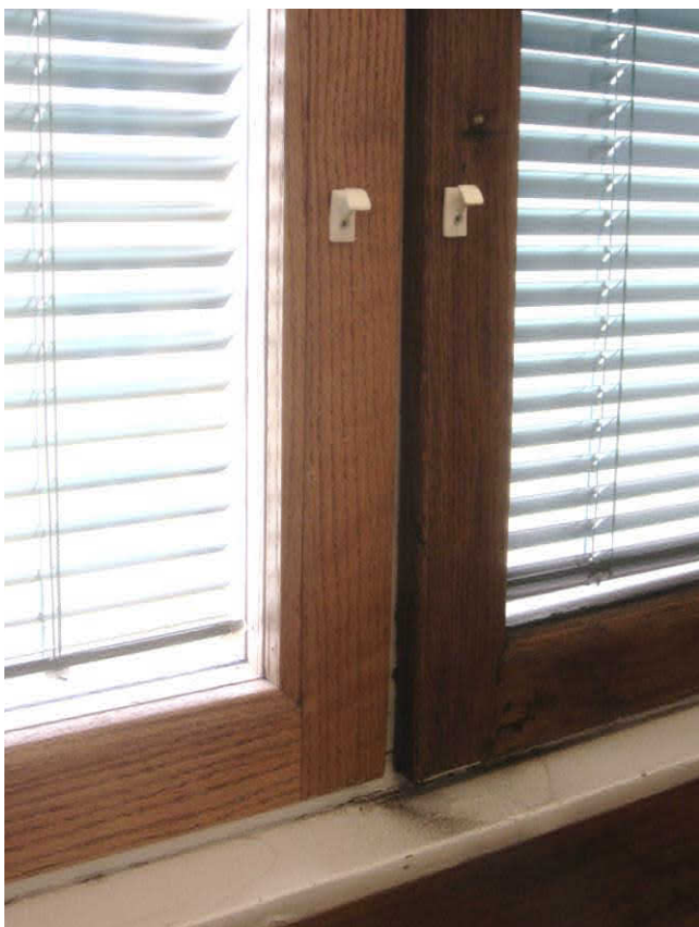
Samassa ikkuna-aukossa sekä uusittu että alkuperäinen puite (AAM / Malmberg).
