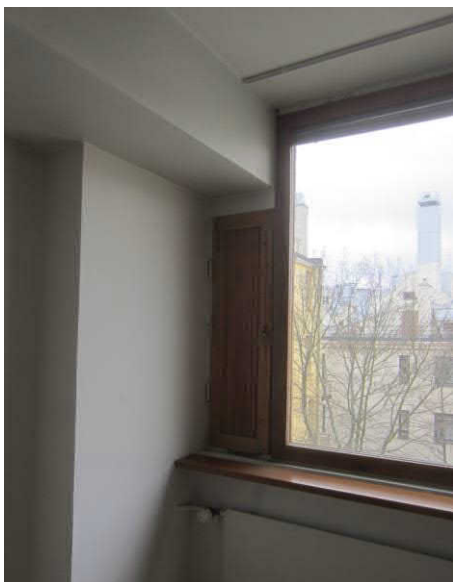
Ilmanvaihdon sisäänoton alaslaskuja toimistohuoneissa, säleikköjä on asennettu ulkoseinään ja ikkunoiden tuuletusluukun kokoa pienentämällä (AAM / Malmberg).
