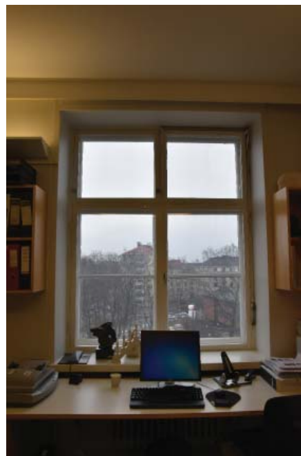
Säilynyt alkuperäinen ikkuna, jossa on tuuletusta varten oleva ns. terveysikkuna eli ala- ja yläsaranoitu yläikkuna.
