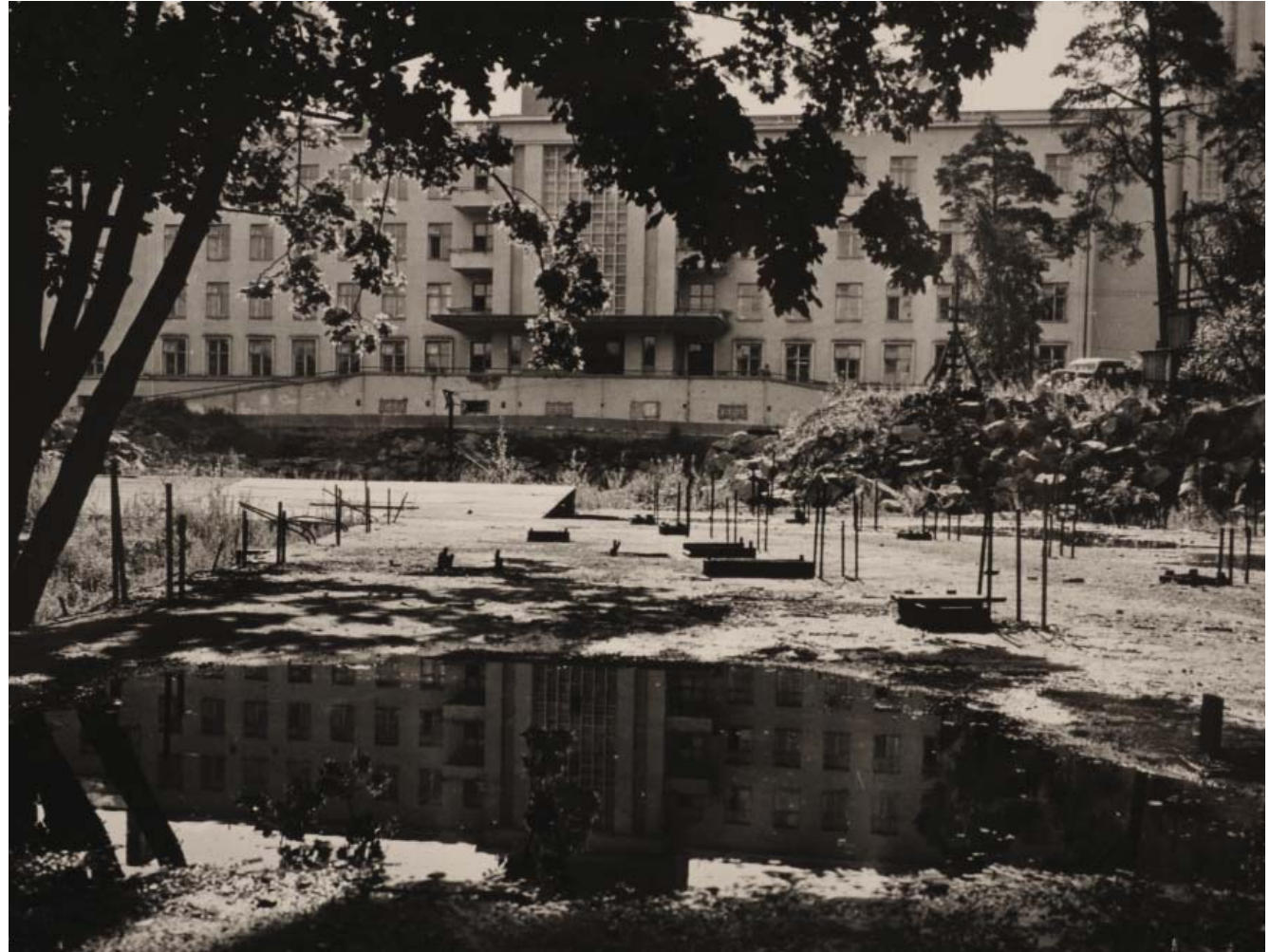
Reumasairaalaa varten rakennetut perustukset seisoivat vuosikausia paikalla ilman, että rakennustyö eteni. TSA.
