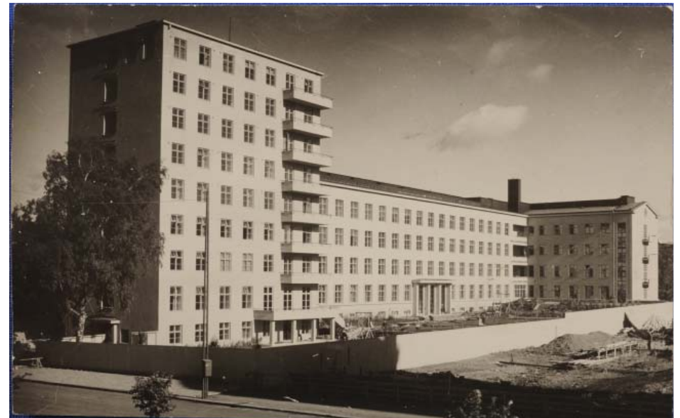
Vastavalmistunut sairaala. Pihatyöt ovat vielä kesken. TSA.
