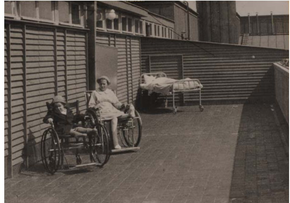
Kattoterassi puutarhan puoleisella katon lappeella rakennettiin asunnoiksi vuonna 1951. TSA.
