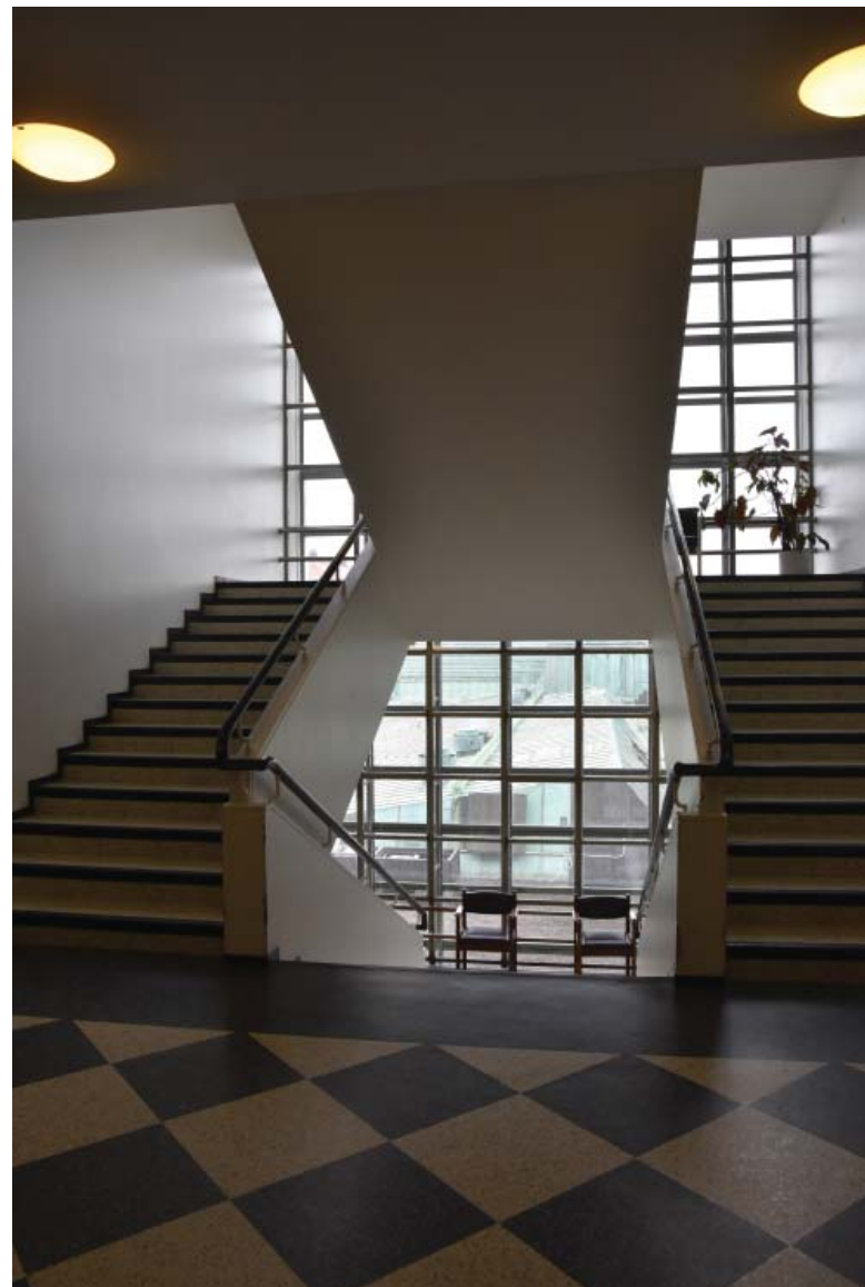
Pääporras nykyisin. Shakkiruudutettu kumimatto on korvattu shakkiruudutetulla muovimatolla, jossa ruudut kulkevat vinoon.
