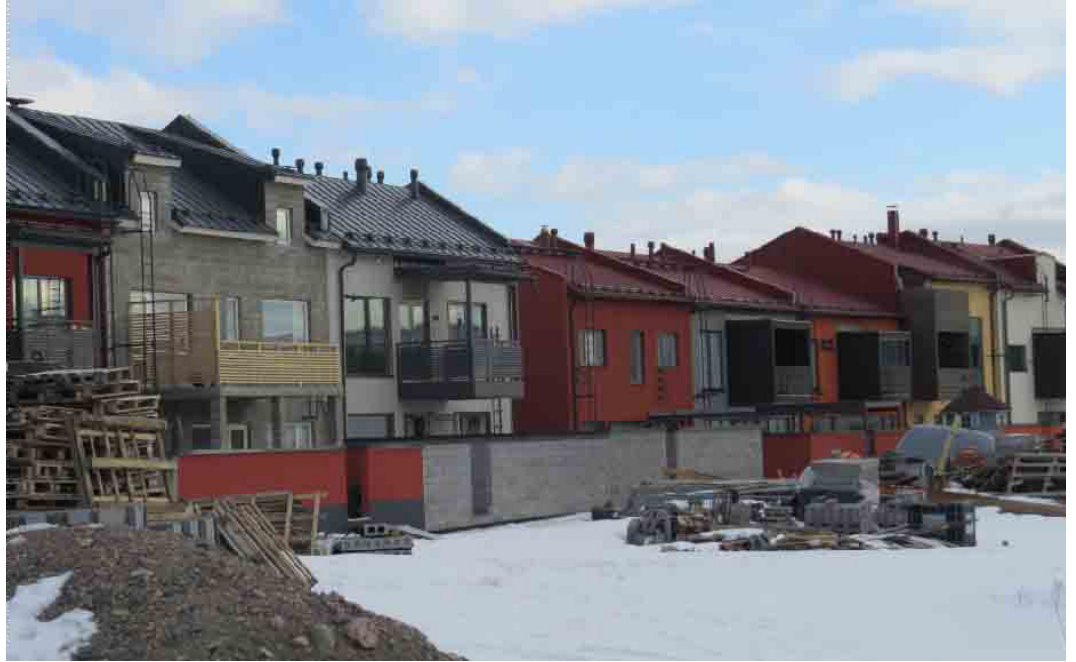
Kuva 94. Ormuspellon townhouse- rakentaminen on edelleen käynnissä.
