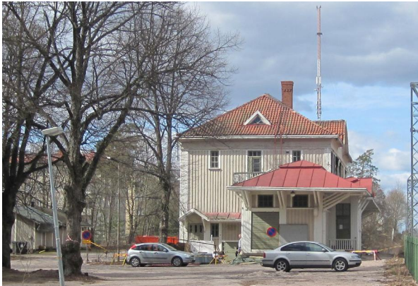
Asemarakennus pihapiireineen alikululta päin.
