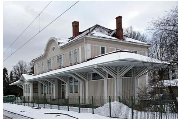
Asemarakennus, n. 1921 (tyyppiirustus 1914). sr-1.
