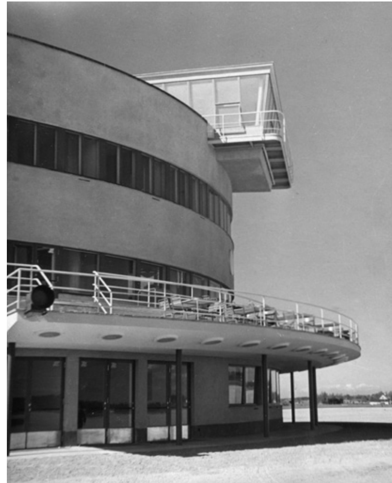
Ylhäällä: Terminaalin kentän puolelta. (Iffland / KA)
