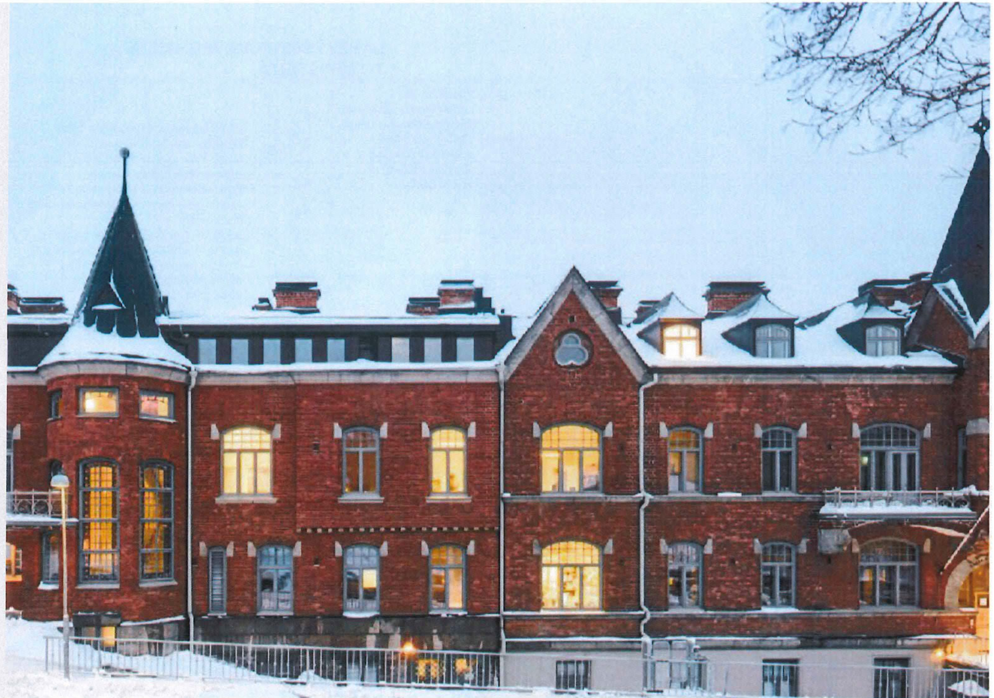
Katujulkisivu, 2014. kuvaaja Tuomas Uusheimo. O.
