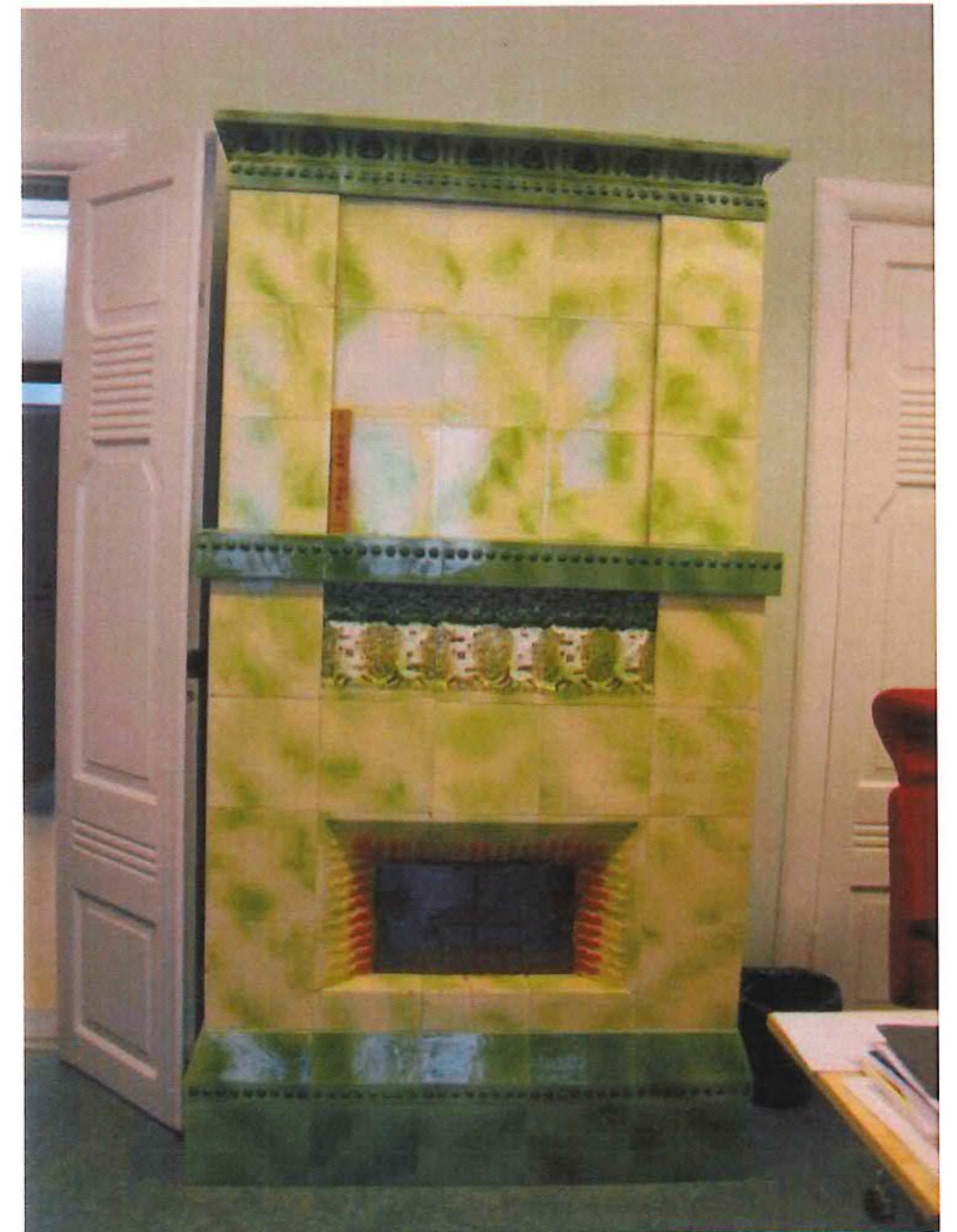
Kolmannen kerroksen toimistohuoneen säilynyt kakluuni (Tyyppi Koivu) Tämä on toinen säilyneistä tulisijoista. Kuva 2015 Marjaana Harjapää. O.
