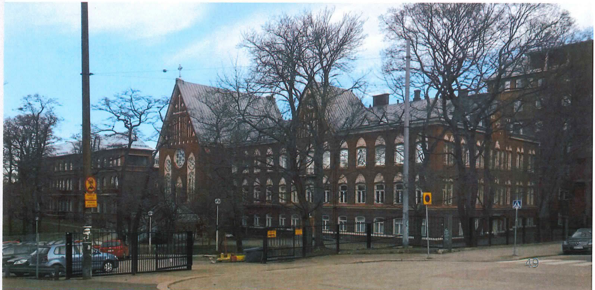
Helsingin diakonissalaitoksen kirkko, sisarkoti ja talousrakennus, K. A. Wrede, vuonna 1896. Kuva Marjaana Harjapää, 2015. O.
