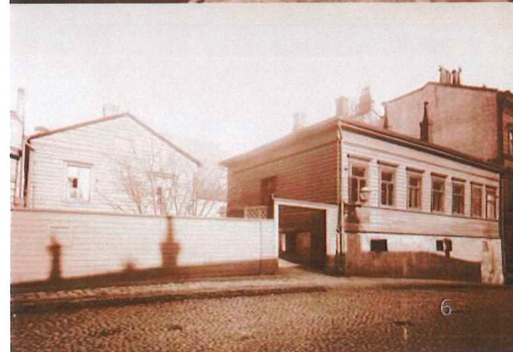
Vuorikatu 3. Lähetyskoulu toimi tässä rakennuksessa vuonna 1881. Kuva kadun puolelta. LSK.
