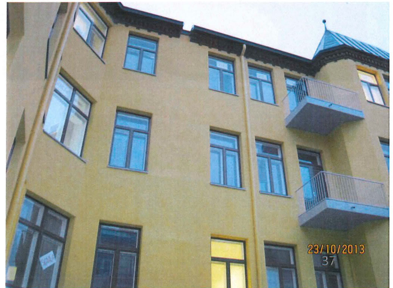
Tähtitorninkatu 18 sisäpihalta kuva, jossa näkyy mm. uusitut parvekkeet. Kuva vuodelta 2013 julkisivun korjaamisen jälkeen. Kuvaaja Jari Kukkonen, O.
