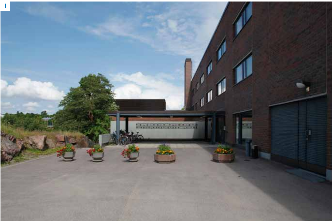
Näkymä kohti oikeuslääketieteen pääsisäänkäyntikatosta.
