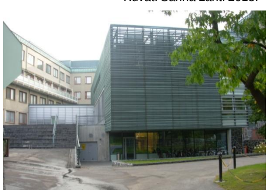
Lastenklinkan laajennus vuodelta 2010. Kuva: Sanna Lahti 2013.
